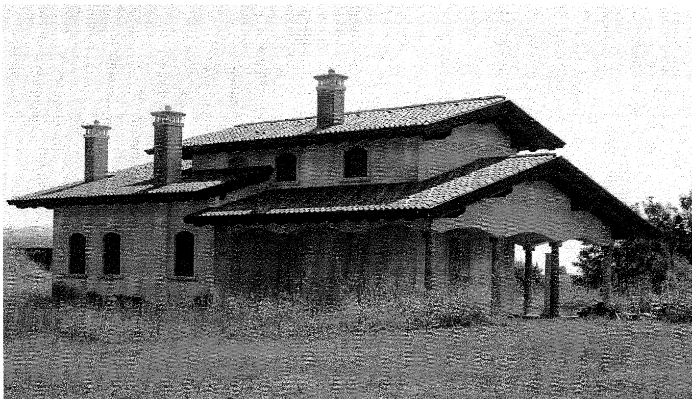
Foto 1.16 – vista da nord-ovest
