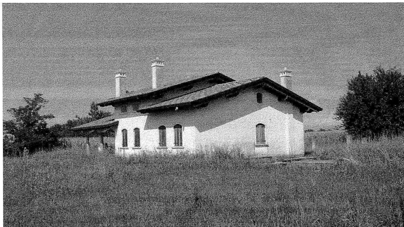
Foto 1.17 – vista da sud-est
