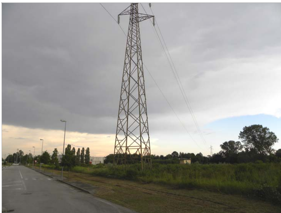
Industrie Mio Dino S.r.l.: terreno edificabile gravato da servitù Enel (traliccio) (mapp. 352)
