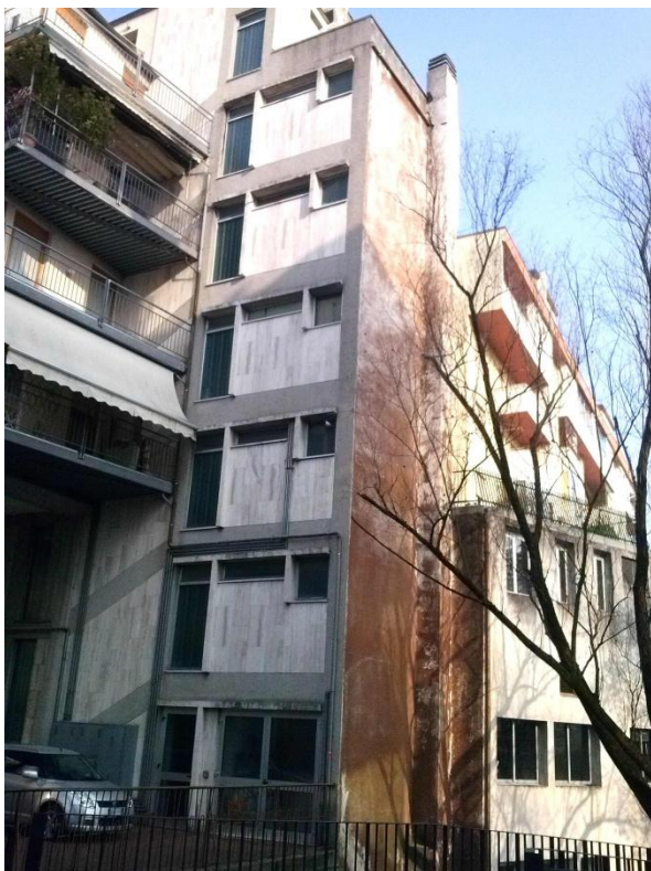
Allegato 04-g. Portico esterno su via Marconi
