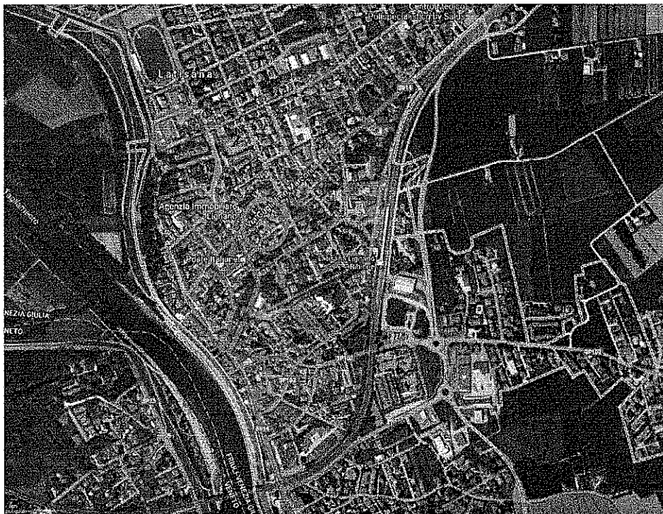
1. Ortofoto: localizzazione del complesso – Aerofoto generale
