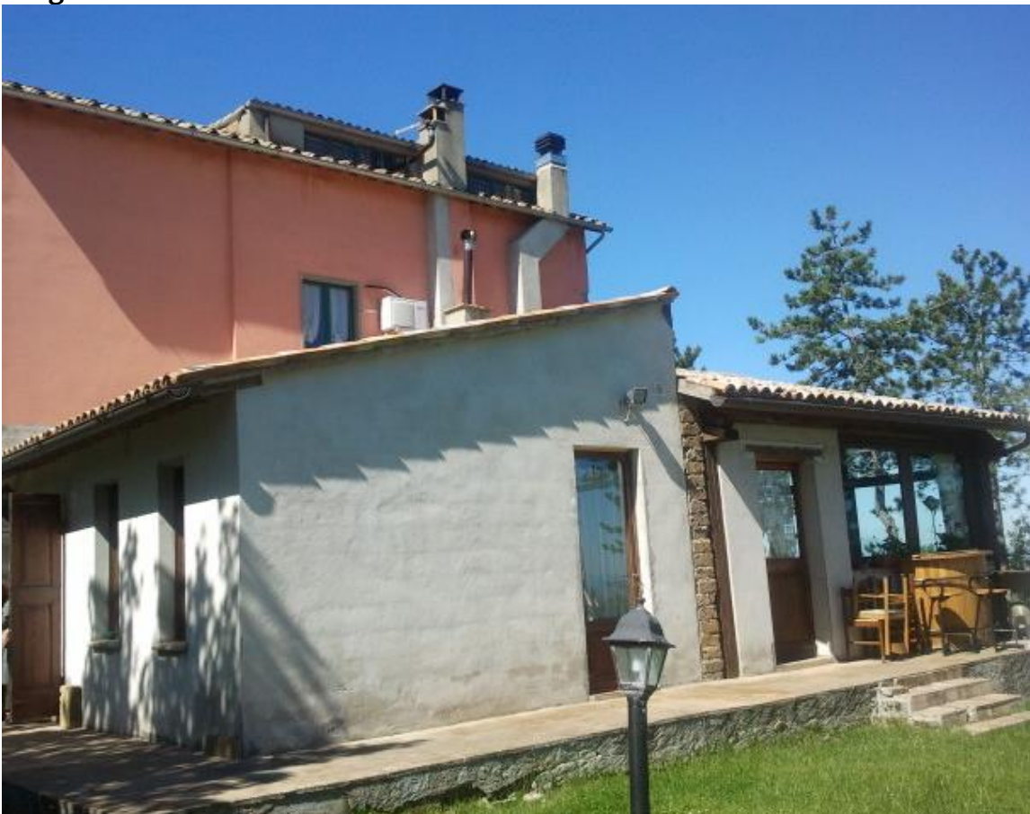
Ingresso posteriore nord est
