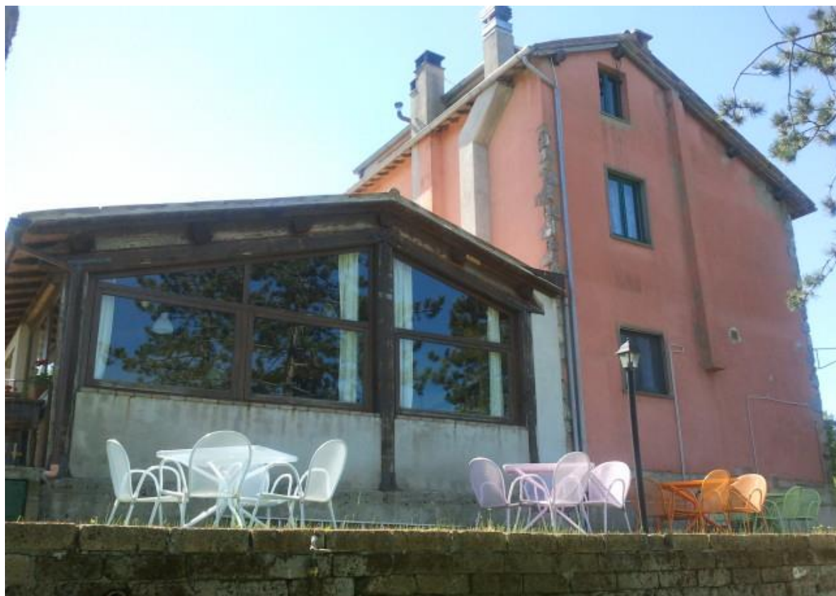
Lato nord ovest
