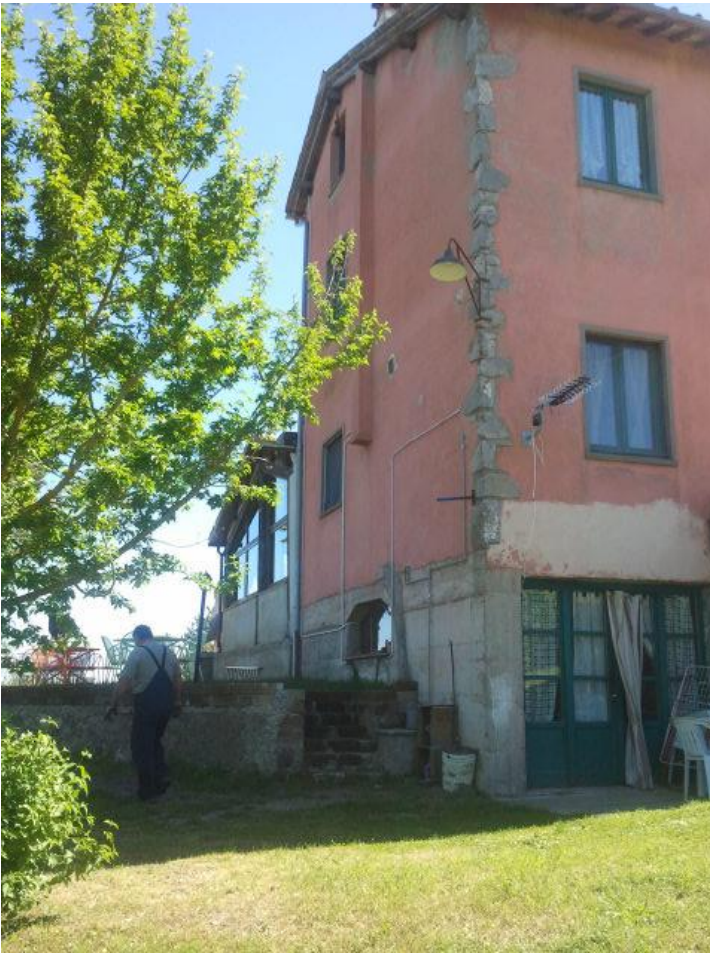
Lato nord ovest
