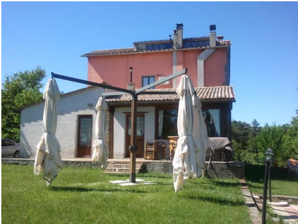
Ingresso posteriore lato no d est
