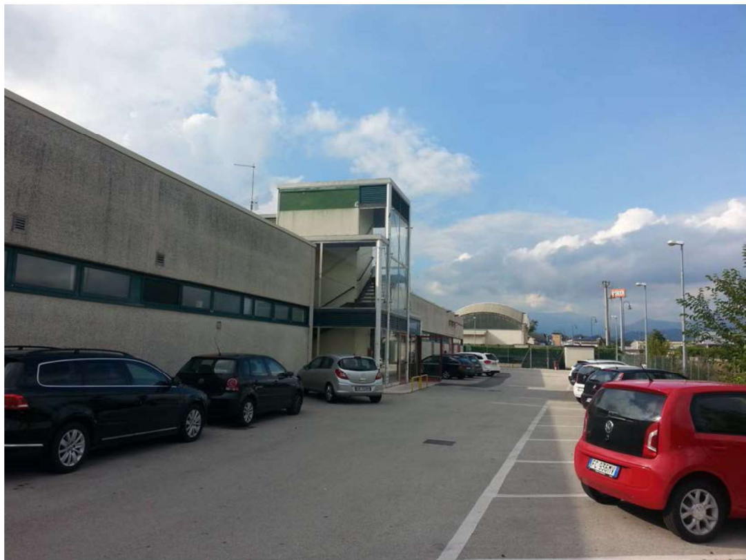
Vista Est – ingresso secondario
