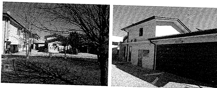
Vista delle pertinenze
