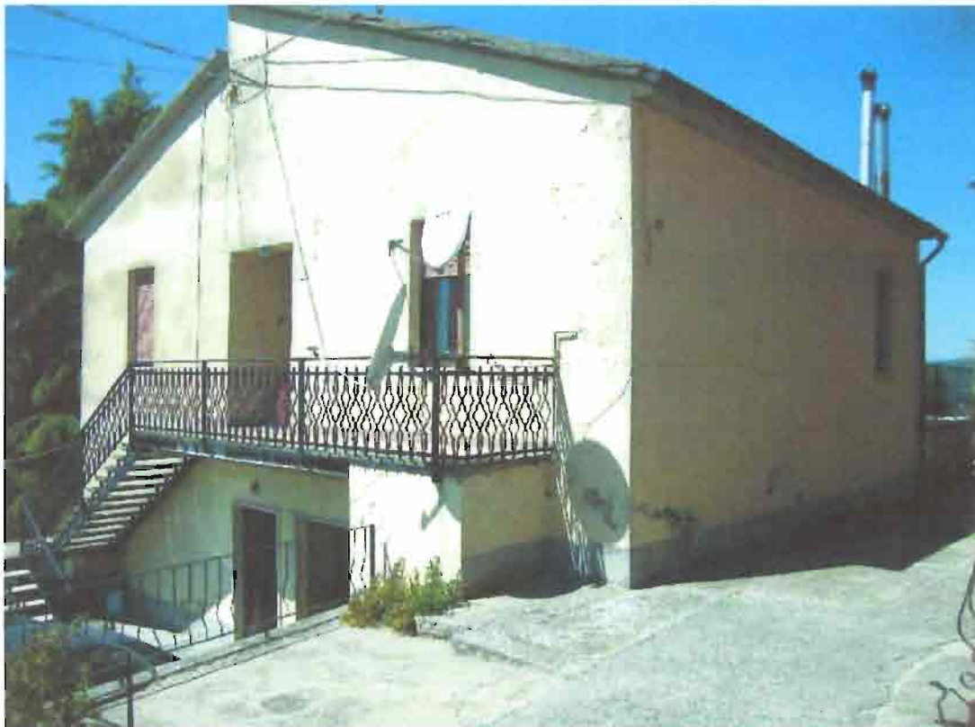
Illustrazione 2: Prospetto lato nord-est
