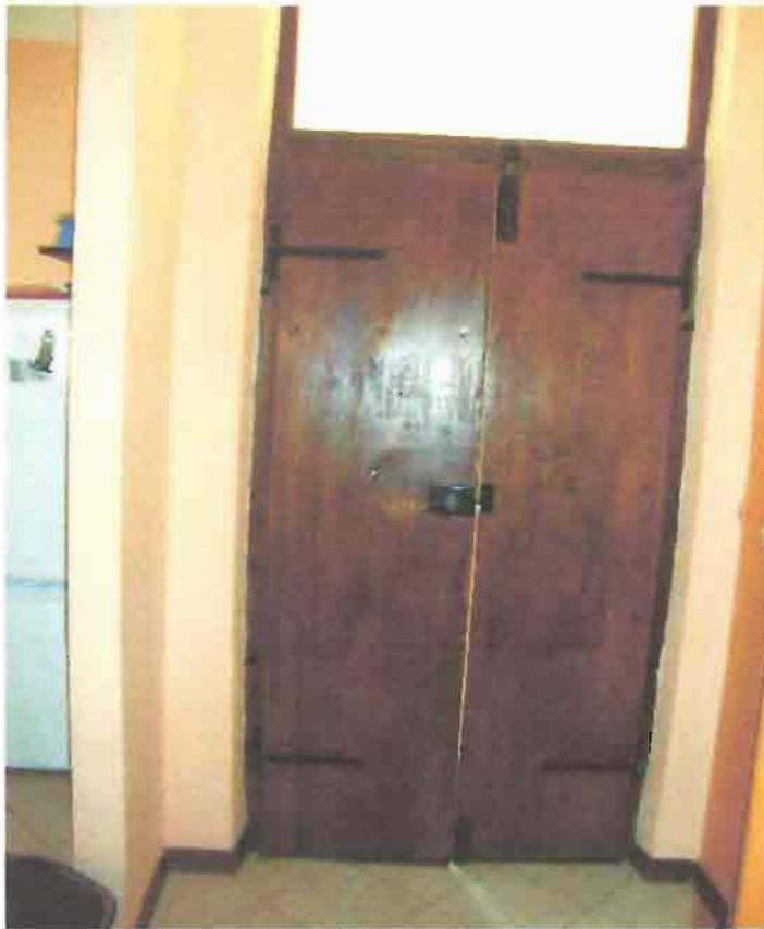
Illustrazione 9: Portone ingresso vista interna
