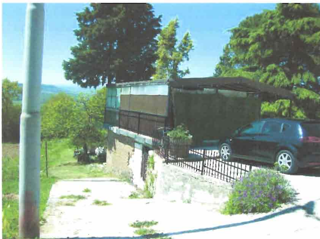
Illustrazione 6: Prospetto lato nord est
