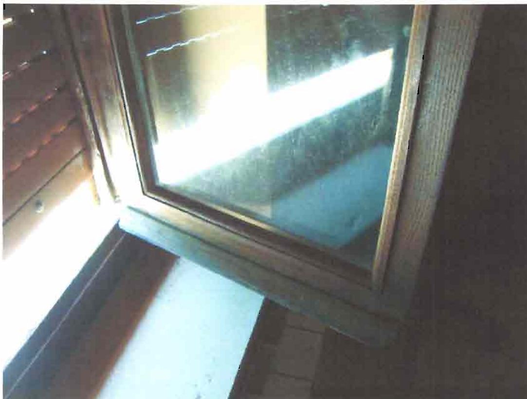
Illustrazione 17: Particolare infissi esterno
