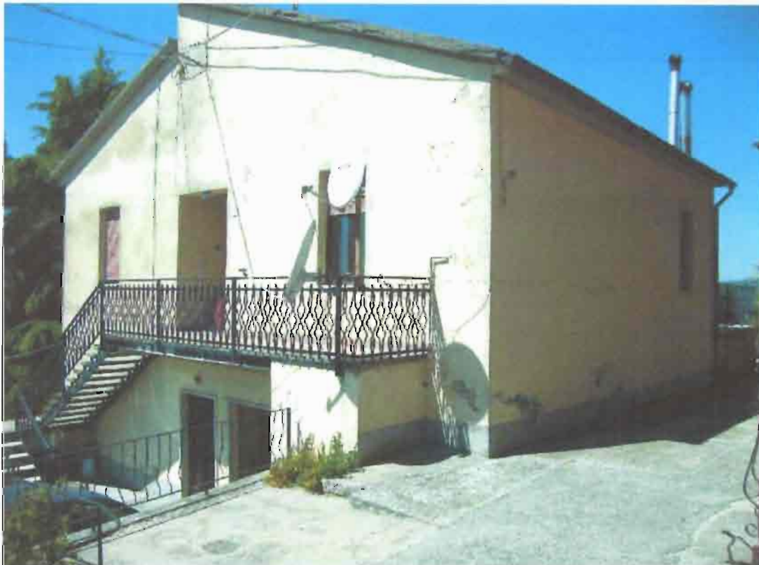
Illustrazione 2: Prospetto lato nord-est
