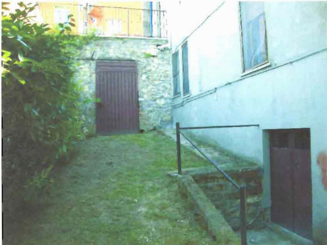
Illustrazione 5: Prospetto lato ovest con in alto particolare ingresso Rimessa e centrale termica in basso ingresso alla dispensa
