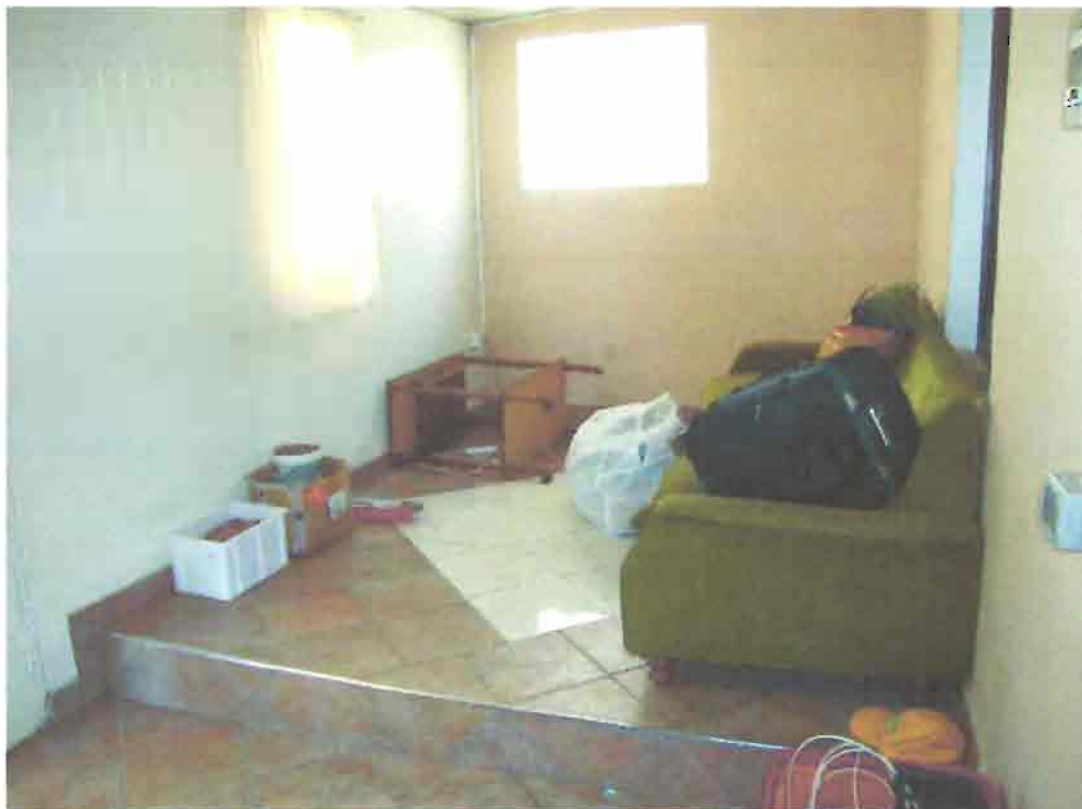
Illustrazione 14: Particolare interno ampliamento abusivamente realizzato
