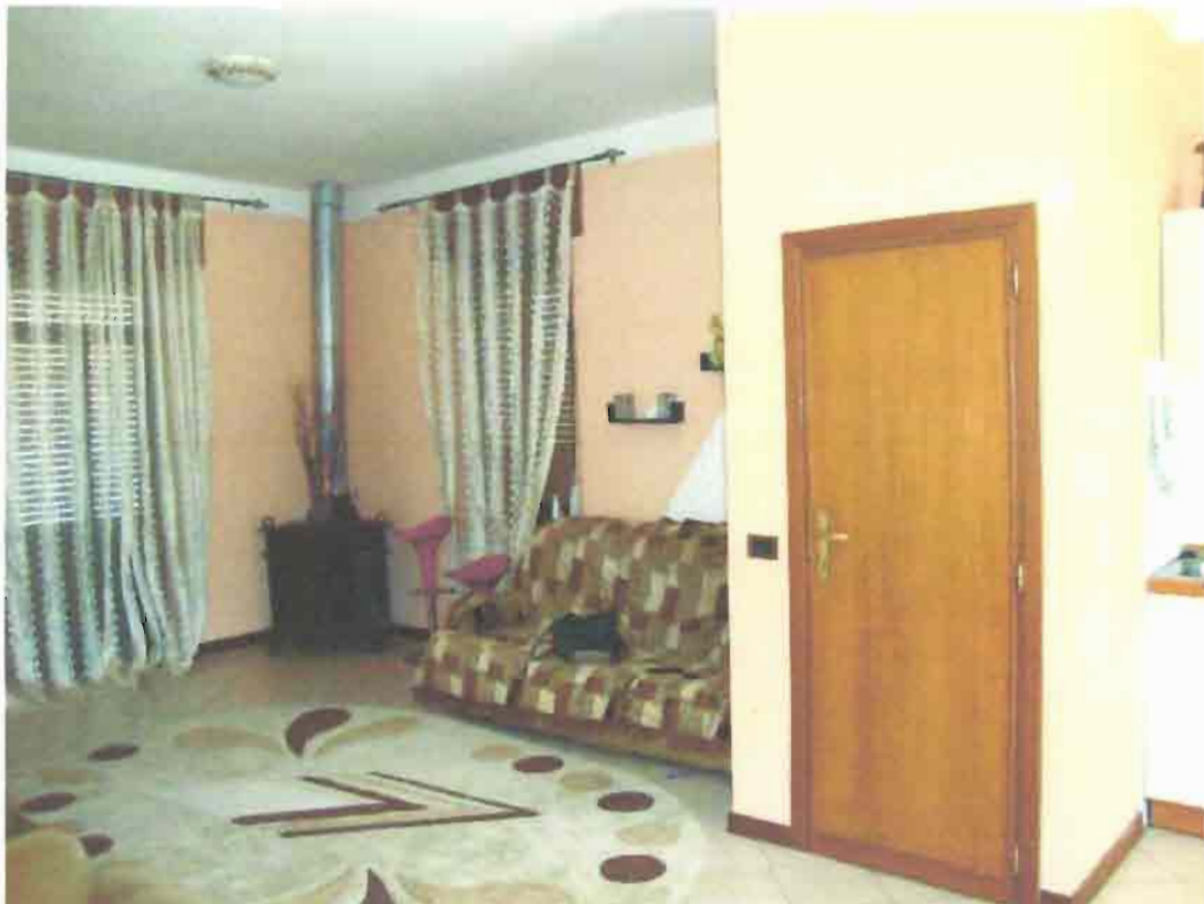
Illustrazione 11: Soggiorno con vista piccolo vano scala contenente la scala a chiocciola di collegamento all'appartamento posto al piano inferiore, da demolire.
