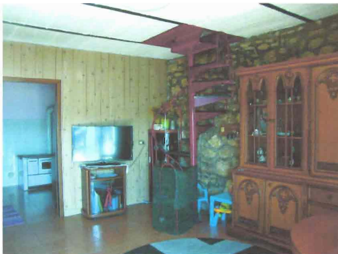
Illustrazione 6: Soggiorno con particolare della scala a chiocciola di collegamento all'appartamento superiore da demolire
