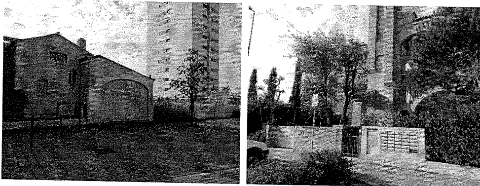
Accesso autorimessa e pedonale su Via Bertolino Don Guerrin
