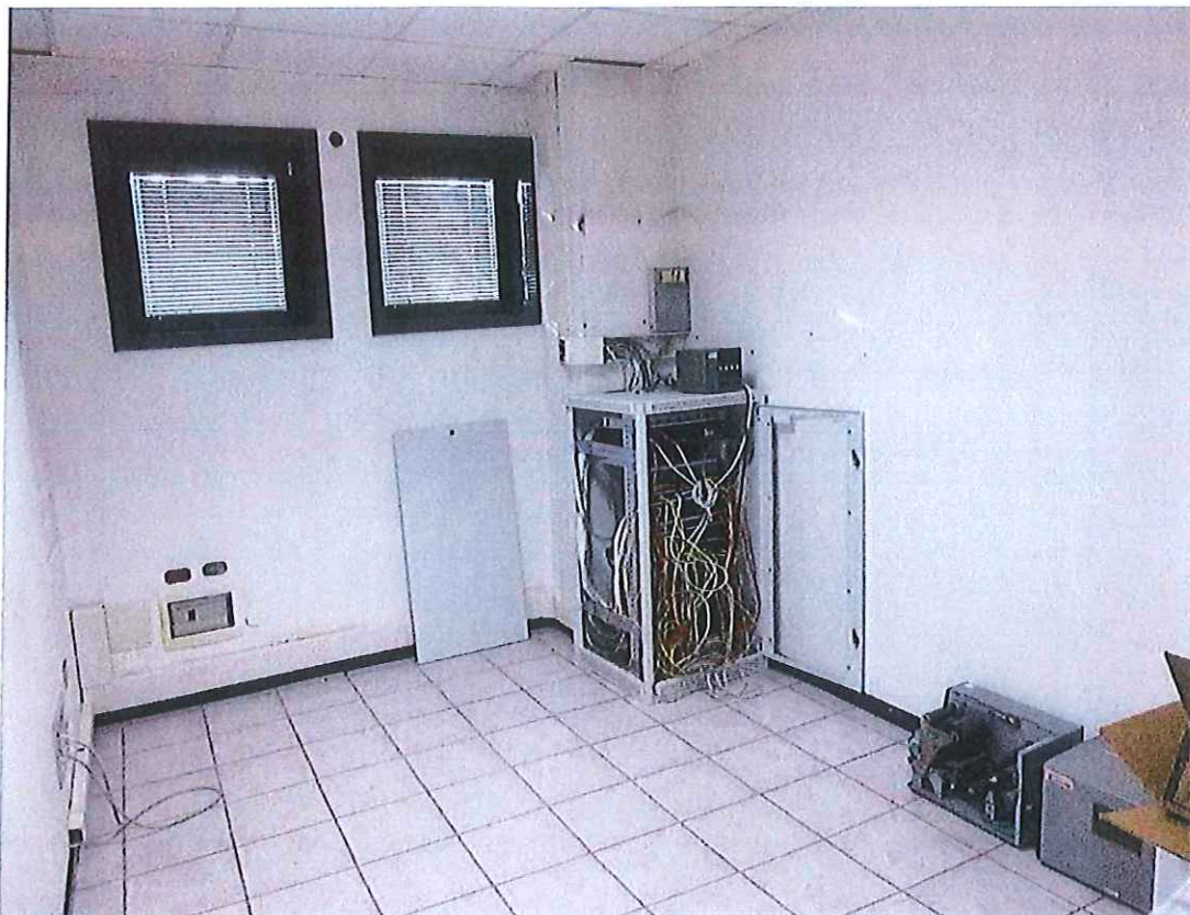
Foto n° 17 : Annesso adibito ad uffici – vista interna parziale.
