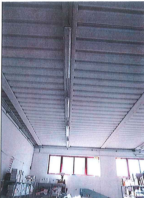
Foto n° 7 : Immobile produttivo – vista interna.
