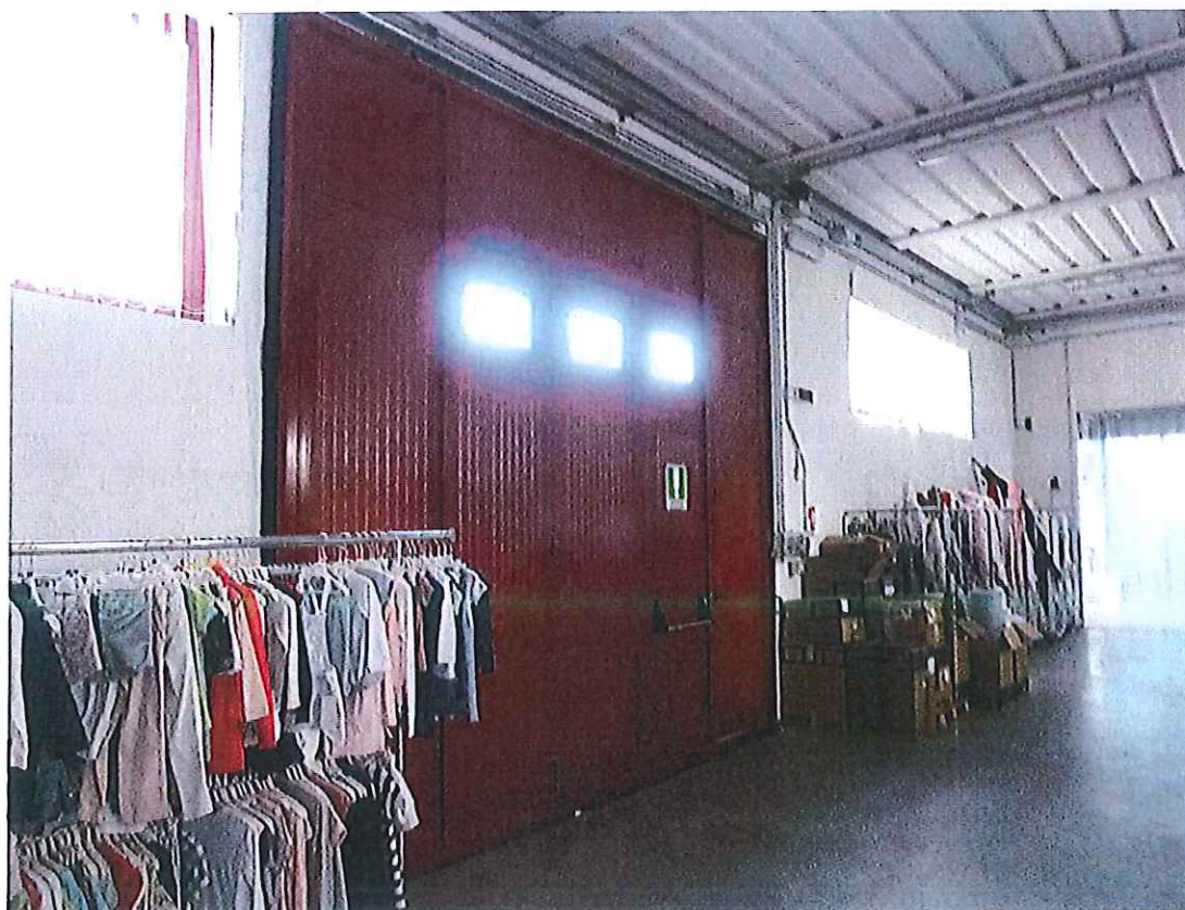
Foto n° 8 : Immobile produttivo – vista interna.
