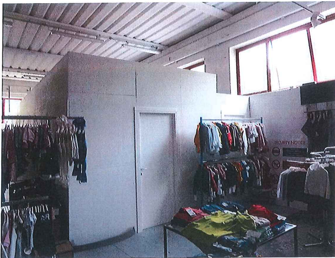
Foto n° 13 : Annesso interno in difformità.
