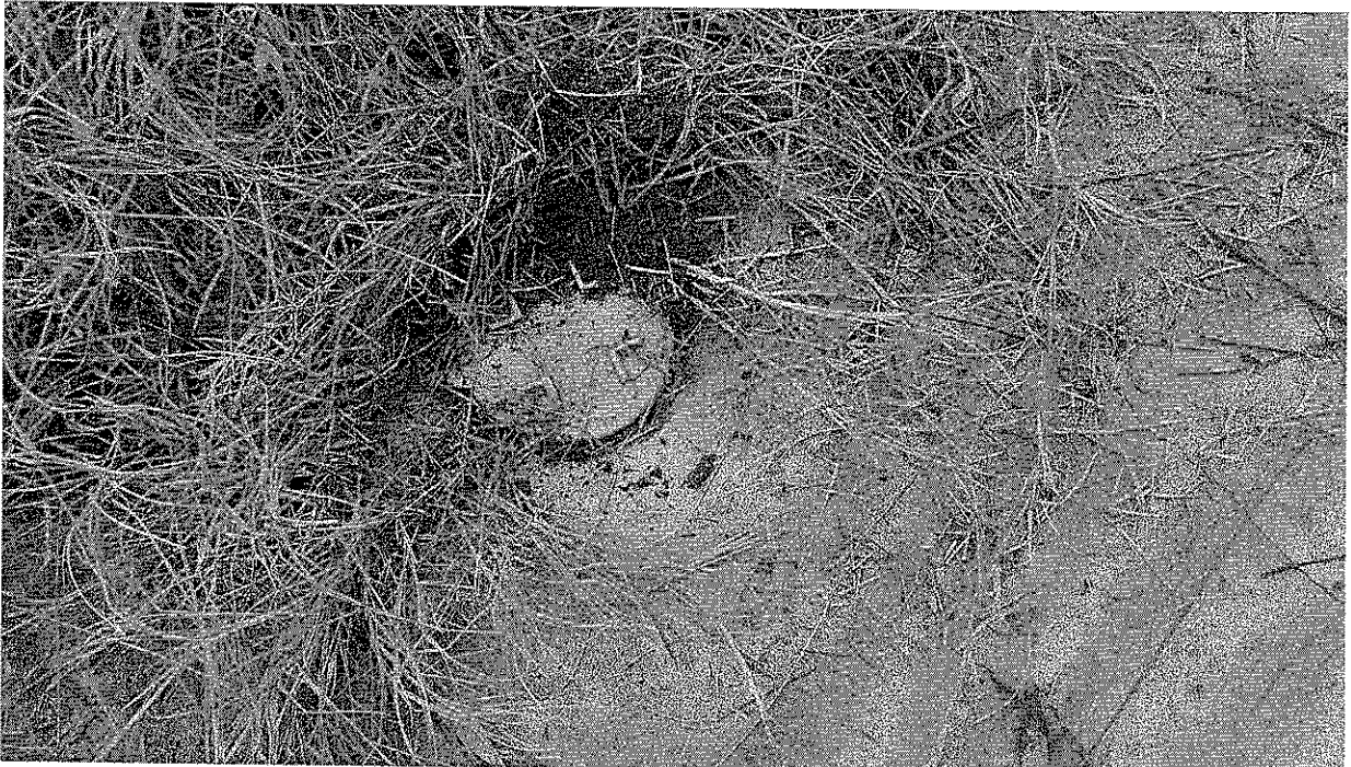
PARTICOLARE TAPPO ISPEZIONE FOGNATURE
