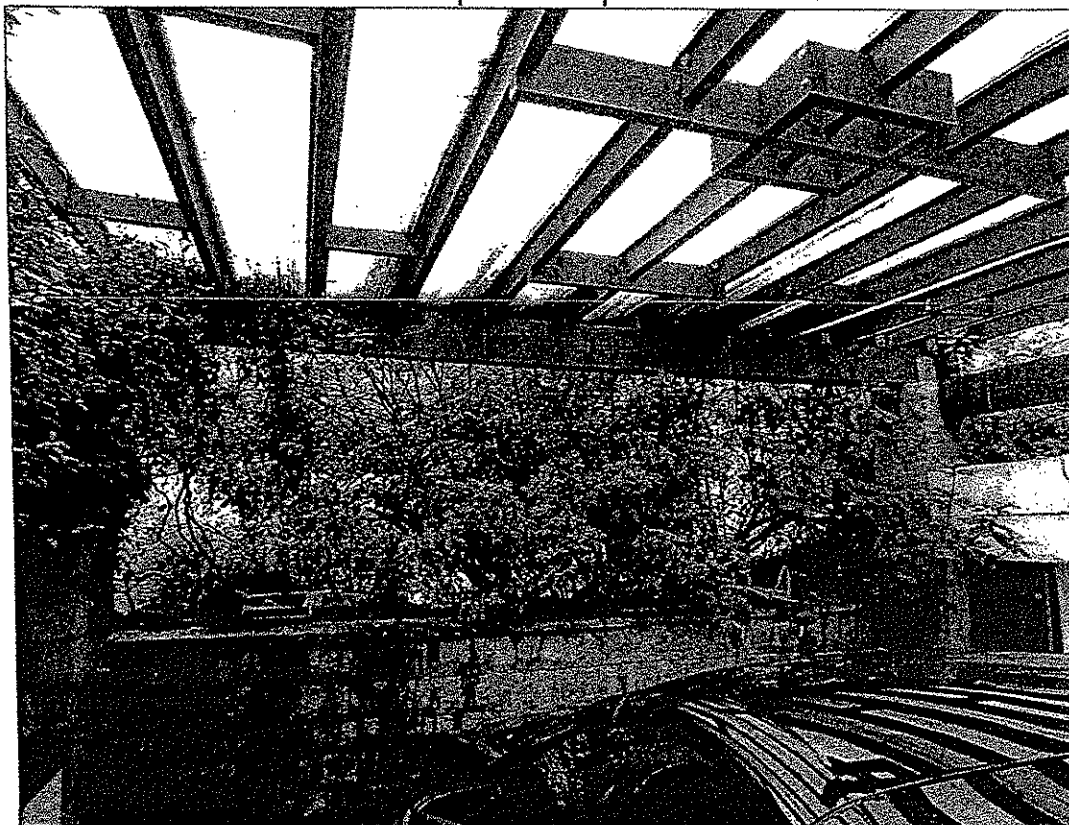
FOTO N°32 - tettoia piana coperta abusiva -
