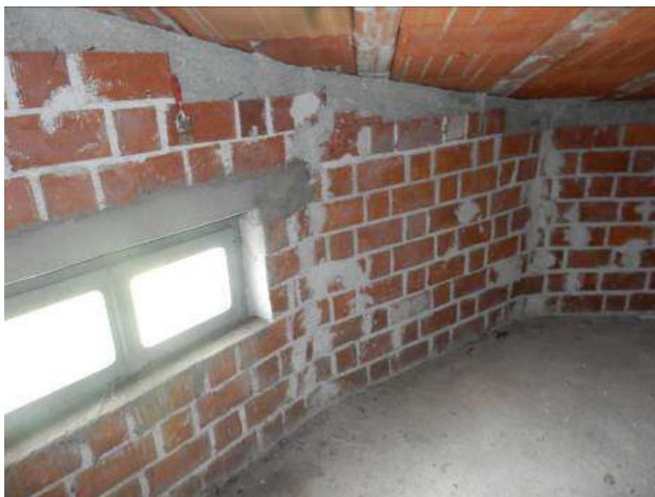
Foto 21-22: Soffitta piano secondo.
