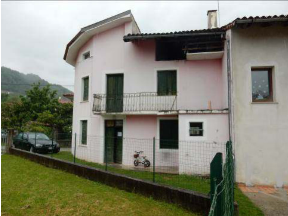
Foto 1-2: Fabbricato di abitazione lato Sud.
