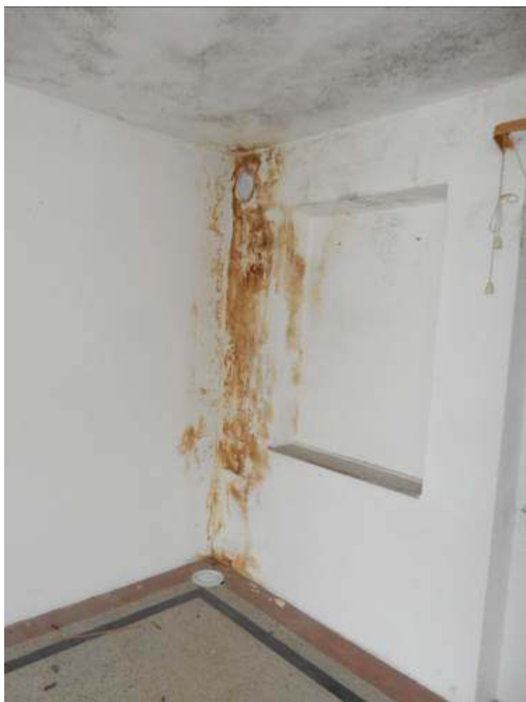
Foto 17-18: Camere piano primo.
