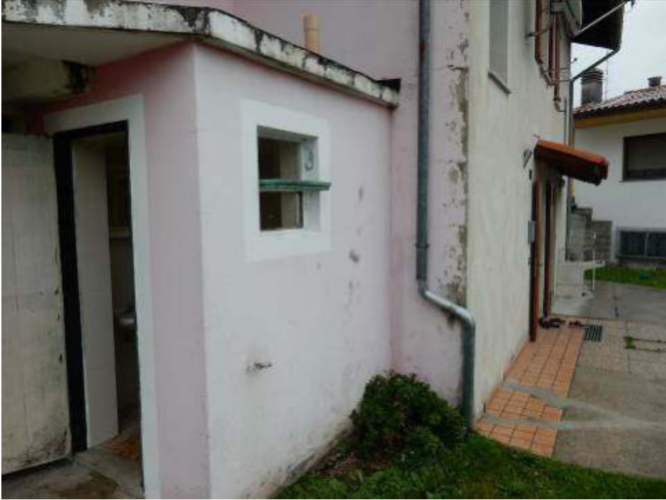
Foto 5-6: Bagno esterno e ingresso fabbricato.
