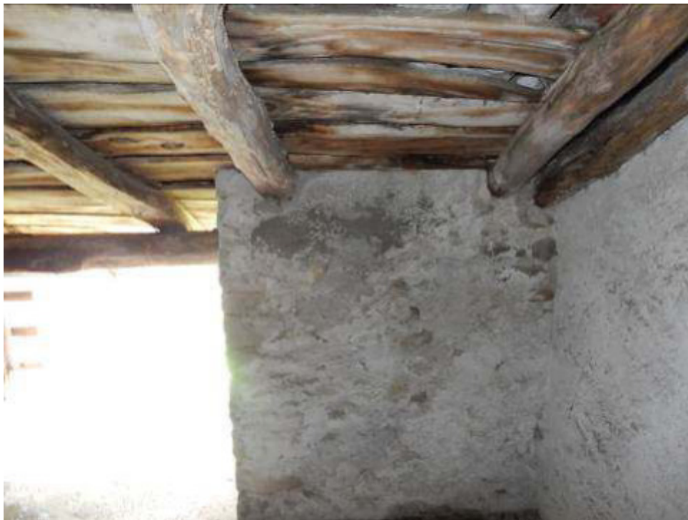
Foto 25-26: Soffitta piano secondo.
