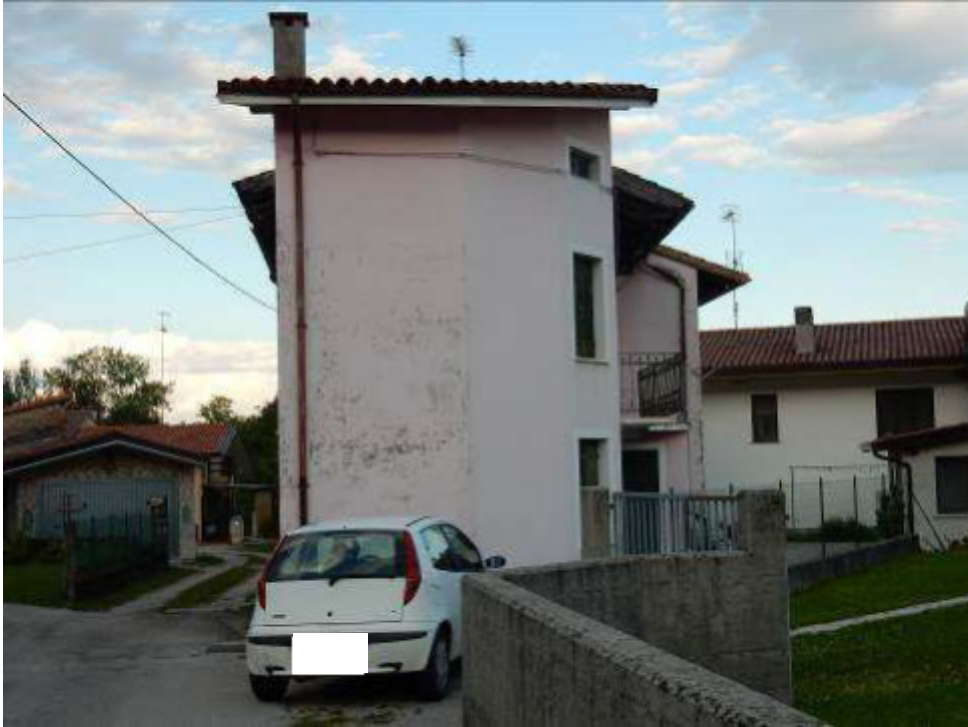
Foto 3-4: Fabbricato di abitazione lato Ovest e lato Nord.
