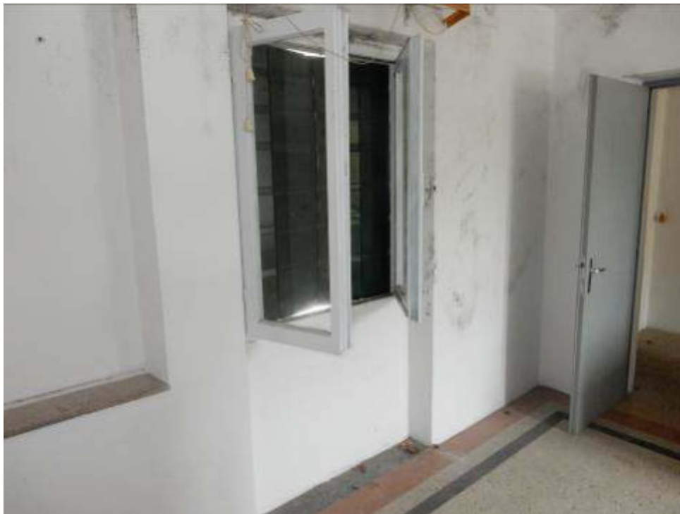
Foto 19-20: Camere piano primo e soffitta.
