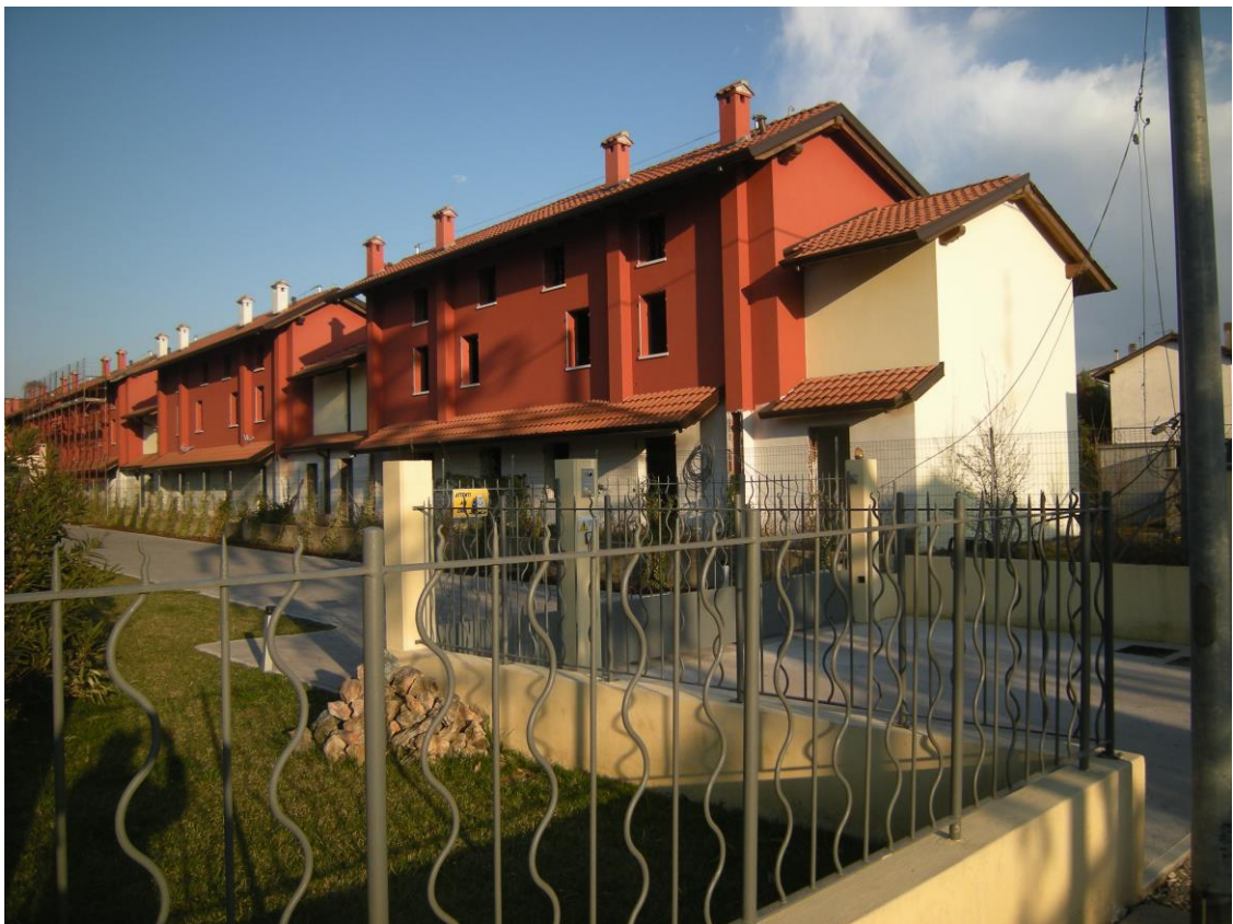
Casarsa della Delizia, Via Trieste - Il prospetto a nord e a nord - ovest delle villette a schiera.
