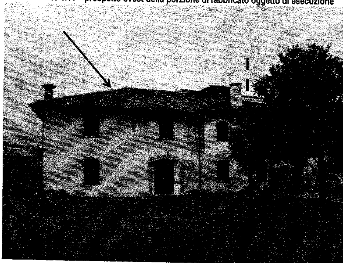
Foto 1.11 – prospetto ovest della porzione di fabbricato oggetto di esecuzione
