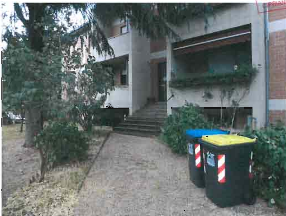
Foto n.6 - Area condominiale sub.1
