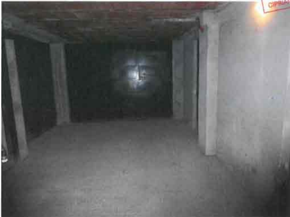
Foto n.4 - Corsello condominiale sub.1
