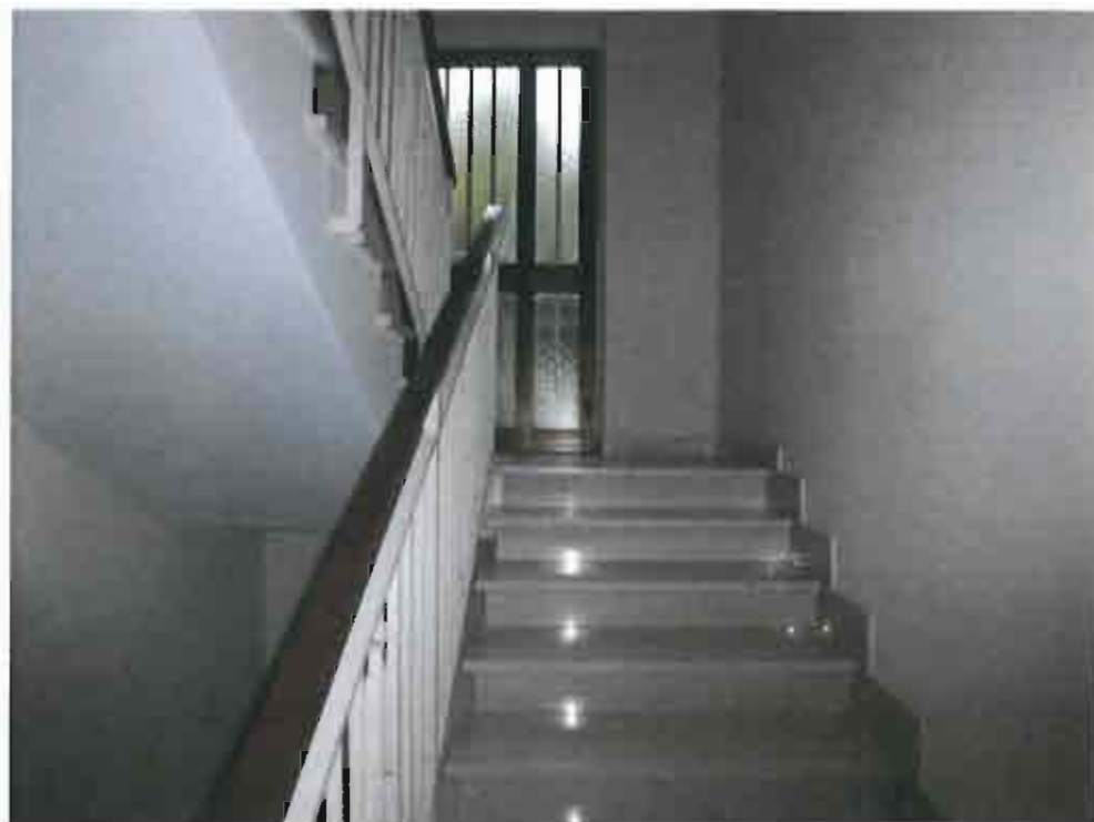
Foto n.1 - Scale condominiali sub.3
