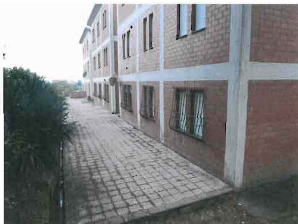
Foto n.8 - Area condominiale sub.1
