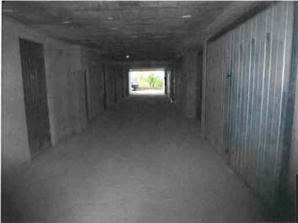
Foto n.3 - Corsello condominiale sub.1
