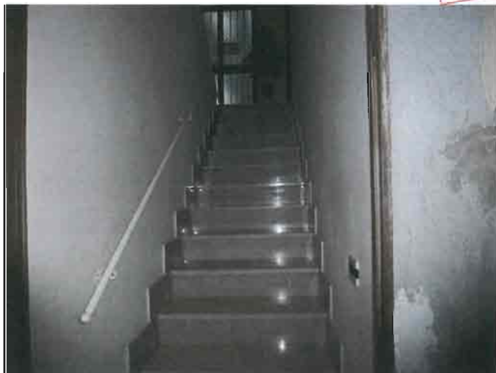
Foto n.2 - Scale condominiali sub.3
