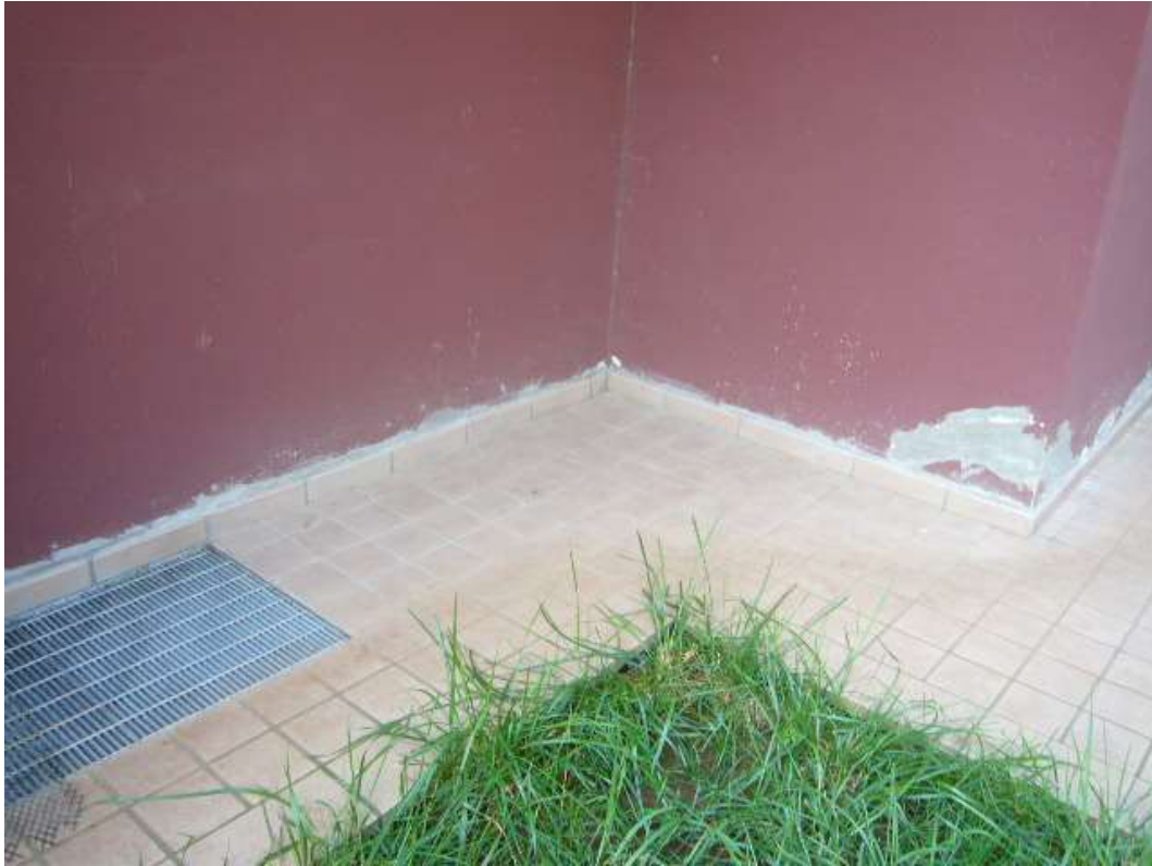
CONDIZIONI MURATURE ESTERNE
