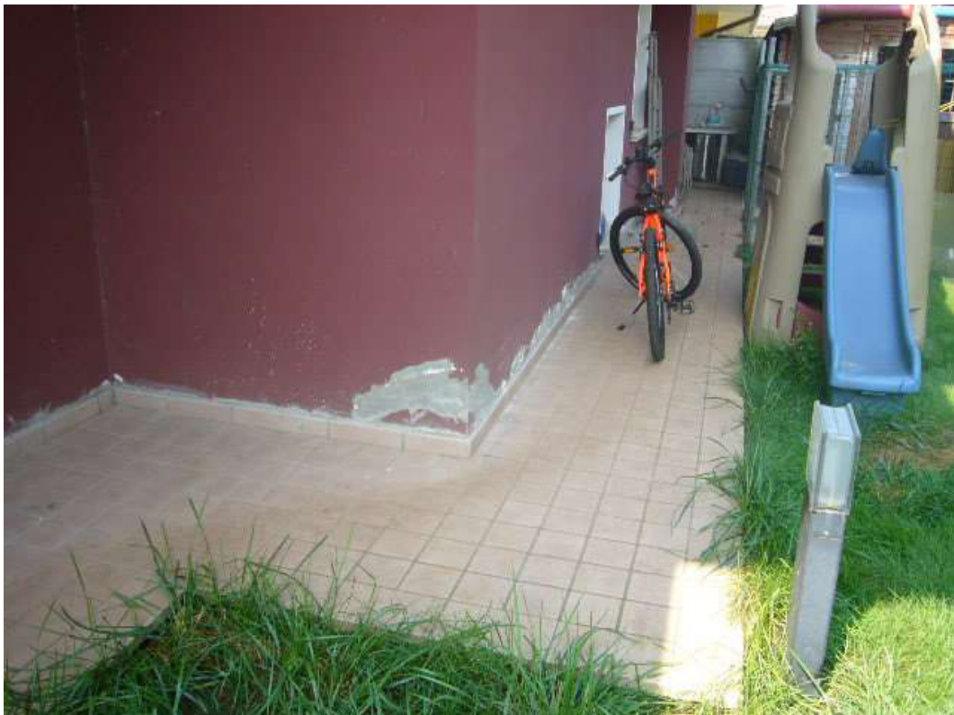
CONDIZIONI MURATURE ESTERNE
