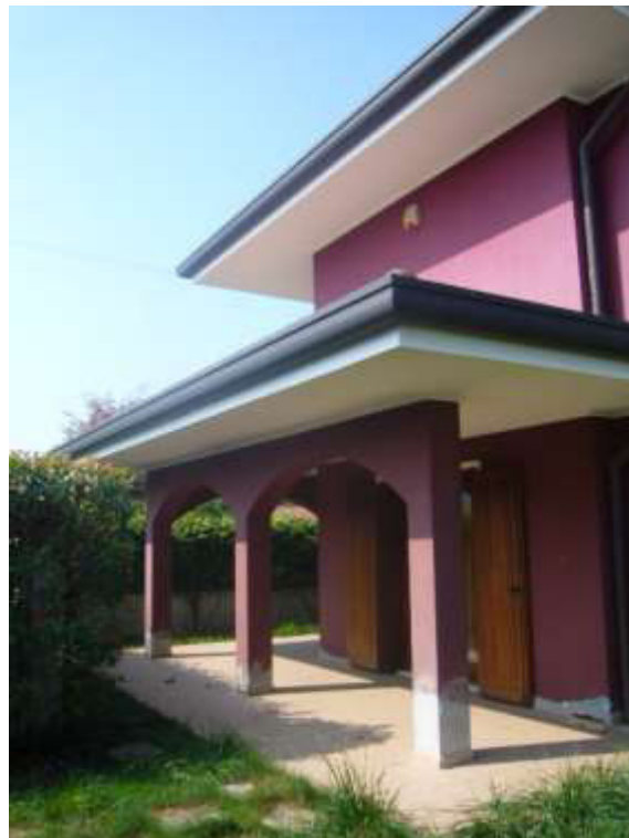
CONDIZIONI MURATURE ESTERNE
