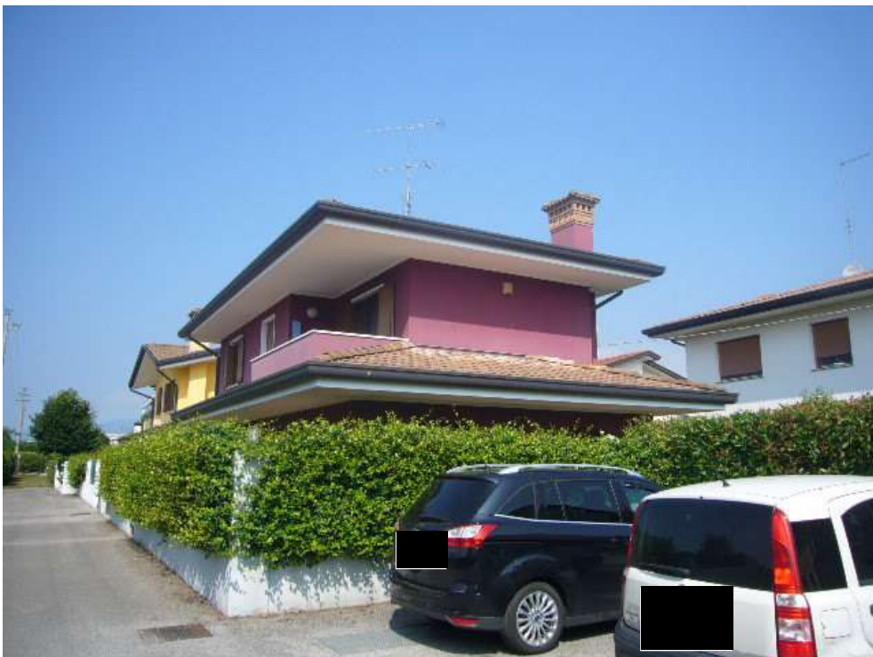
ESTERNO LATO SUD EST
