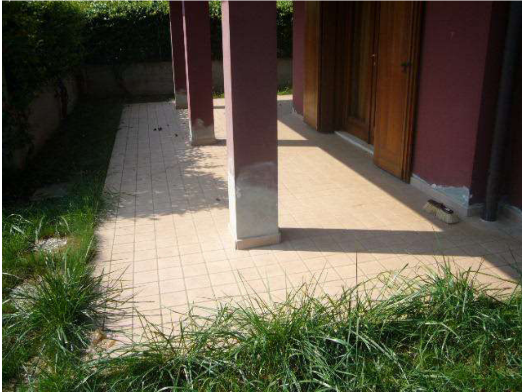
CONDIZIONI MURATURE ESTERNE
