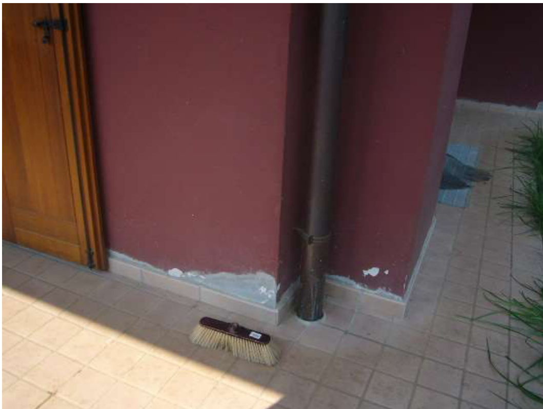
CONDIZIONI MURATURE ESTERNE
