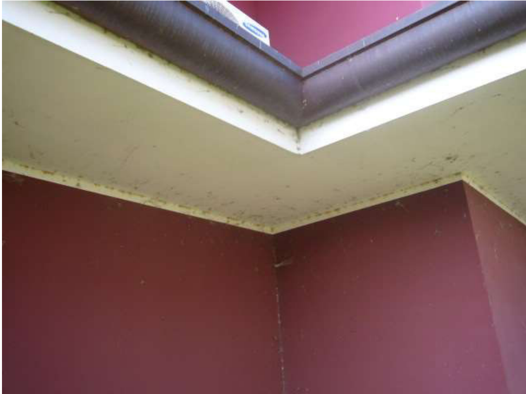
CONDIZIONI MURATURE ESTERNE
