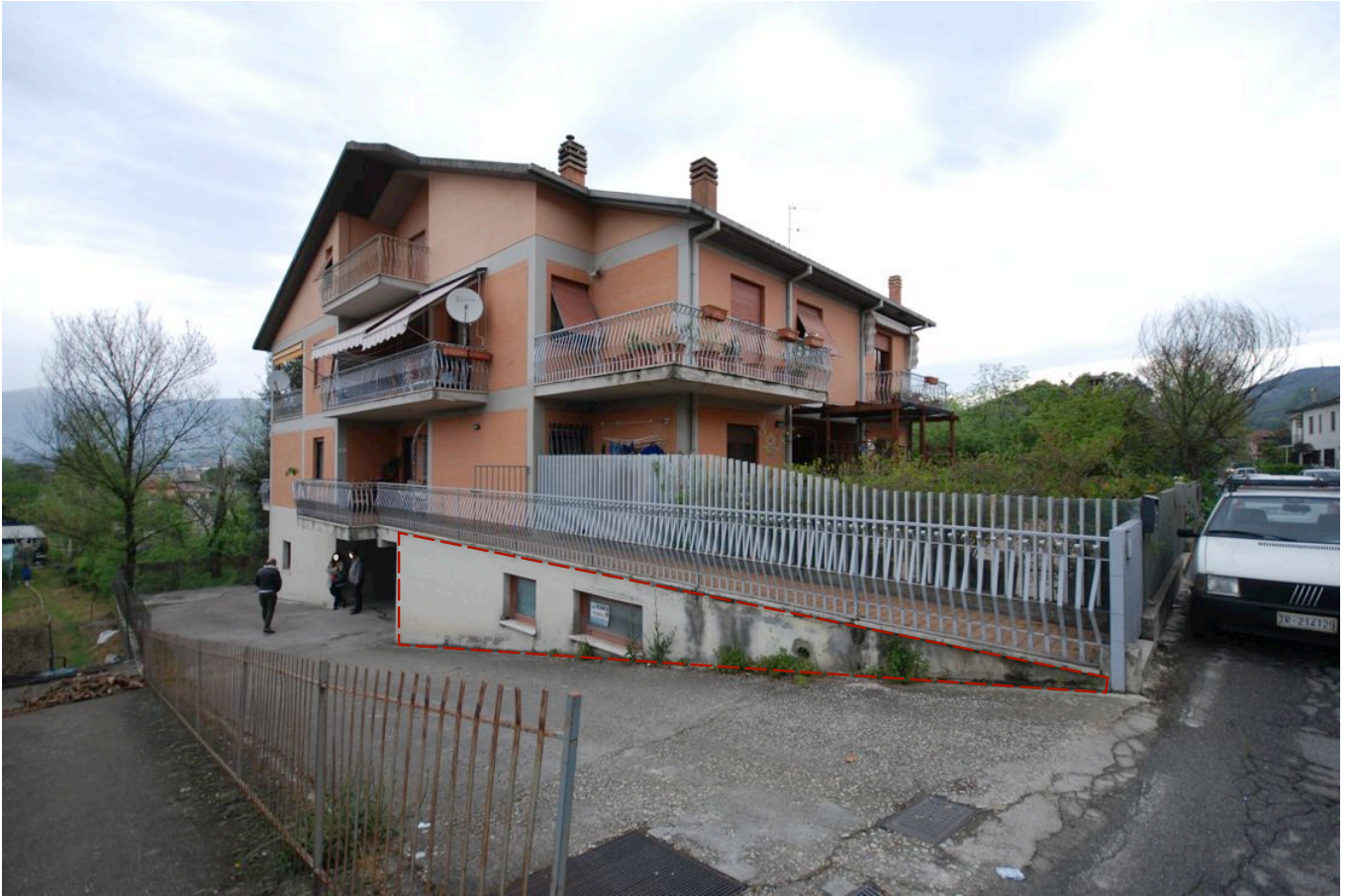
01_Foto del 08-04-2016_fabbricato da Via A. Murri
