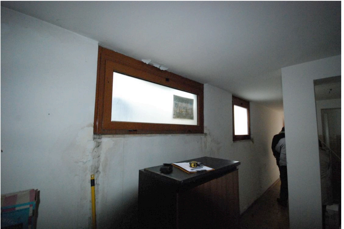
11_Foto del 08-04-2016_interno del magazzino, parete finestrata verso la rampa condominiale
