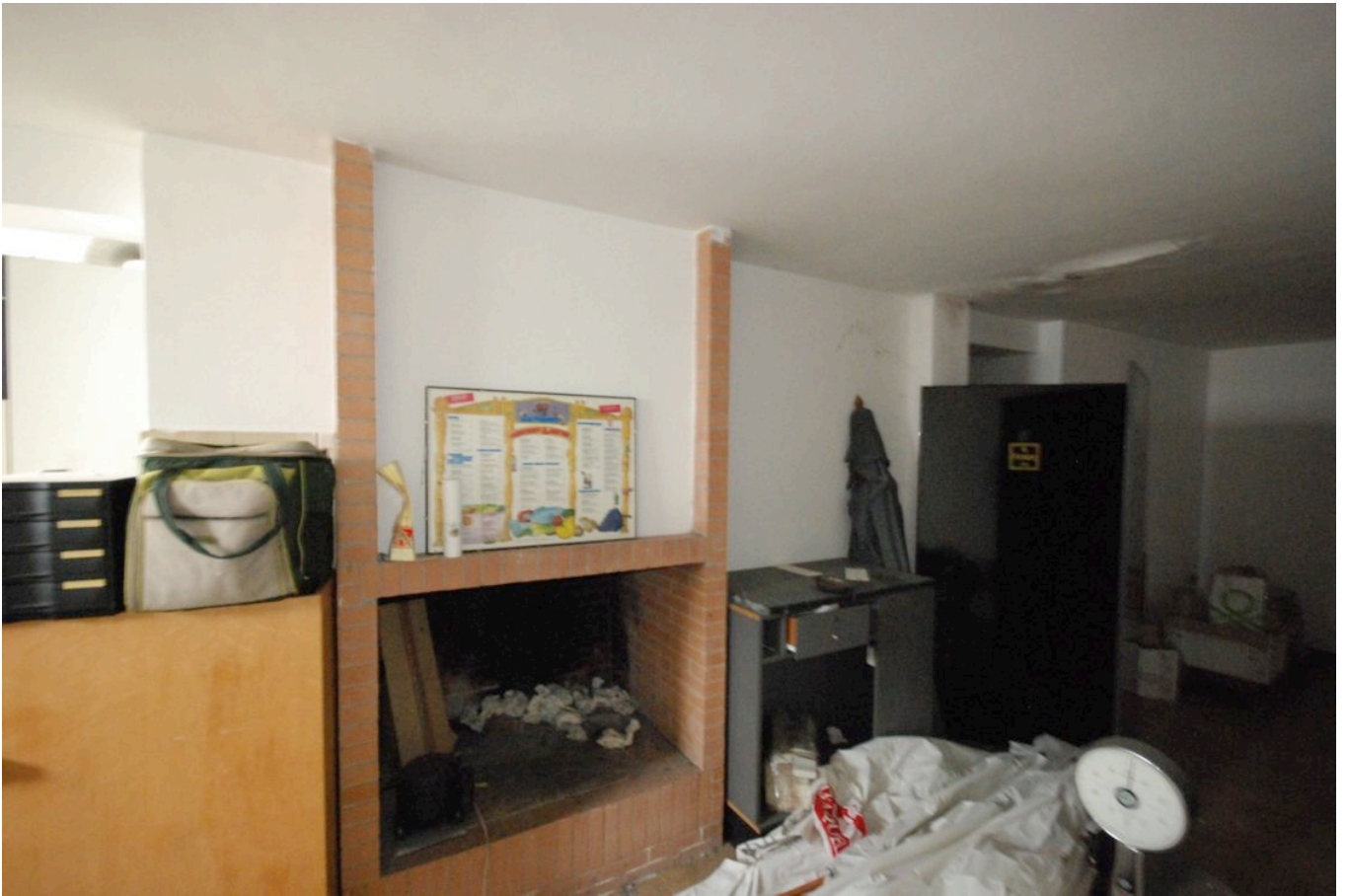
13_Foto del 08-04-2016_interno del magazzino, camino
