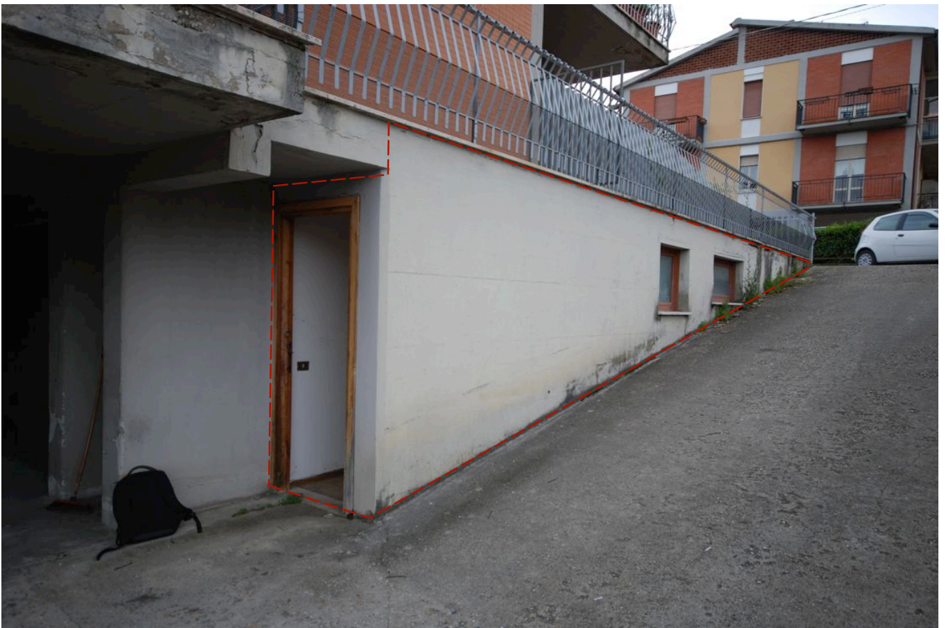
04_Foto del 08-04-2016_ingresso del magazzino dalla rampa
