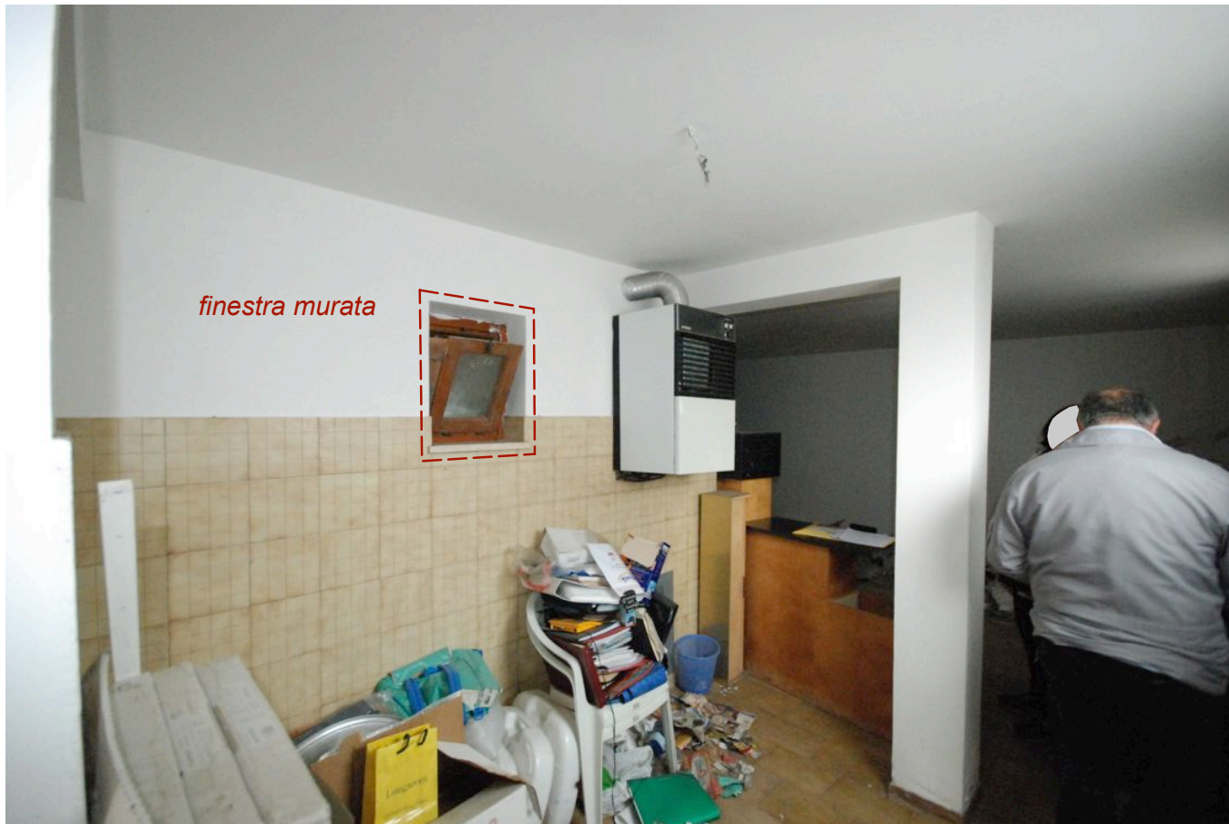
07_Foto del 08-04-2016_interno del magazzino, con indicazione della finestra murata
