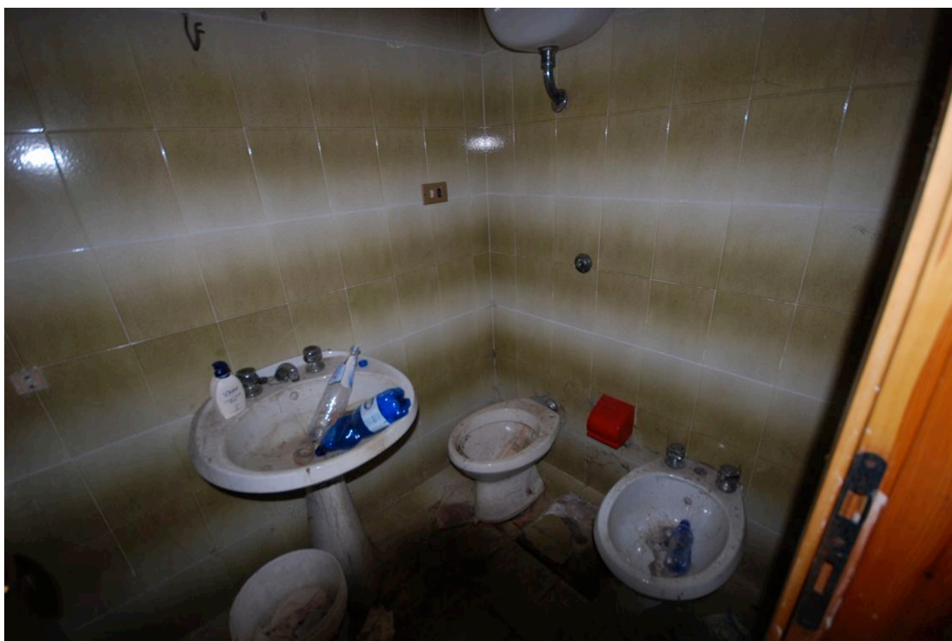
16_Foto del 08-04-2016_interno del magazzino, wc
