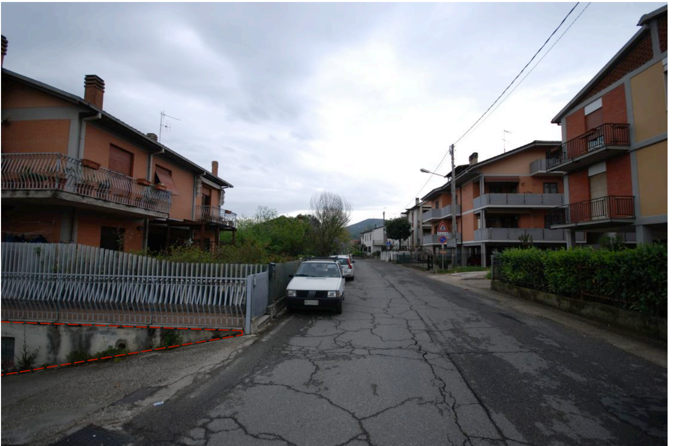
02_Foto del 08-04-2016_Via A. Murri con il fabbricato sulla sinistra
