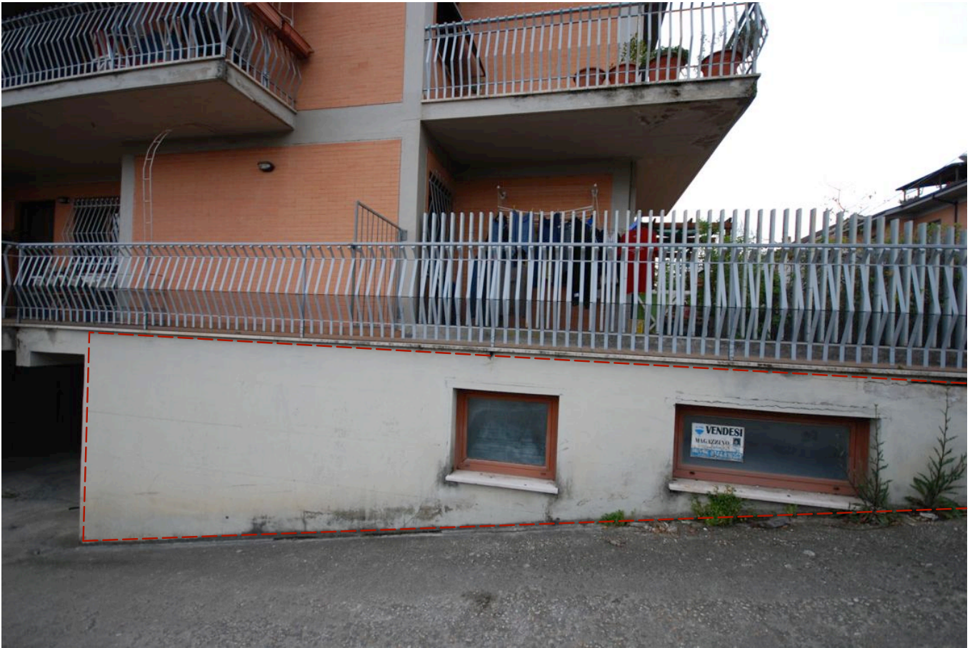
03_Foto del 08-04-2016_lato del magazzino verso rampa condominiale
