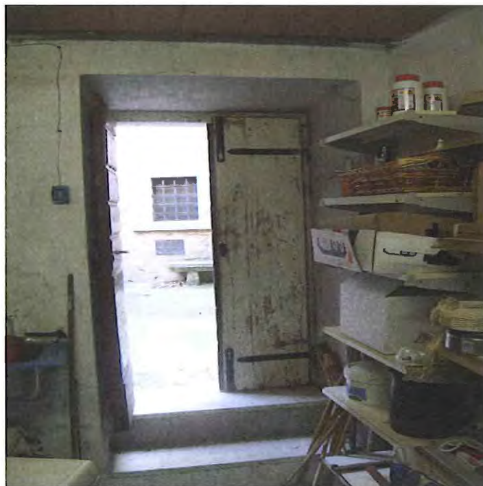
Illustrazione 47: Particolare magazzino 1 al piano terra
