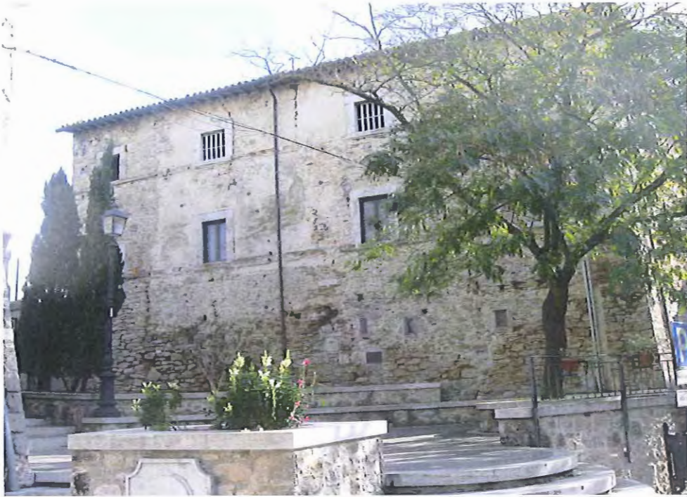
Illustrazione 5: Particolare prospetto nord su Piazza Umberto I
