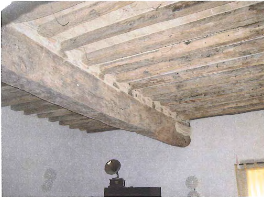
Illustrazione 28: Particolare solaio interpiano piano primo camera 1
