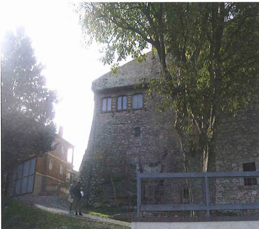
Illustrazione 14: Particolare prospetto lato est
