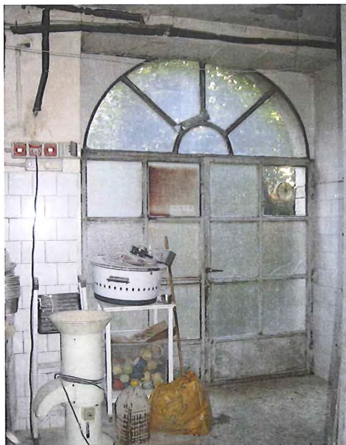
Illustrazione 18: Particolare portone d'ingresso del laboratorio che da sul cortile interno
