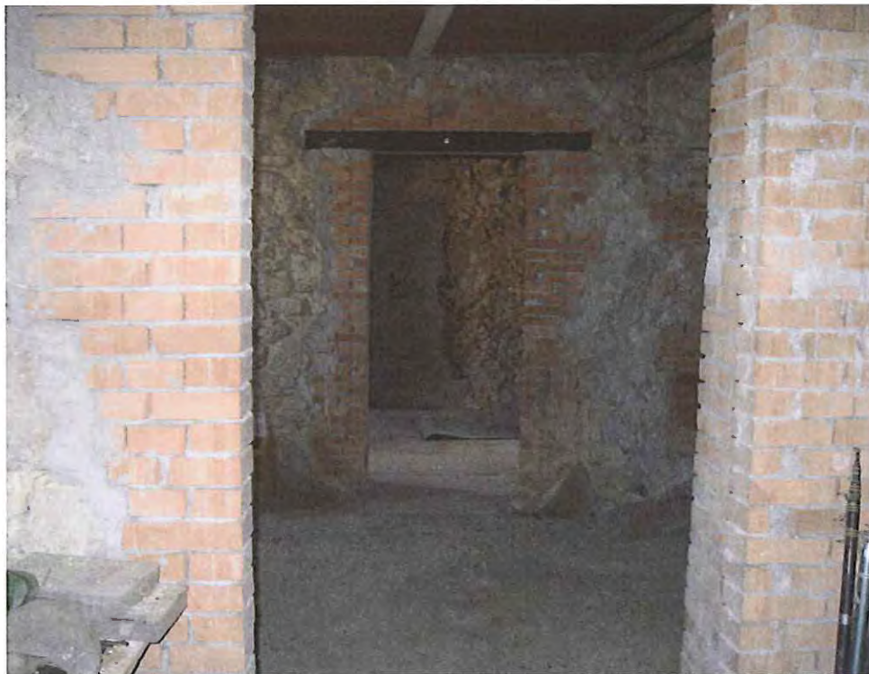
Illustrazione 43: Particolare foto da stanza 2 con vista aperture su stanza 3 e 4
