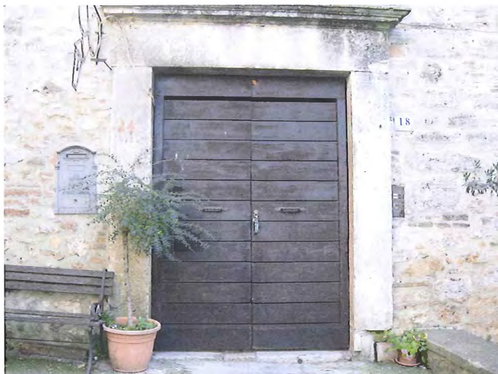
Illustrazione 1: Particolare portone di ingresso per accedere agli immobili pignorati Piazza Umberto I n° 18
