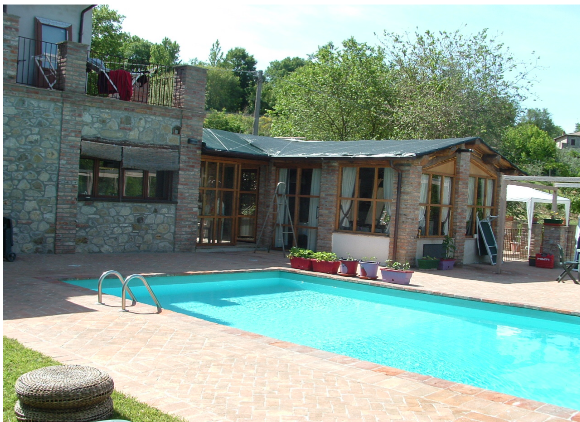
4) Particolare piscina e tettoia in muratura
