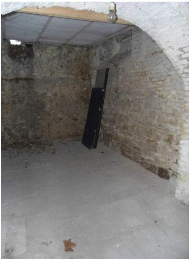
**Foto 25:** particolare soffitto vano 3 – tavelle
