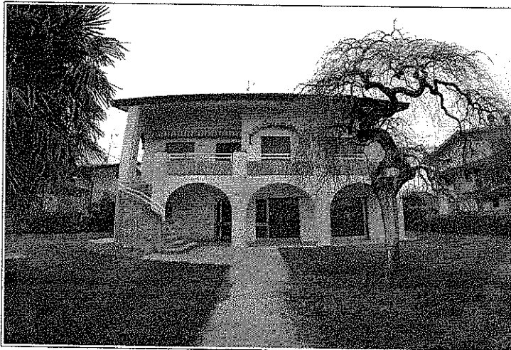
Foto 1 – vista esterna angolo nord-ovest
