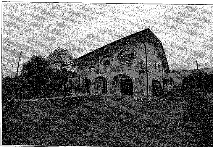
Foto 1 – vista esterna angolo nord-ovest
