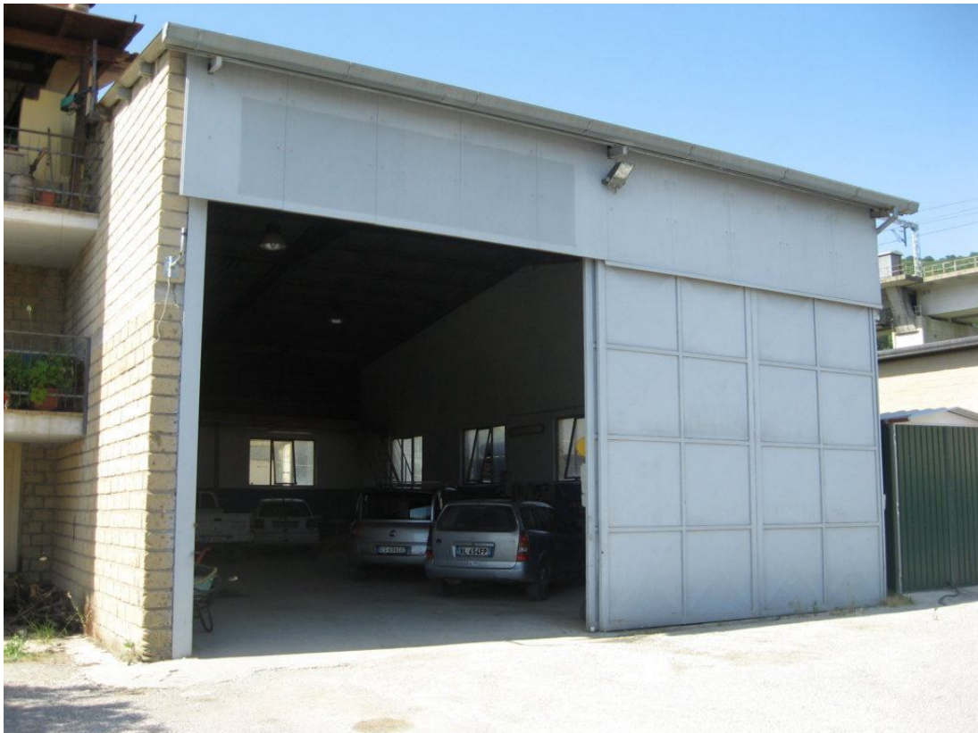
porta carrabile di ingresso del capannone officina
