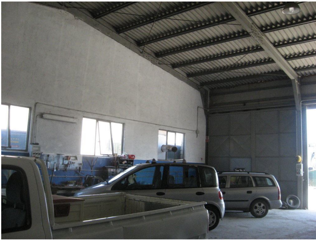
Interno del capannone officina
