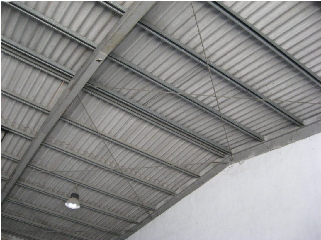
Interno del capannone officina
