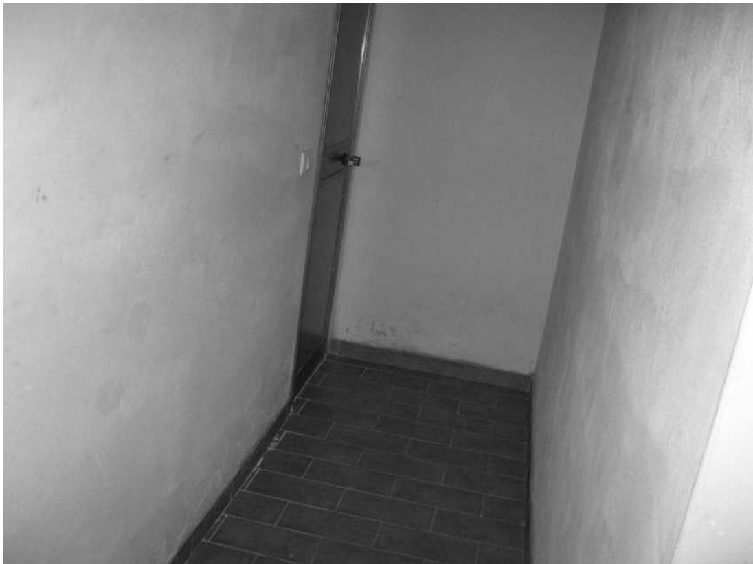
disimpegno del capannone
