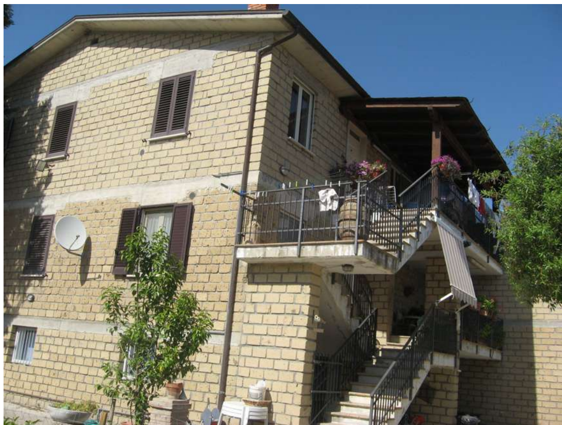
SCALA DI ACCESSO
