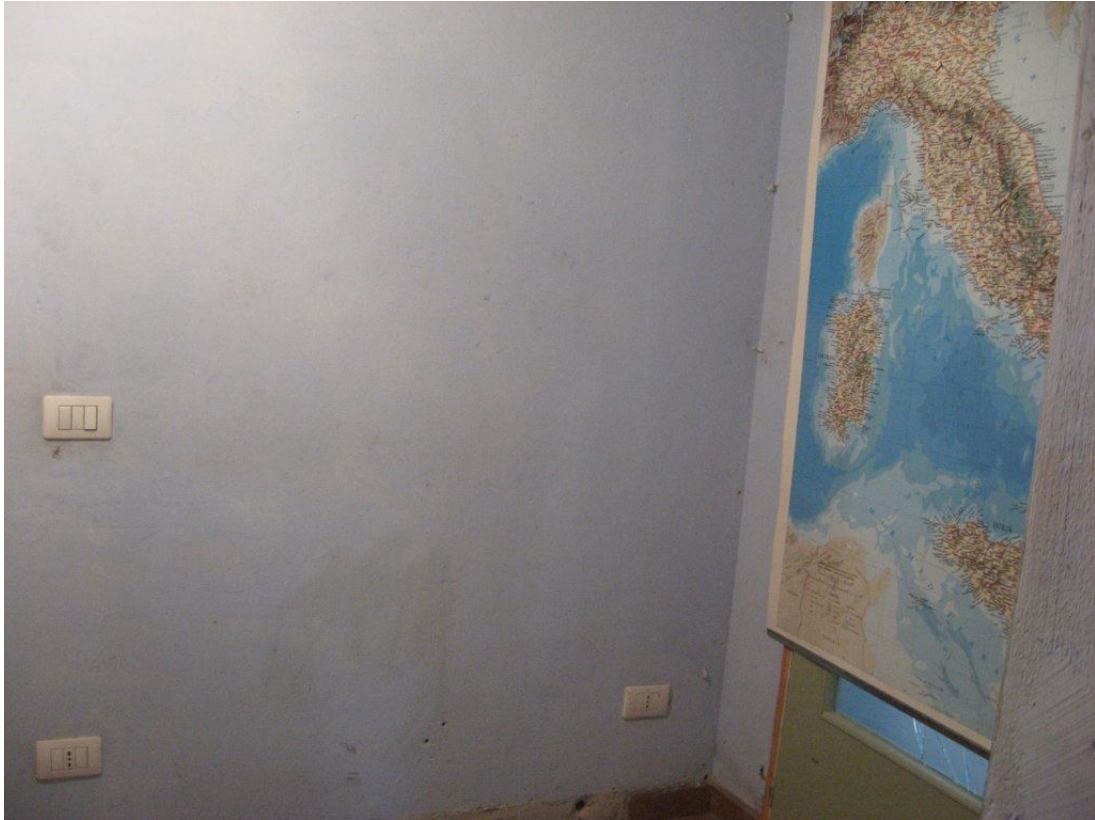
disimpegno del capannone officina
