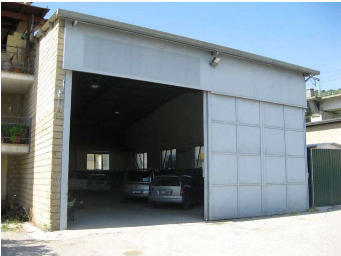
porta carrabile di ingresso del capannone artigianale
