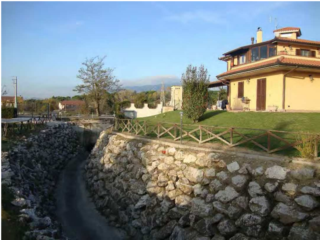
Foto 11 - Fosso confine p.lla 473 lato ovest
