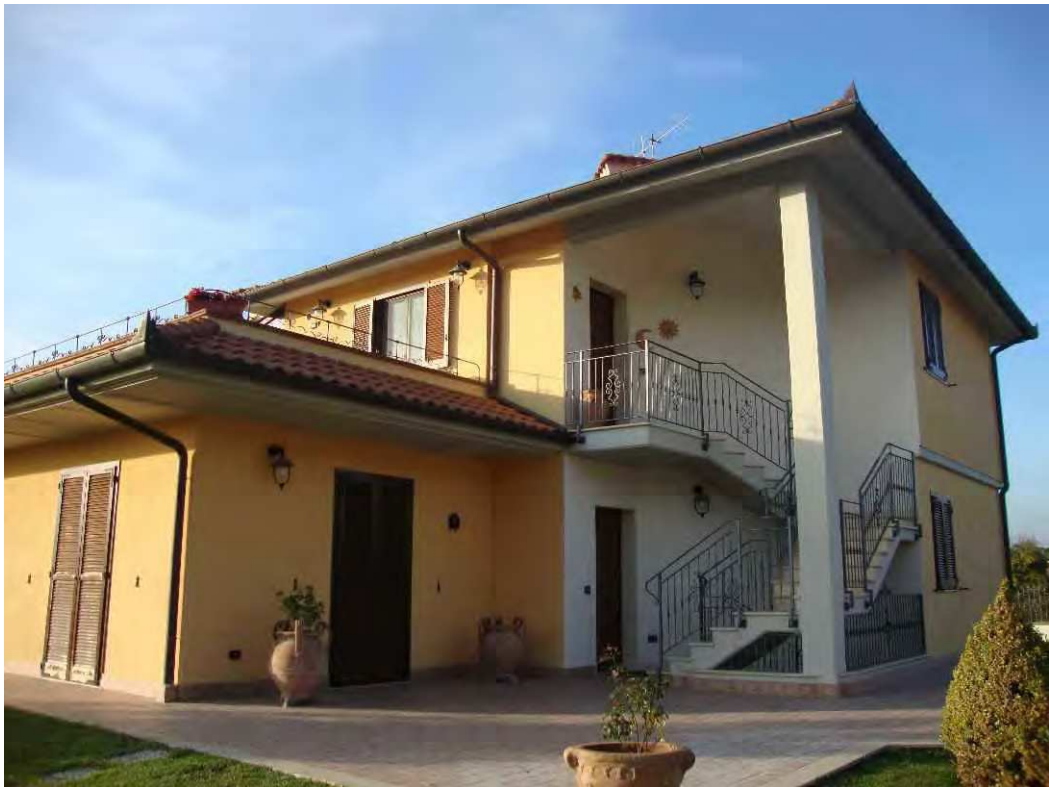
Foto 03 - Prospetto SUD – EST
