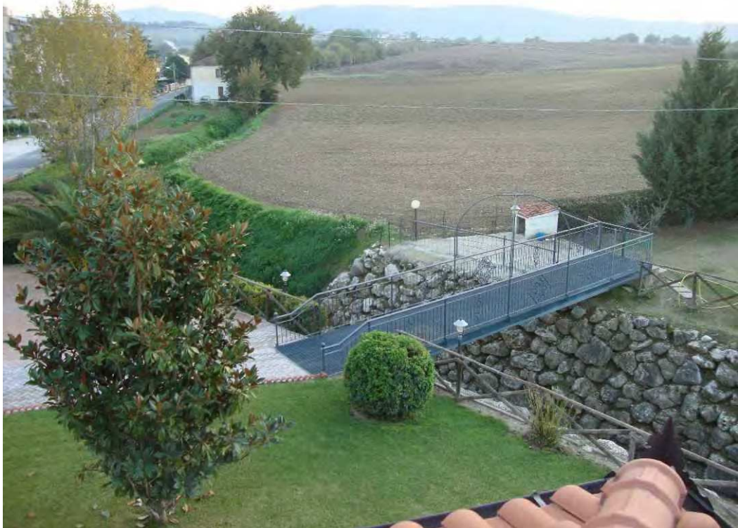
Foto 12 - Ponte attraversamento fosso non autorizzato
