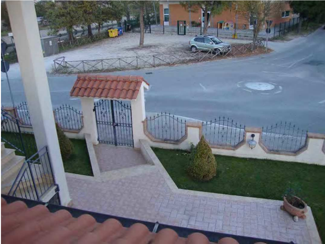
Foto 09 - Corte Comune BCNC sub. 1 – lato est cancello pedonale e recinzione
