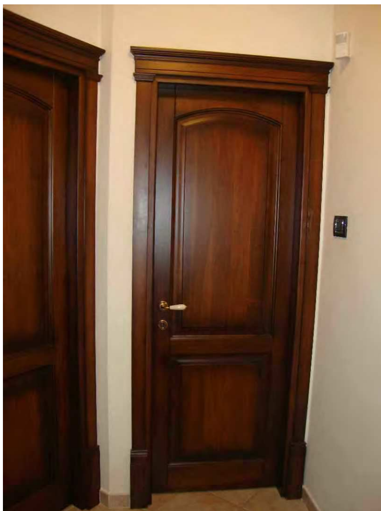
Foto 21 - Particolare infissi interni
