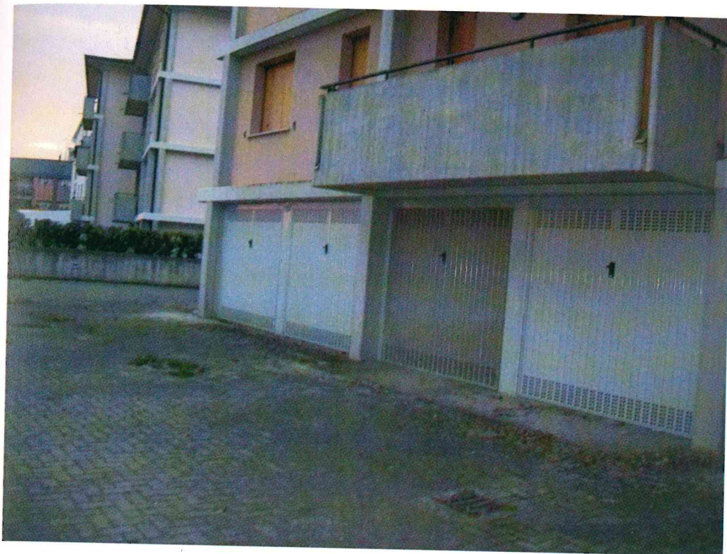
Foto 21 – Immobile B1 in Asolo – vista garages nel fronte Sud.
