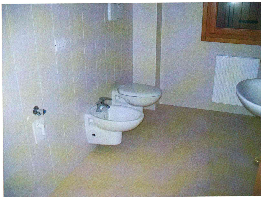
Foto 23 – Vista servizi igienici di un appartamento tipo.
