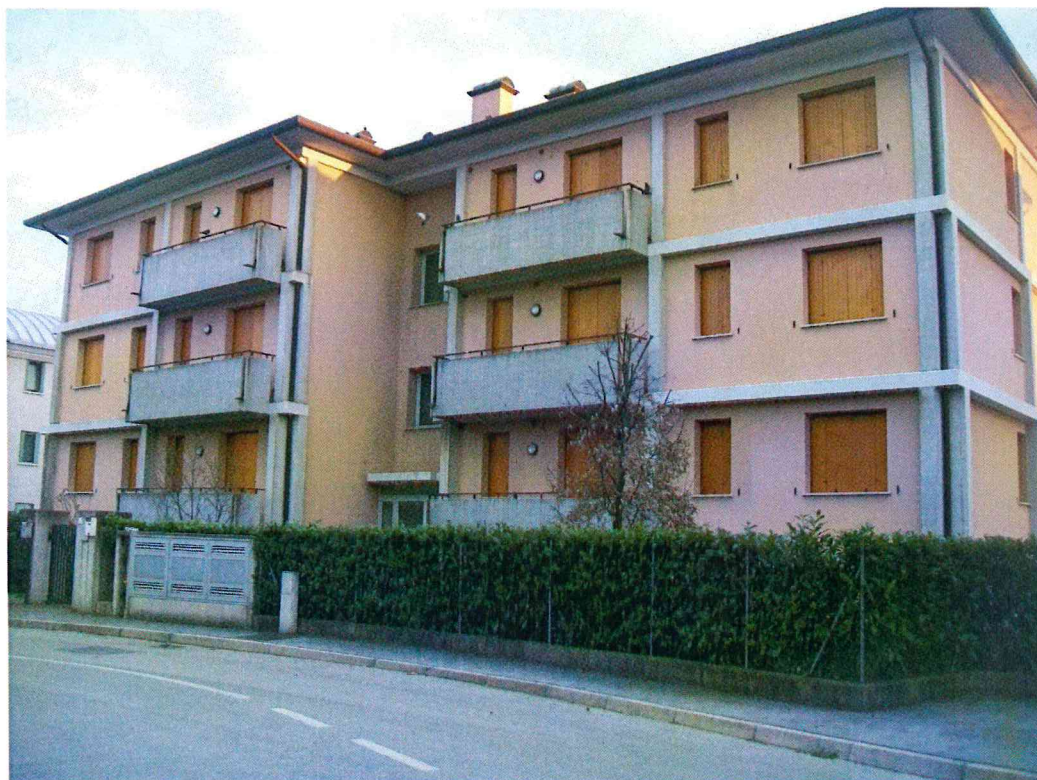
Foto 20 – Immobile B1 in Asolo – vista esterna fronte Nord.
