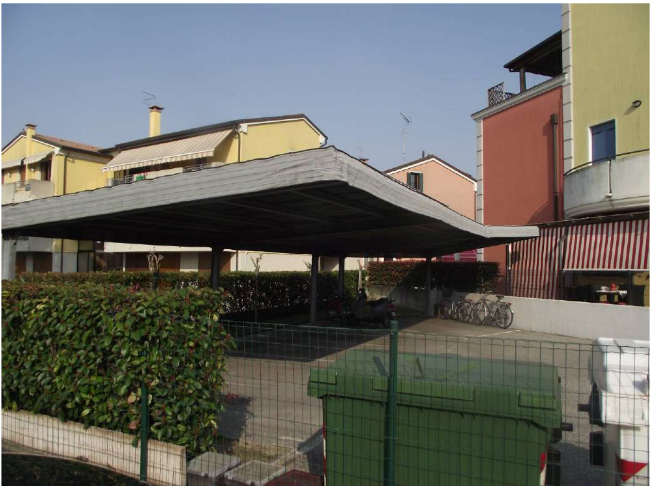
Foto 4 – parcheggi coperti retro edificio
