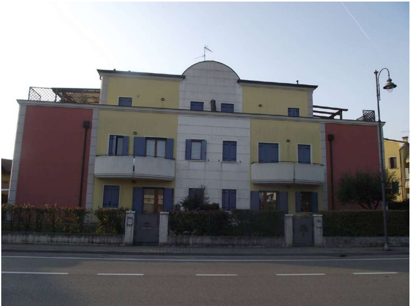
Foto 6 – prospetto fronte strada
