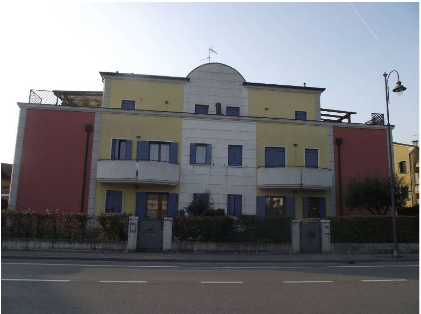
Foto 6 – prospetto fronte strada
