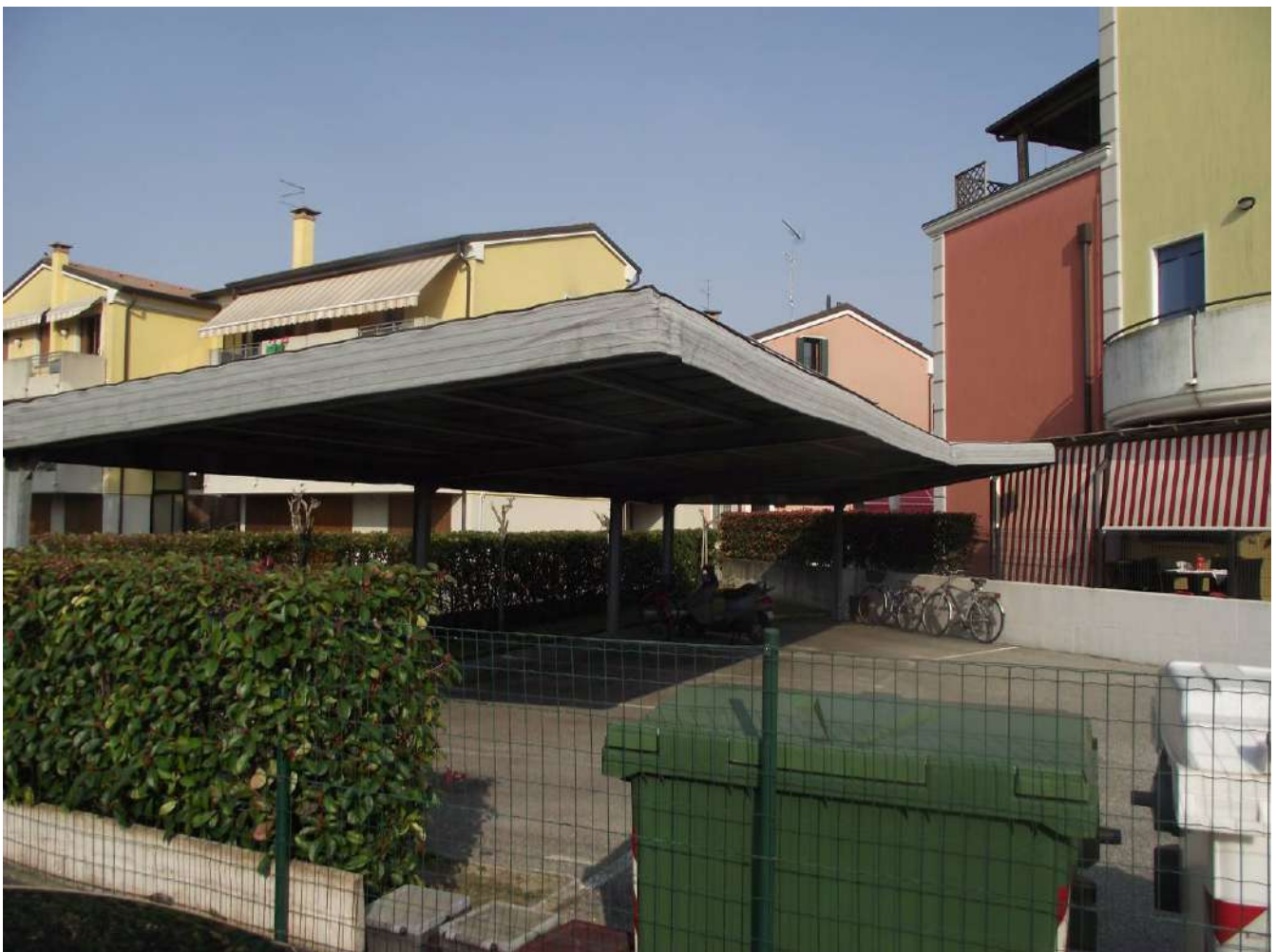
Foto 4 – parcheggi coperti retro edificio
