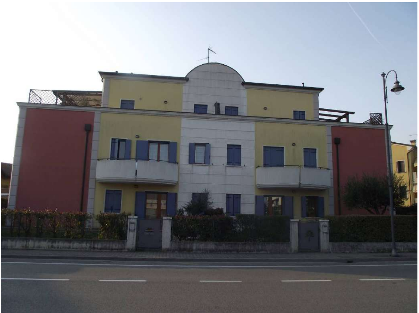
Foto 6 – prospetto fronte strada
