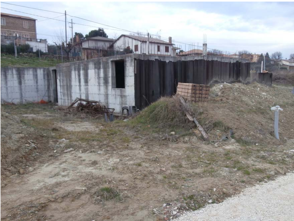
Edificio E: bifamiliare
