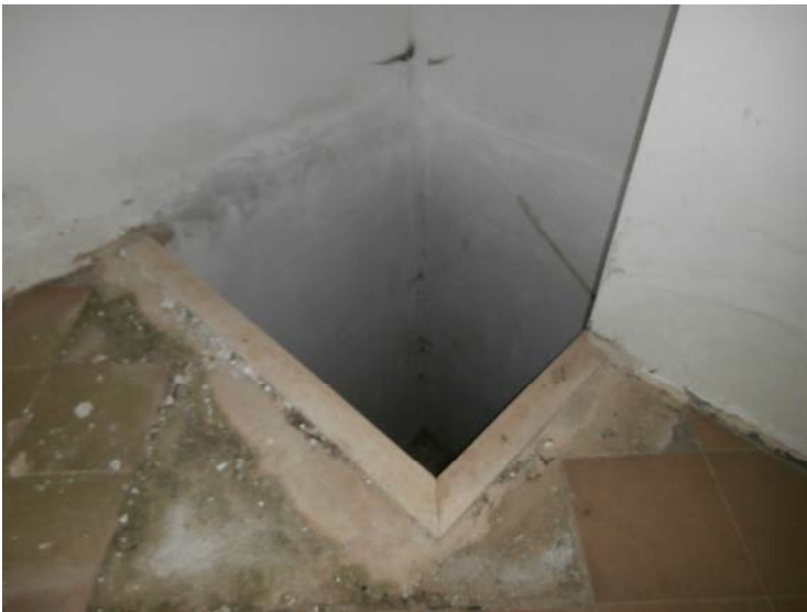
Edificio C: salone, vano per scale a chiocciola
