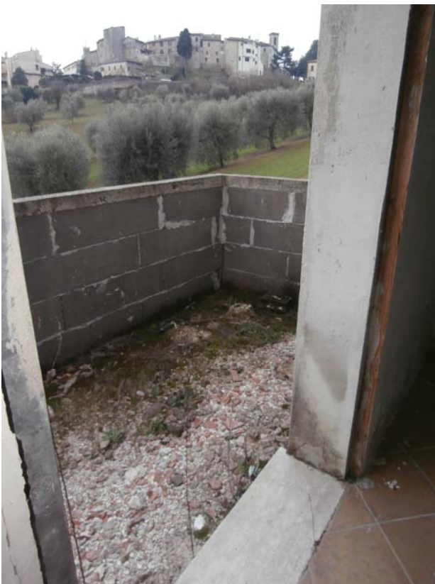
Edificio A: balcone
