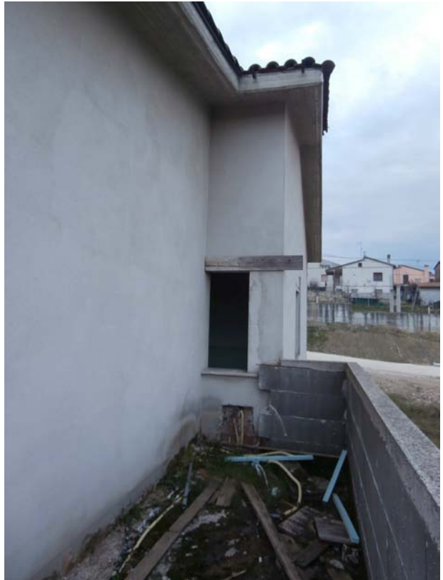
Edificio B: balcone
