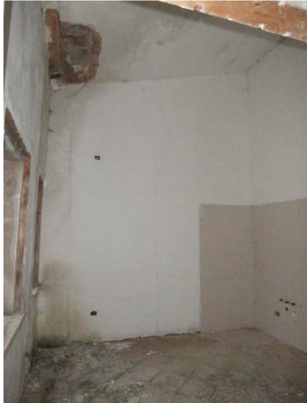
Edificio B: cucina
