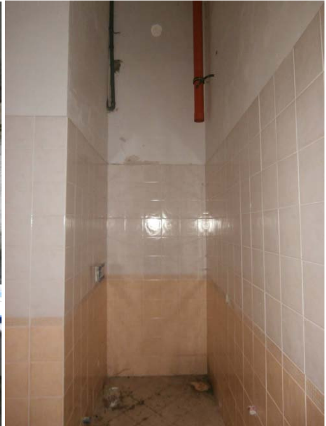
Edificio A: bagno
