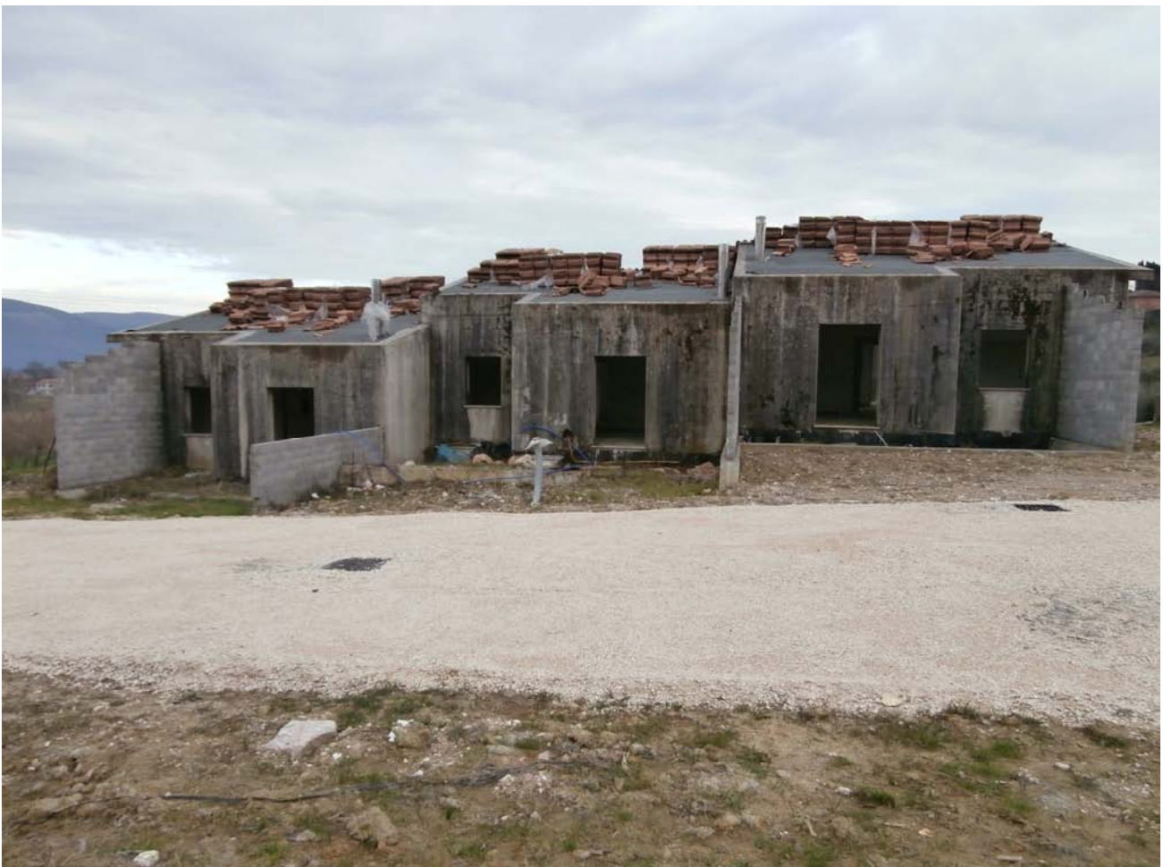
Edificio A: trifamiliare
