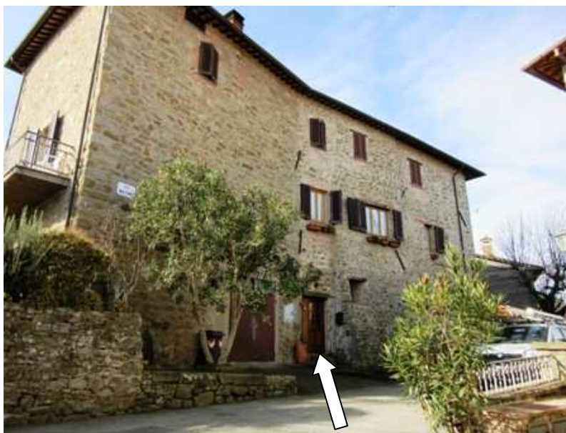
Vista Lato Via Mazzini (c/co n. 4)
