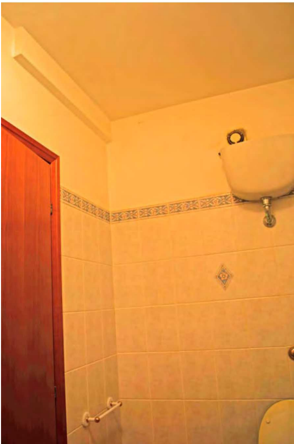
FOTO WC PT (foto n.20)
