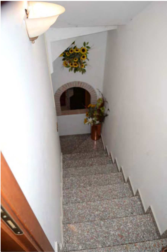
FOTO SCALA COLLEGAMENTO PT- S1 (foto n.21)
