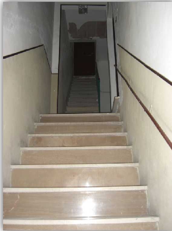
Vano scala di accesso all'unità immobiliare
