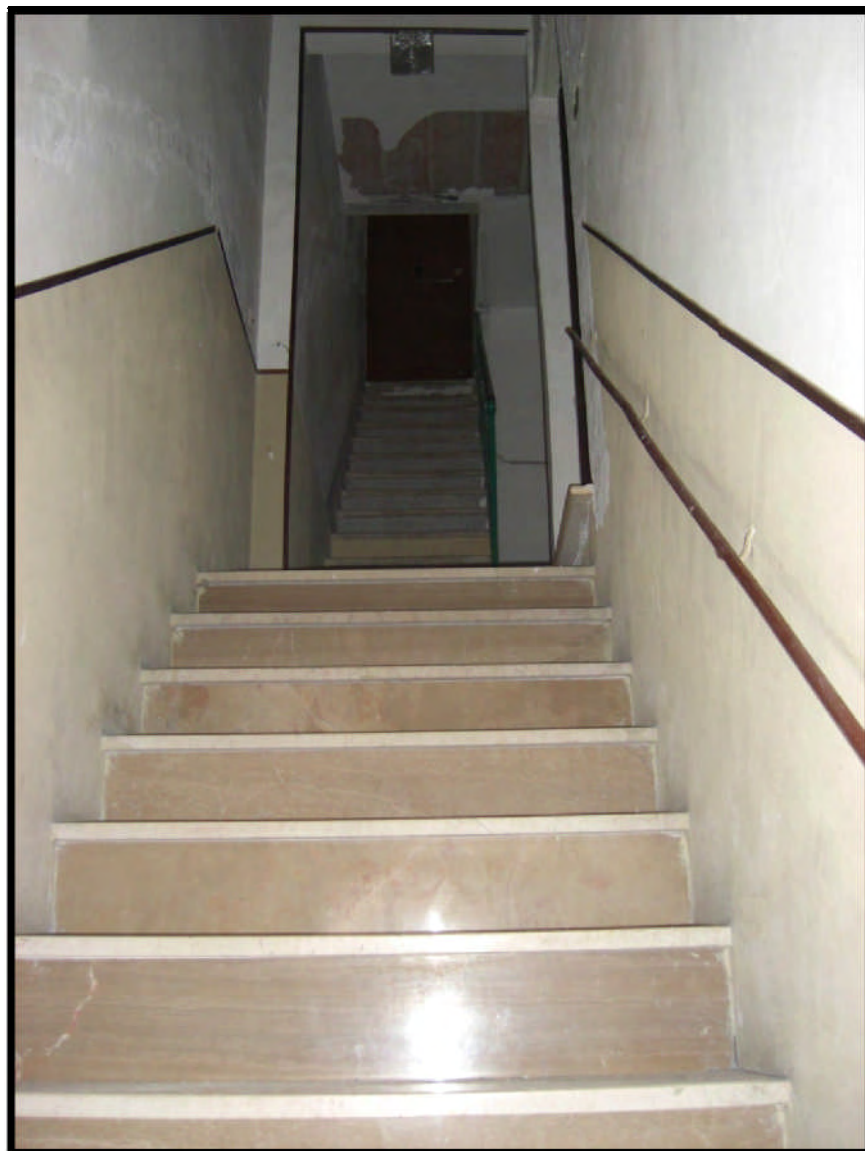
Vano scala di accesso all'unità immobiliare
