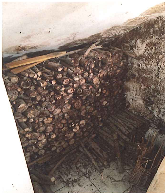
Illustrazione 27: ingresso di proprietà di altra ditta(sub.20)
