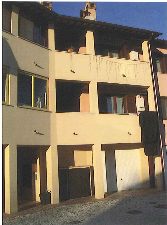
Illustrazione 11: prospetto lato sud appartamento al piano terra e autorimessa al piano seminterrato
