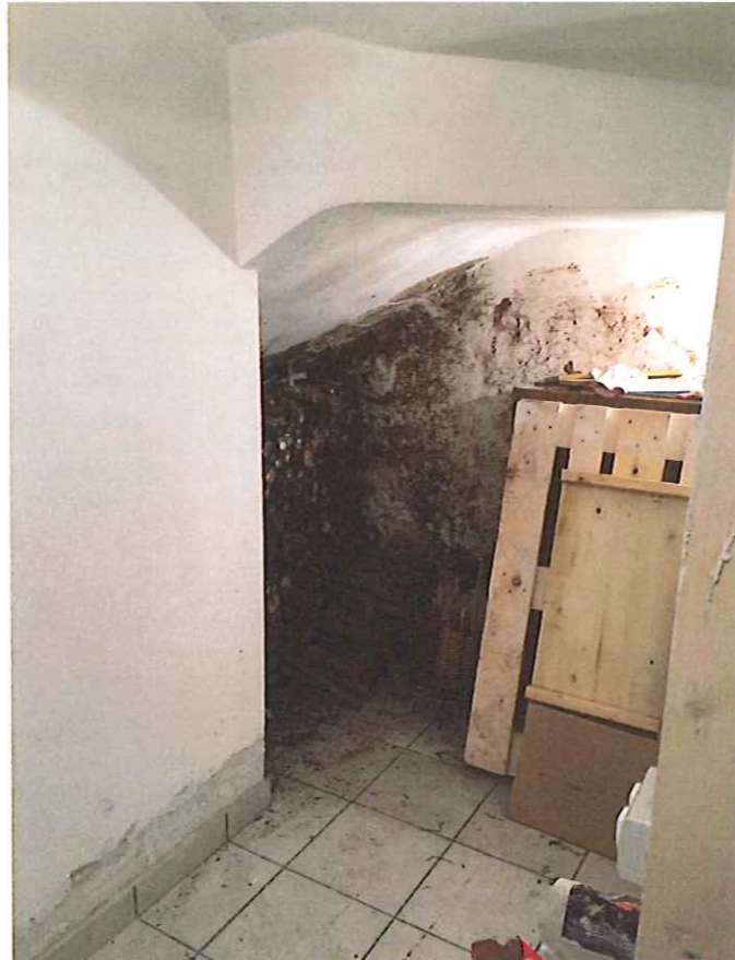
Illustrazione 26: ingresso di proprietà di altra ditta(sub.20)
