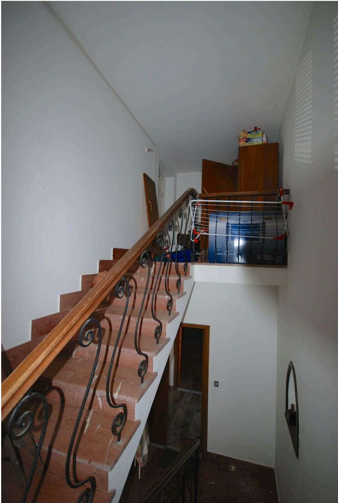
15_Foto del 26-08-2015_rampa comune di accesso al lastrico solare
