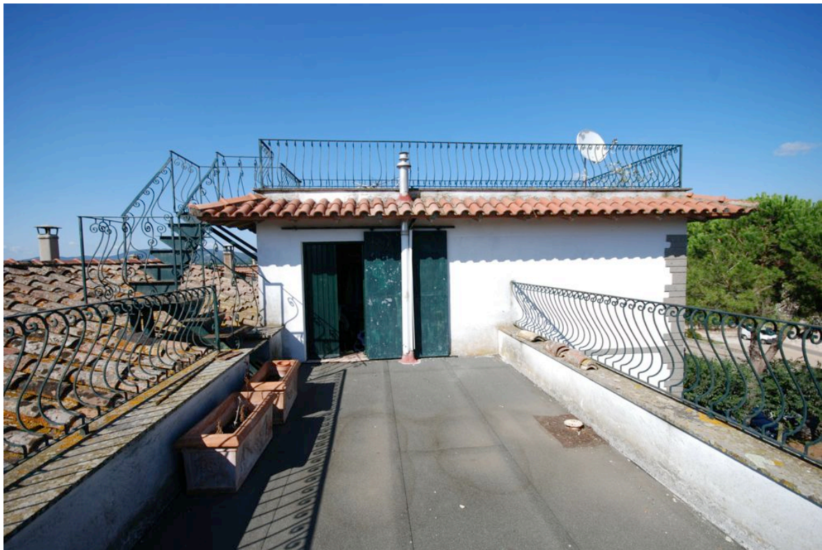
16_Foto del 26-08-2015_lastrico solare comune
