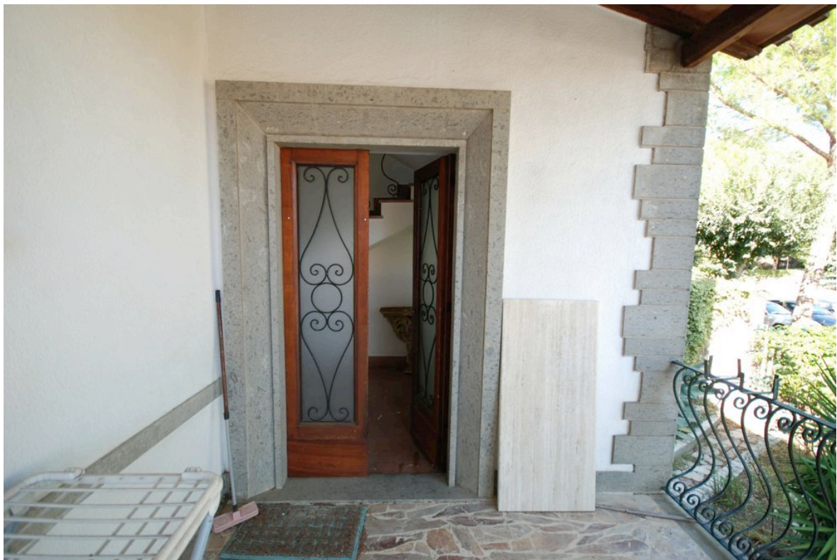
06_Foto del 26-08-2015_pianerottolo di ingresso al corpo scala comune
