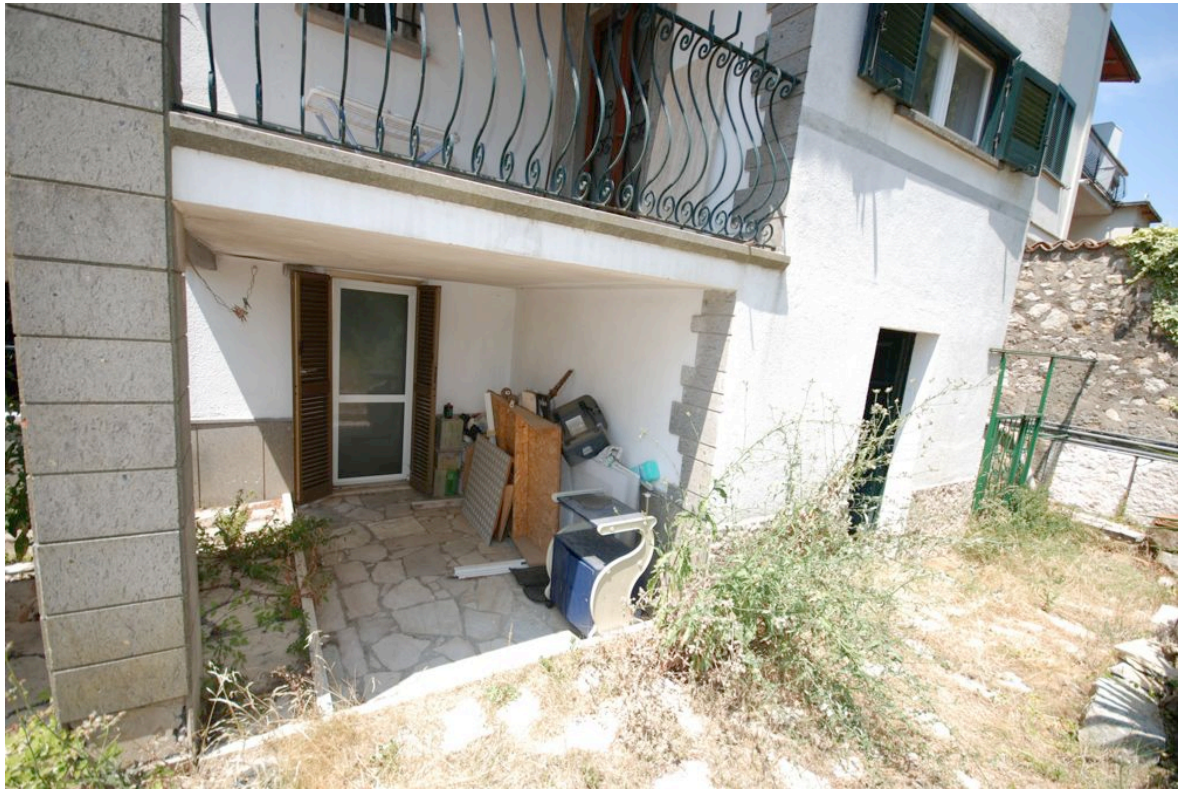
13_Foto del 22-07-2015_esterno, visto dalla corte comune di pertinenza
