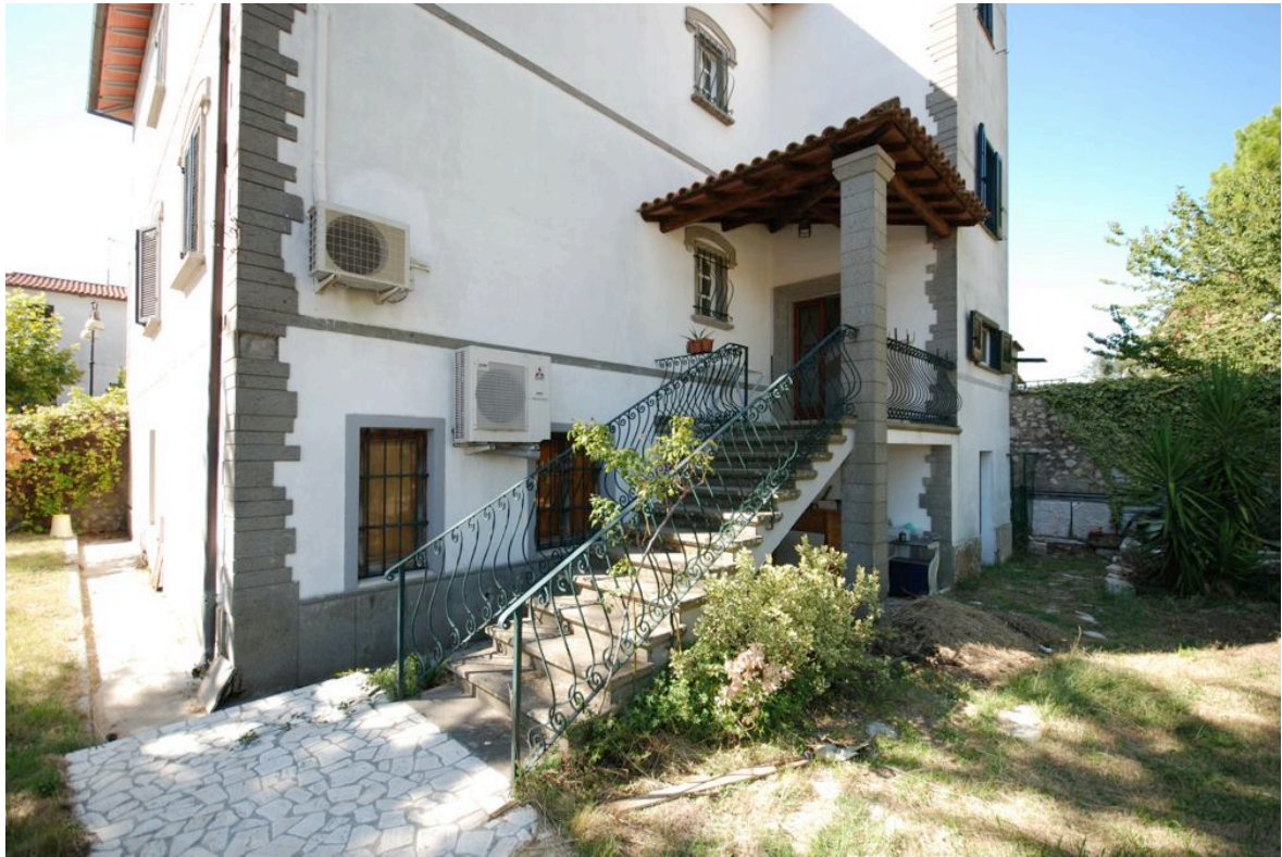
05_Foto del 26-08-2015_rampa di ingresso su corte di pertinenza comune
