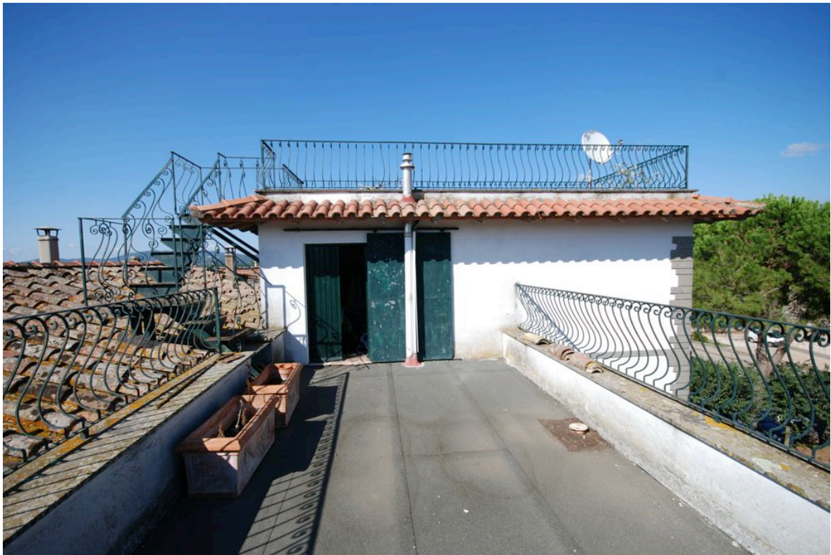
16_Foto del 26-08-2015_lastrico solare comune
