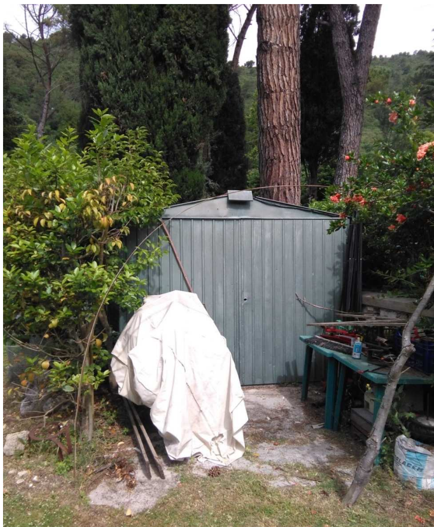
FOTO E – RIPOSTIGLIO ESTERNO – (corpo B)
