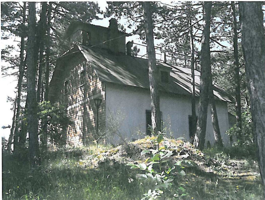
Prospetto Lato Strada Vicinale
