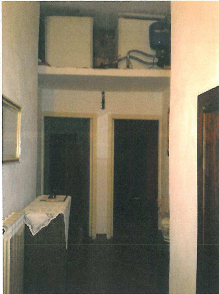
Piano Primo – Corridoio
