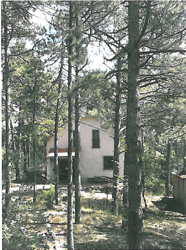
Panoramica Lato Ingresso
