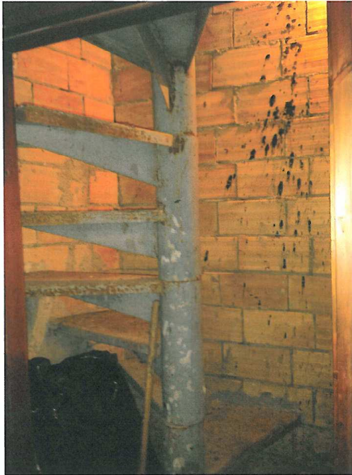
Piano Primo – Scala di Accesso alla Terrazza di Copertura
