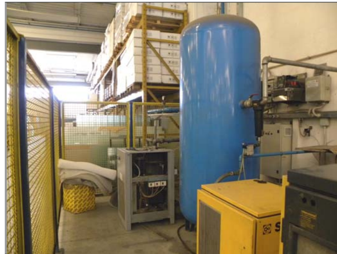
2) compressore, Kaeser- BSD 72 4) compressore, Kaeser - SK 19 + essiccatore, Friulair + serbatoio
