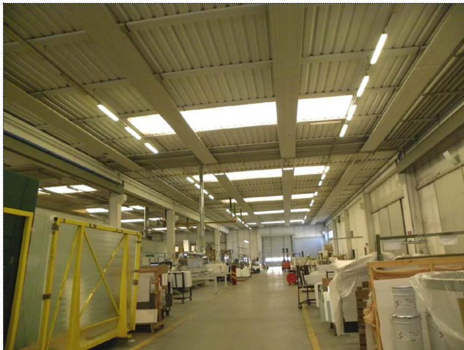
AT S.r.l. - compendio in Brugnera (PN): interni lavorazione
