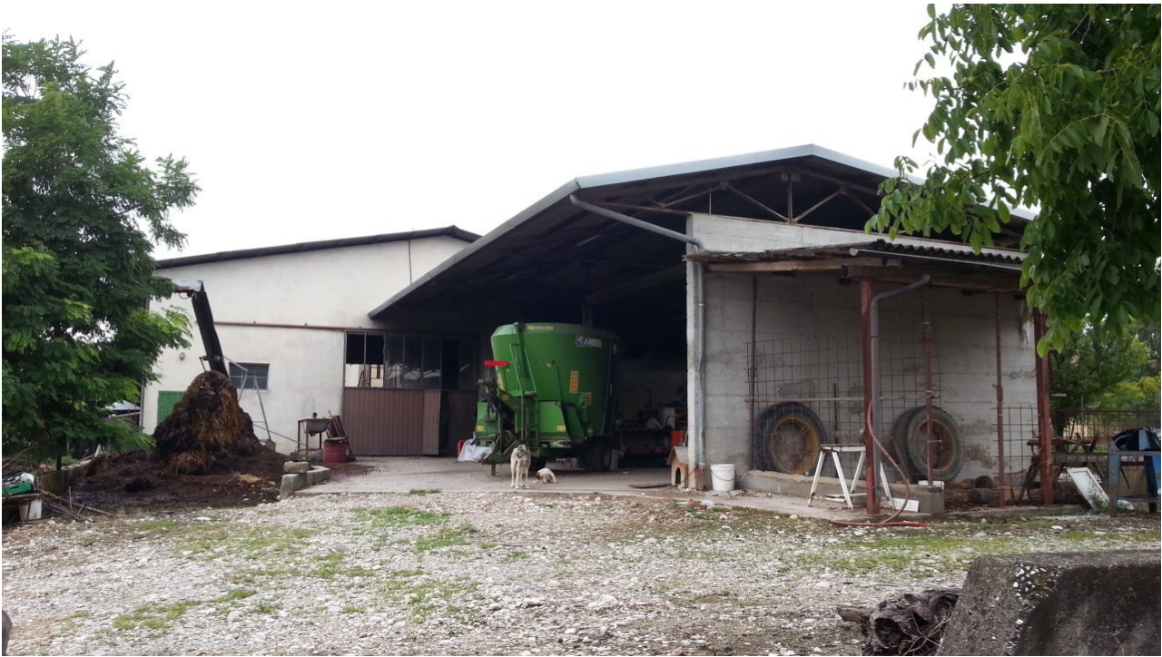
Foto n.3: Prospetto Sud della stalla e della tettoia (Sub.3) oggetto di E.I.
