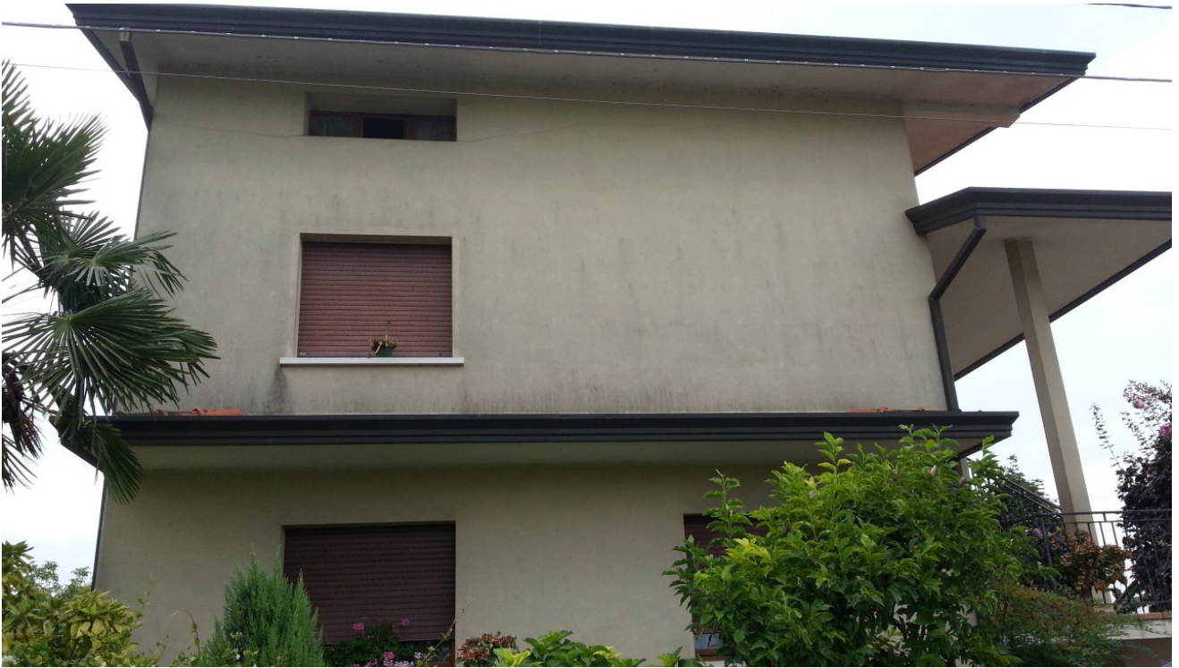
Foto n.7: Prospetto Nord dell'abitazione (Sub.1) oggetto di E.I.
