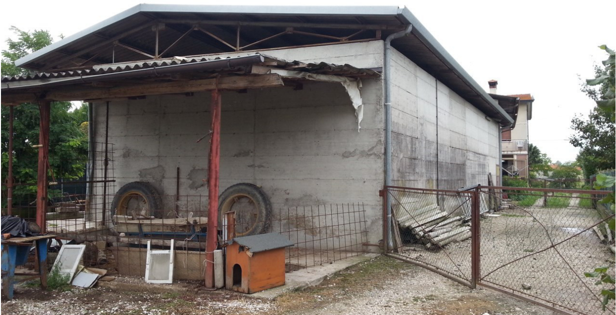
Foto n.4: Prospetto Sud-Est della tettoia (Sub.3) oggetto di E.I.
