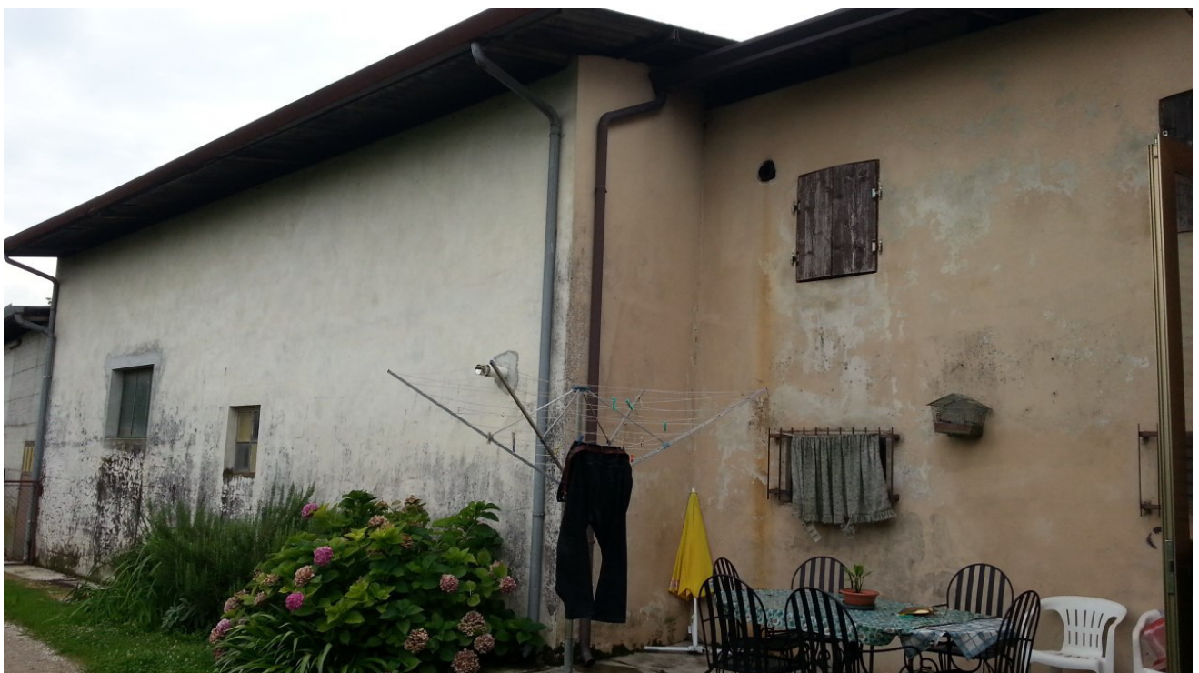
Foto n.6: Prospetto Est degli accessori (Sub.2-3) oggetto di E.I.
