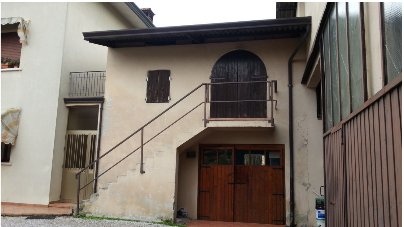
Foto n.8: Prospetto Ovest dell'accessorio pertinenziale all'abitazione identificato al Sub.2 oggetto di E.I.
