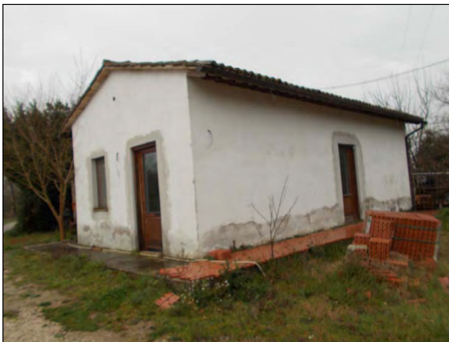
Foto n.2 (prospetto Sud - Est)
