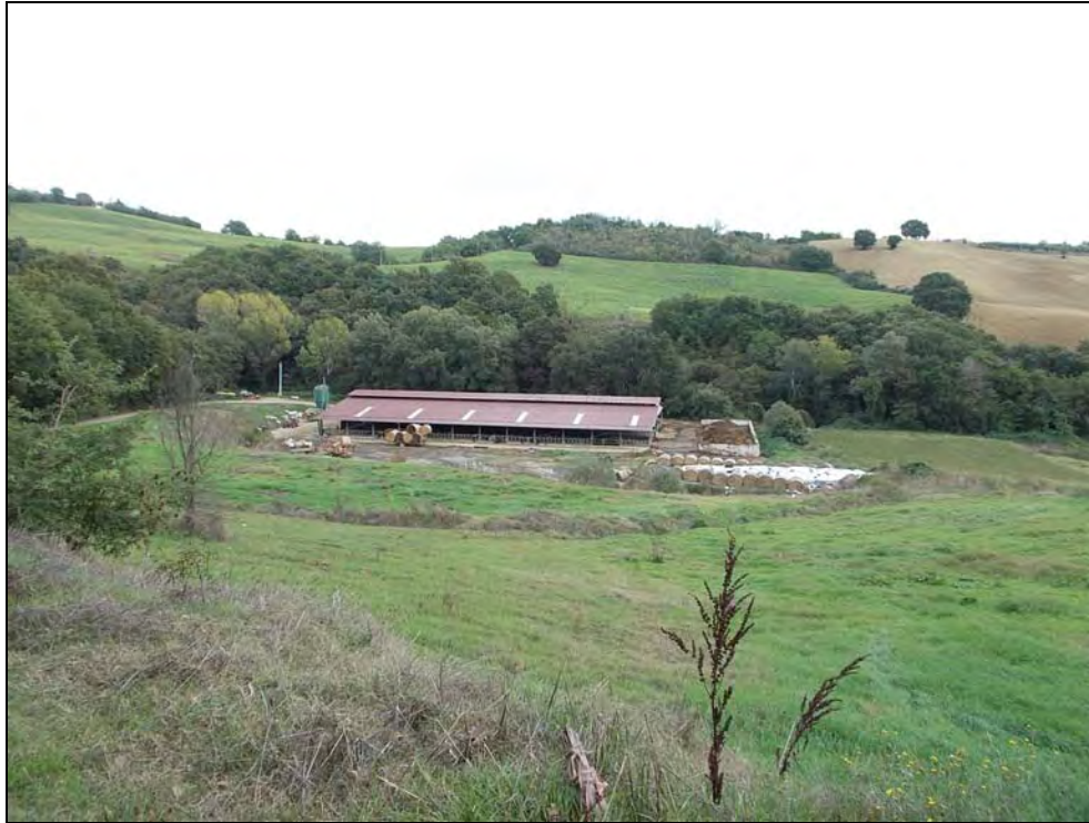
Foto n.1 (tettoia uso stalla e terreno pertinenziale)
