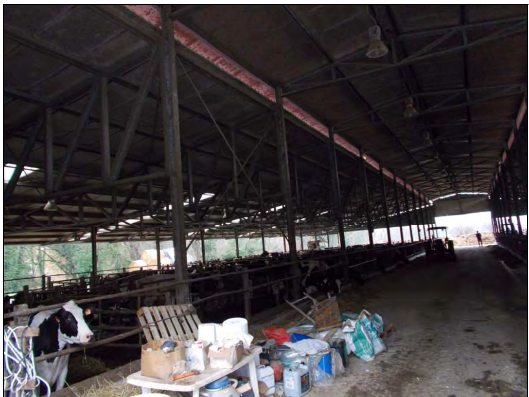
Foto n.8 (interno stalla lato Sud)
