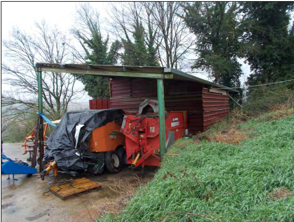
Foto n.2 (prospetto Nord - Ovest)
