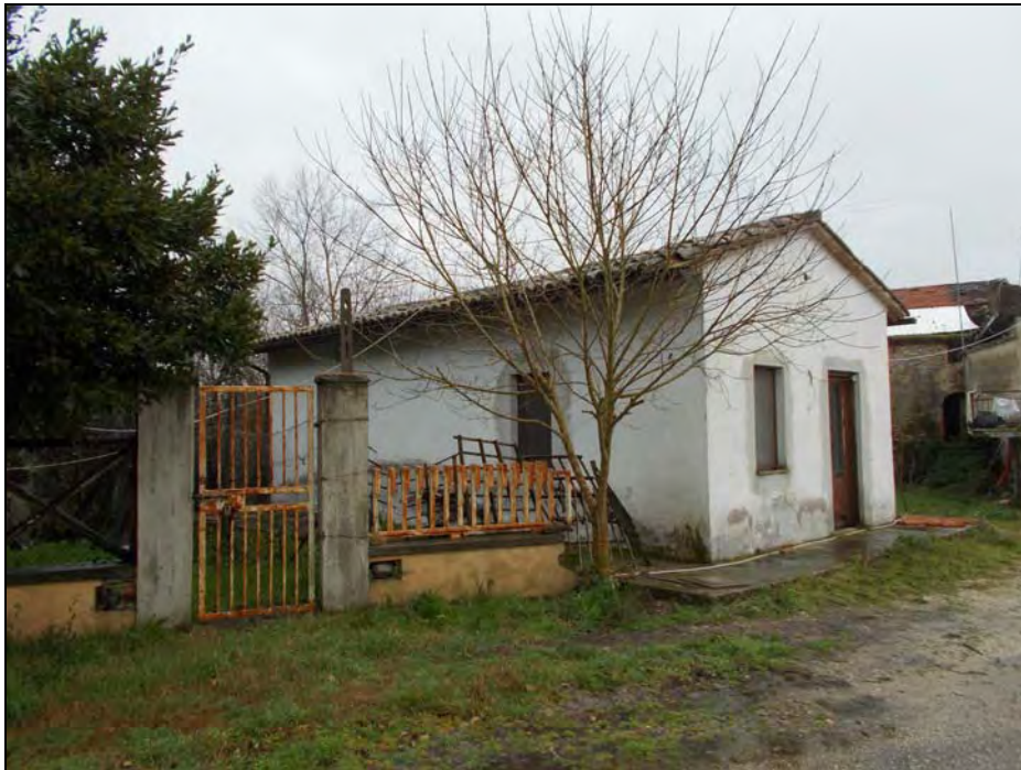
Foto n.1 (prospetto Nord - Ovest)
