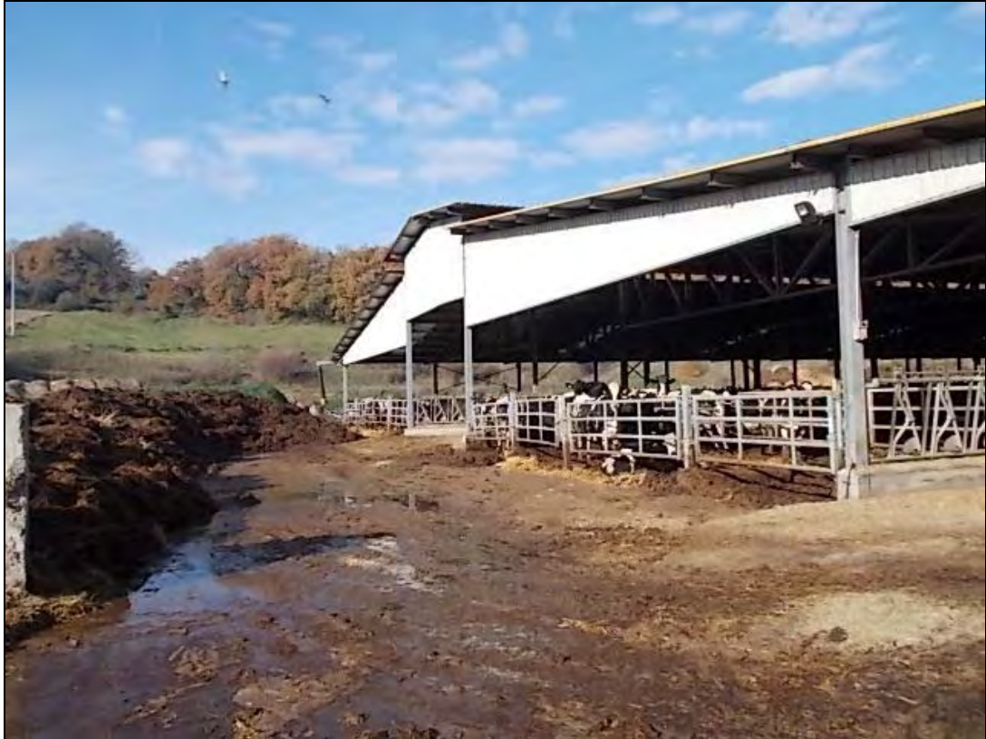
Foto n.7 (prospetto Ovest e concimaia)
