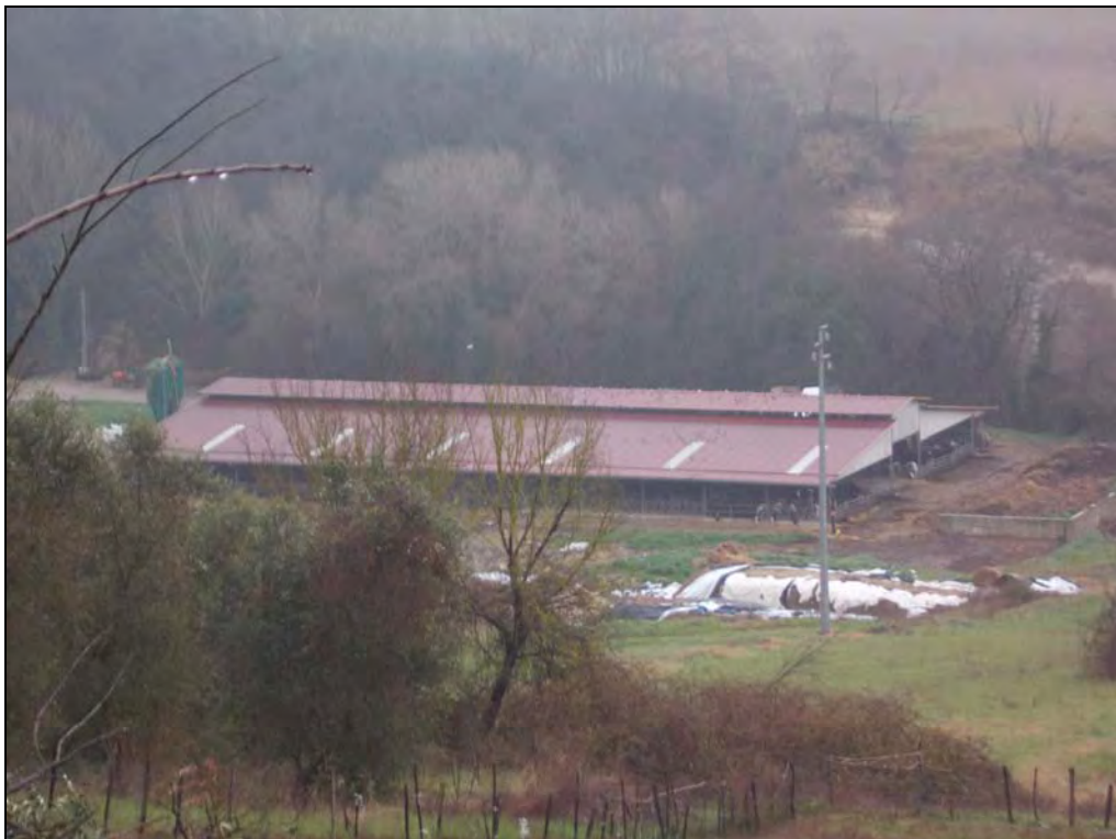
Foto n.2 (tettoia uso stalla e terreno pertinenziale)
