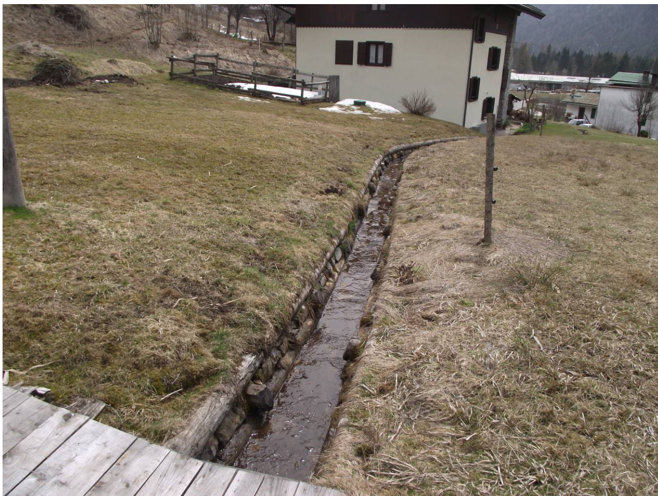
Foto 7 – canaletta a confine con il mapp. 698
