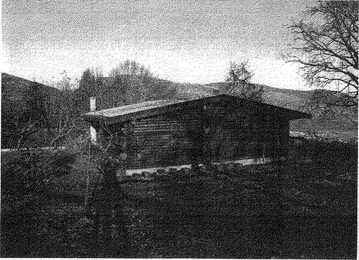
Fotografia abitazione lato sud
