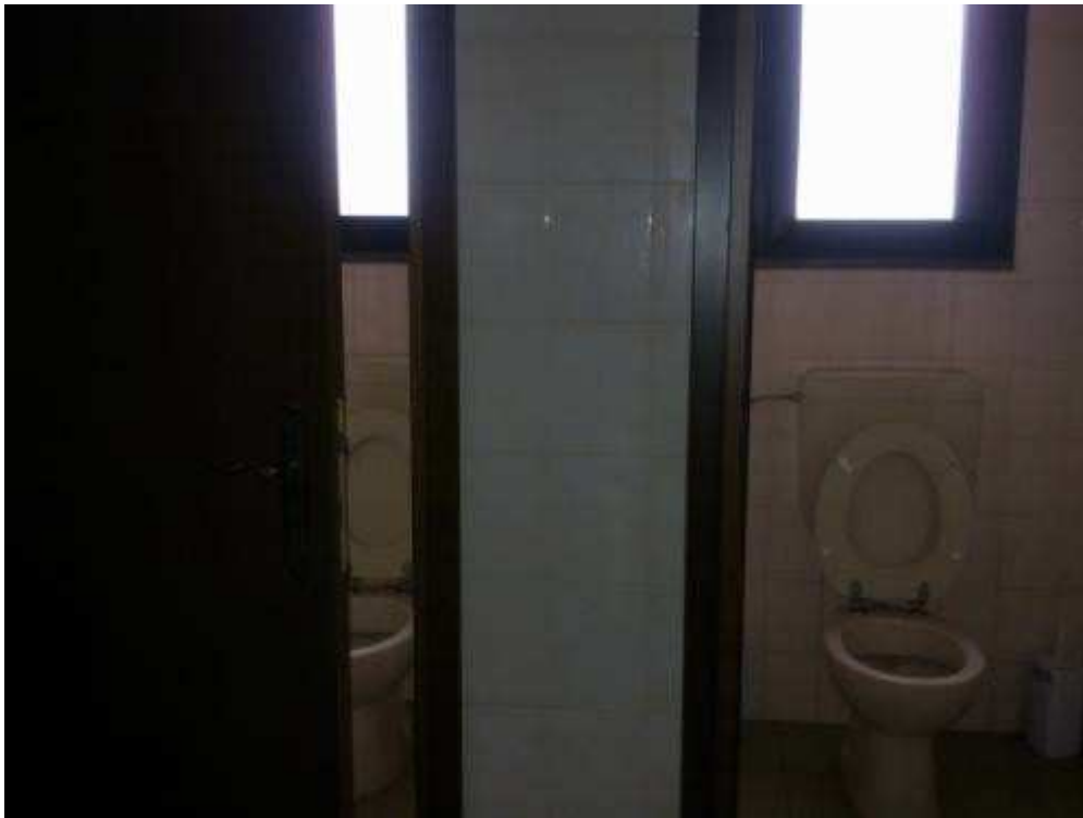
Foto 11 Bagni piano terra
