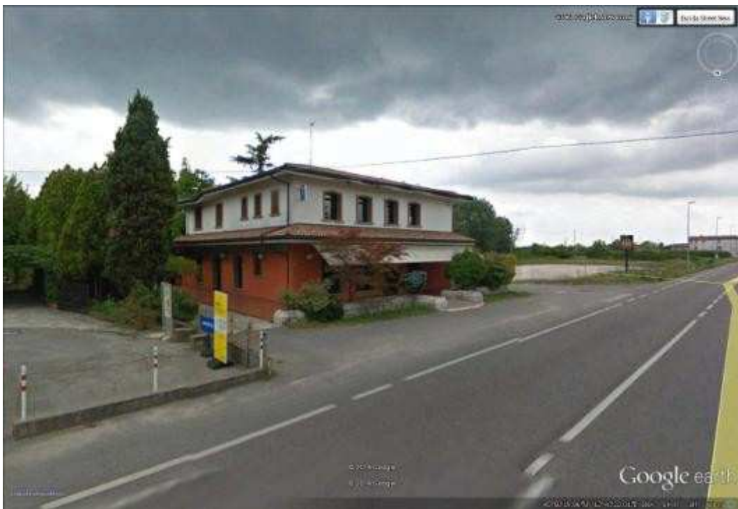
Foto 1 Vista del fabbricato da Via Marconi
