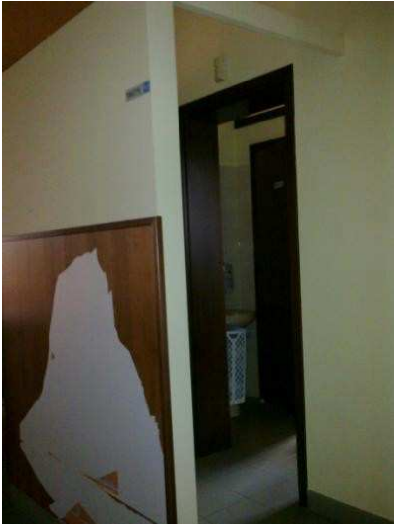
Foto 10 Antibagno piano terra
