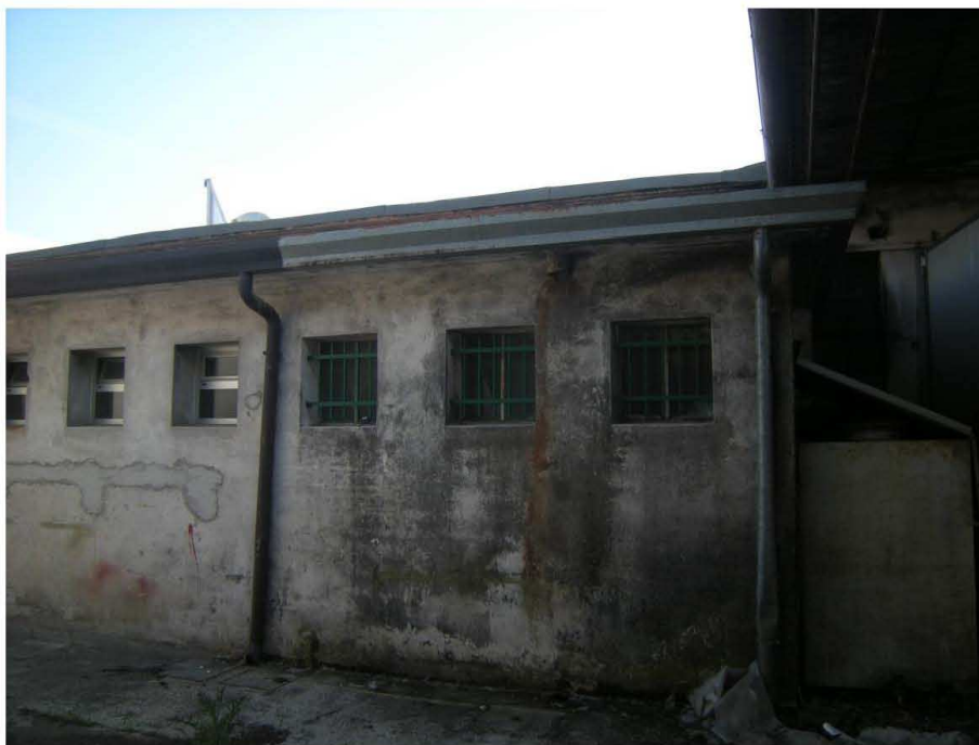
Prata di Pordenone, Particella 629 – Il prospetto del Capannone a sud -ovest.
