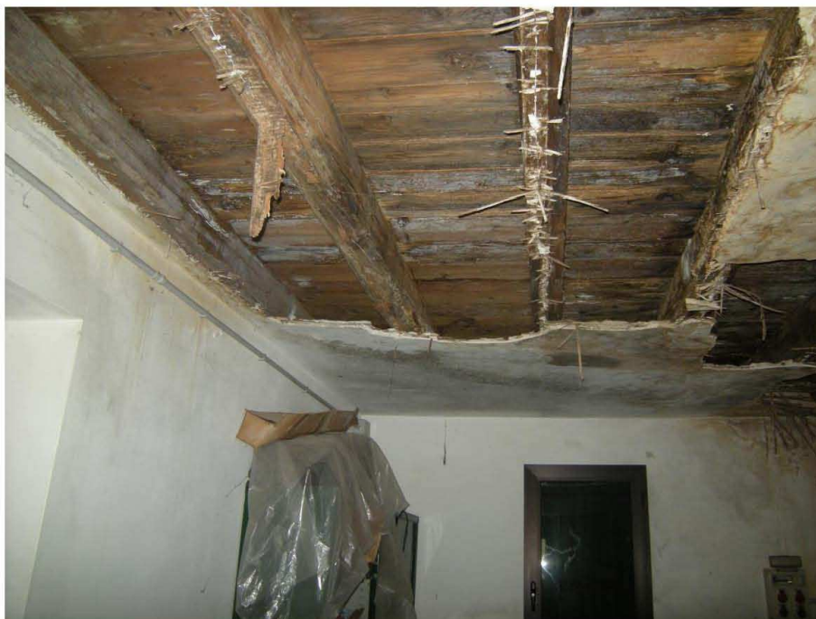
Prata di Pordenone, Particella 629 – L'immobile al piano terra con destinazione d'uso ripostiglio n° 2.
