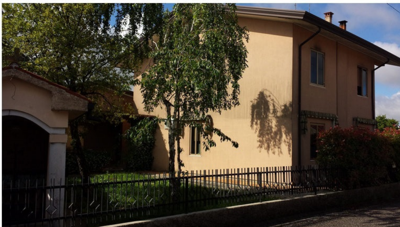
3 - particolare vista lato est
