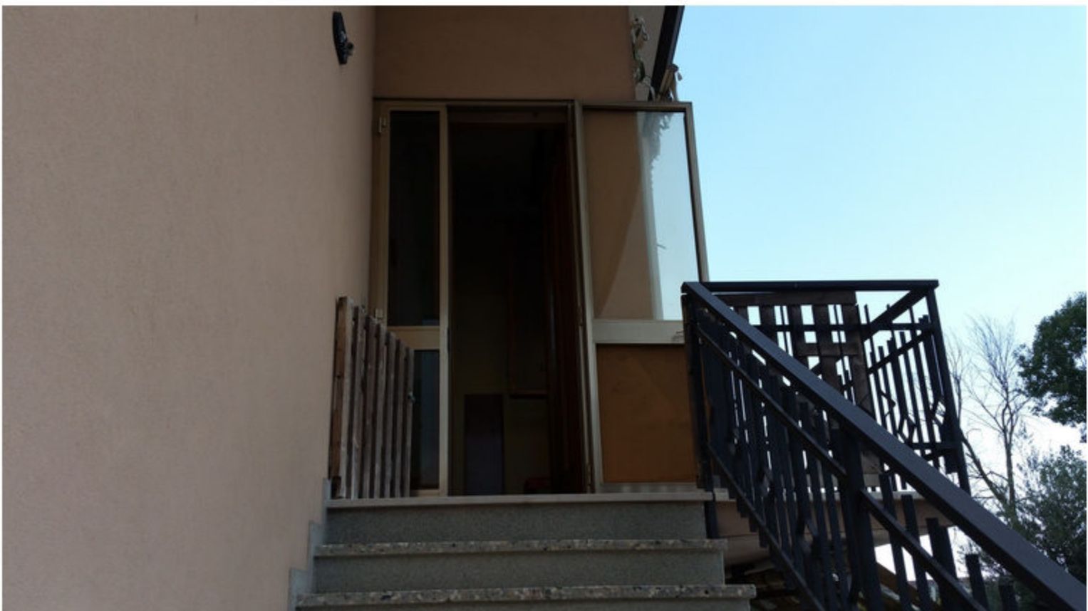
24 - accesso principale vista scala
