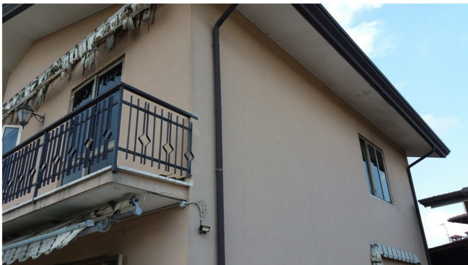
2 - particolare vista lato sud ovest
