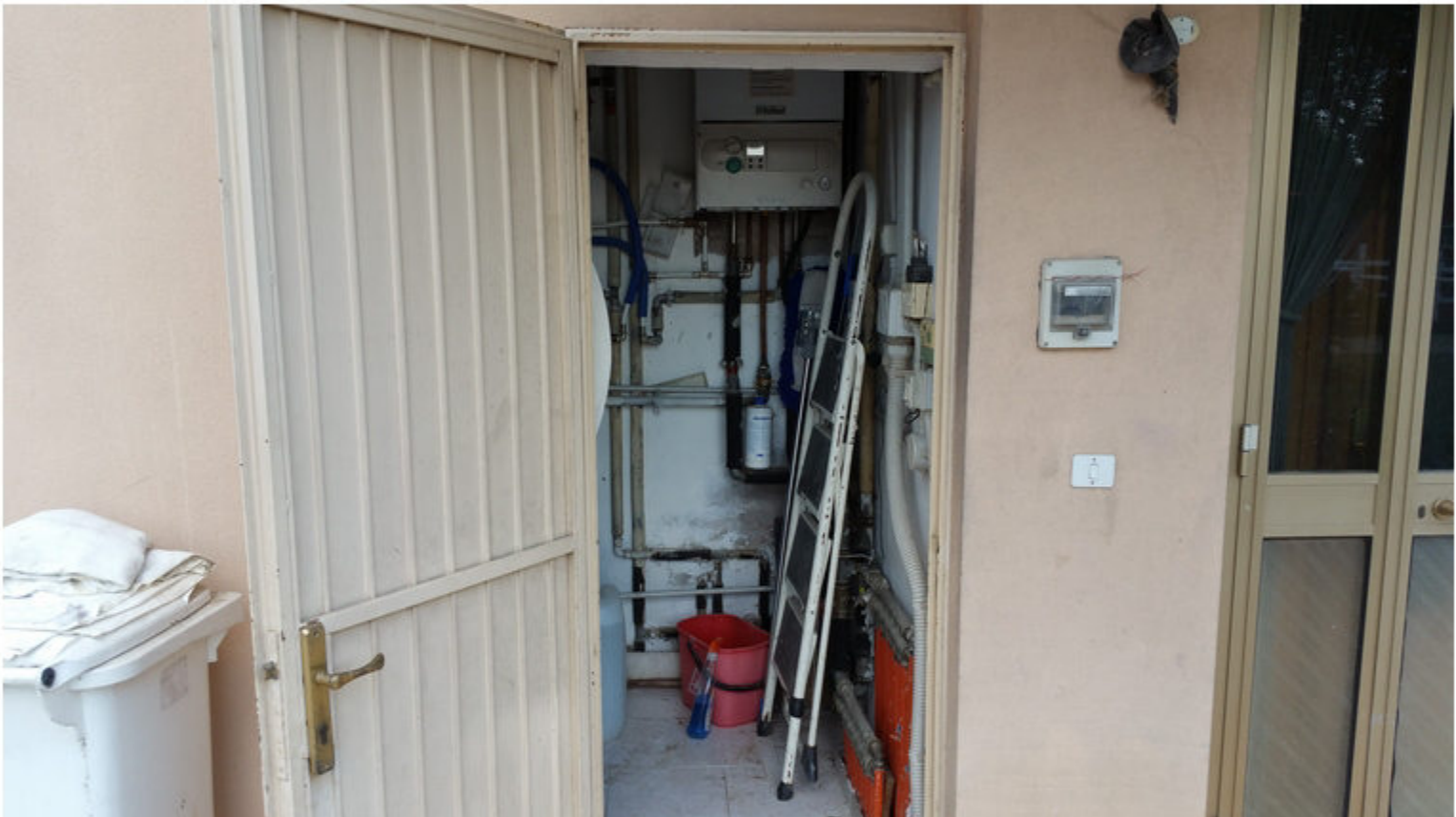
11 - vista accesso alla CT
