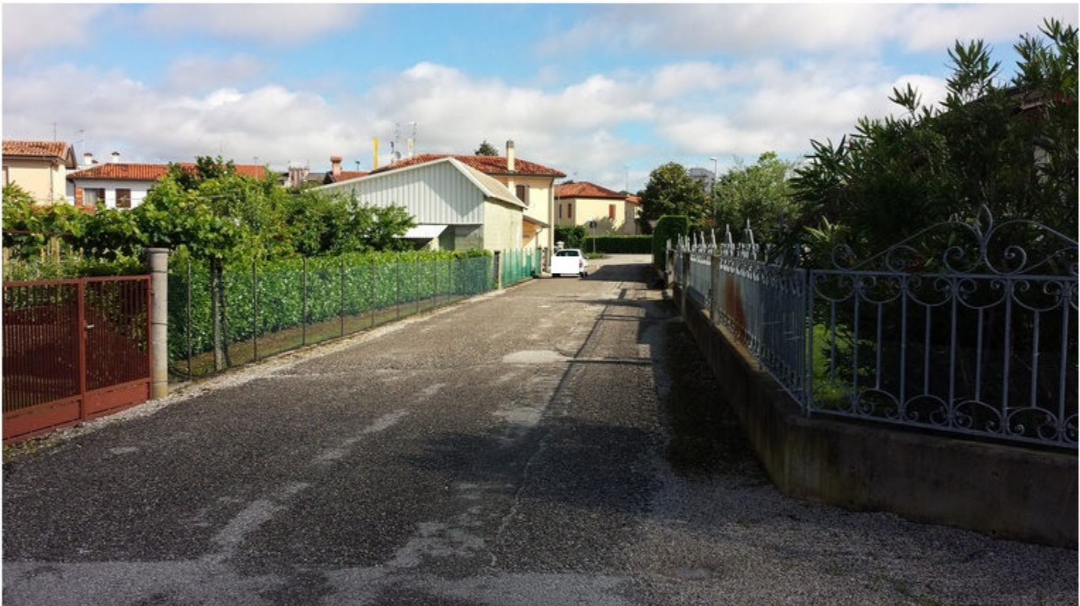
14 - particolare strada accesso da viabilità principale
