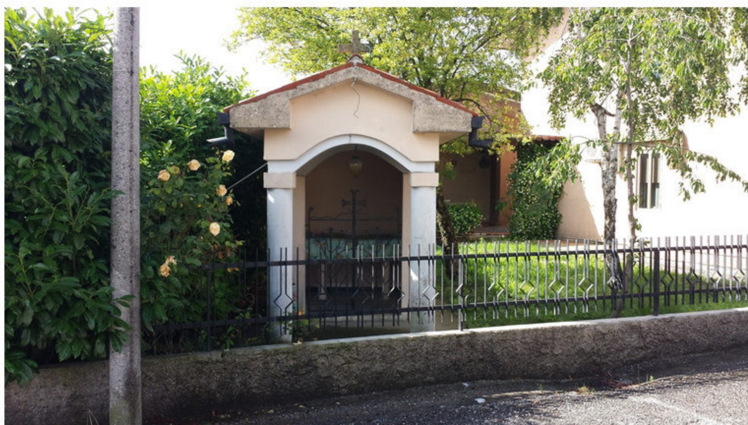
18 - particolare altra ui fronte
