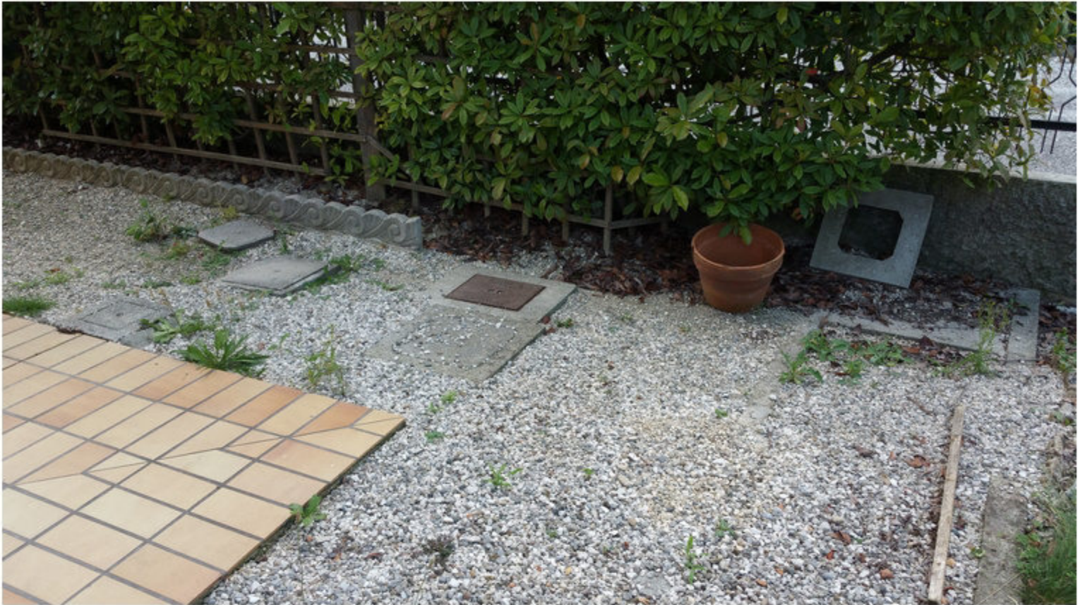
22 - particolare pozzetti su corte
