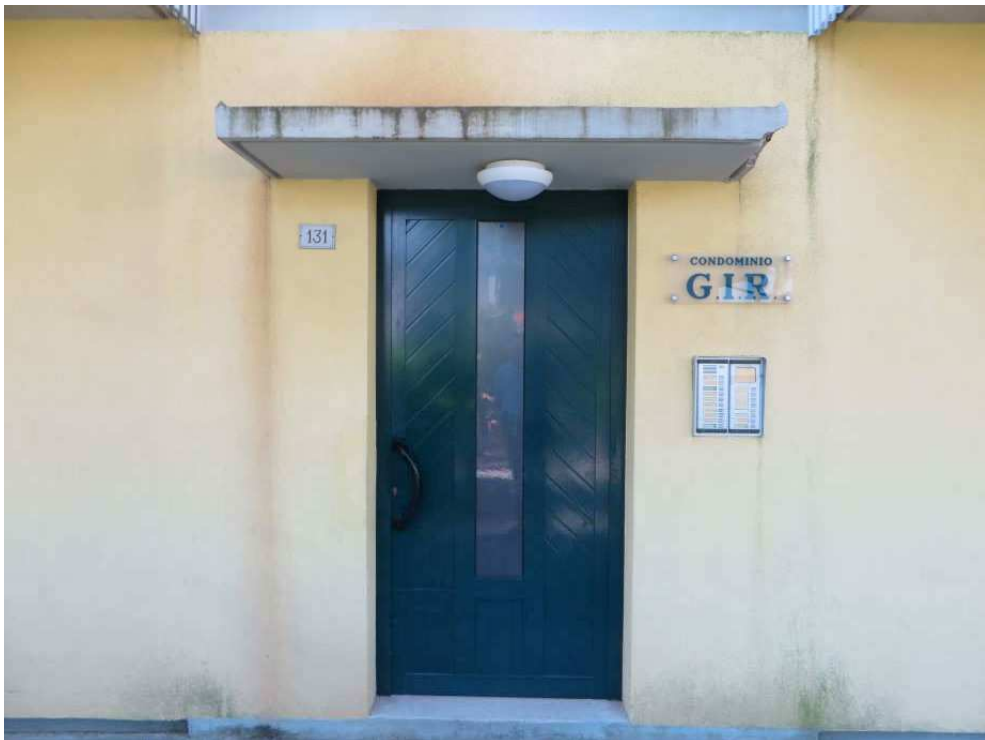
FOTO 8: PORTA PRINCIPALE D'ACCESSO CONDOMINIALE
