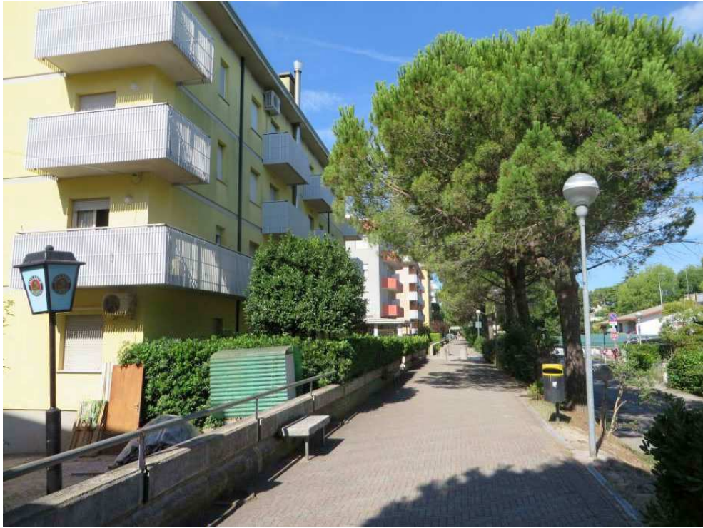
FOTO 5: VIALE PEDONALE PARALLELO A VIA TERRA
