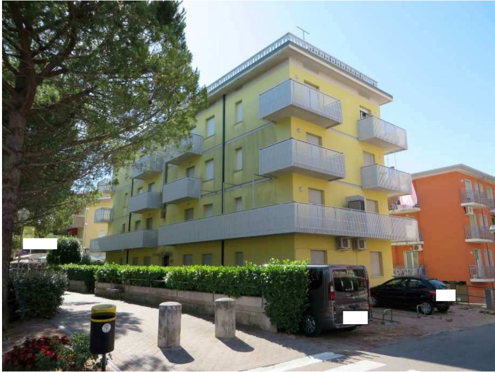
FOTO 1: PANORAMICA FRONTALE DEL CONDOMINIO GIR
