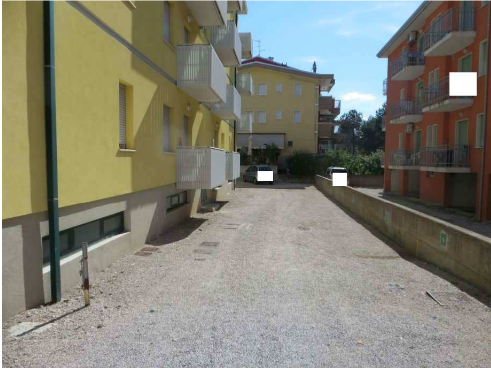
FOTO 9: VIALE CARRAIO E PARCHEGGI CONDOMINIALI
