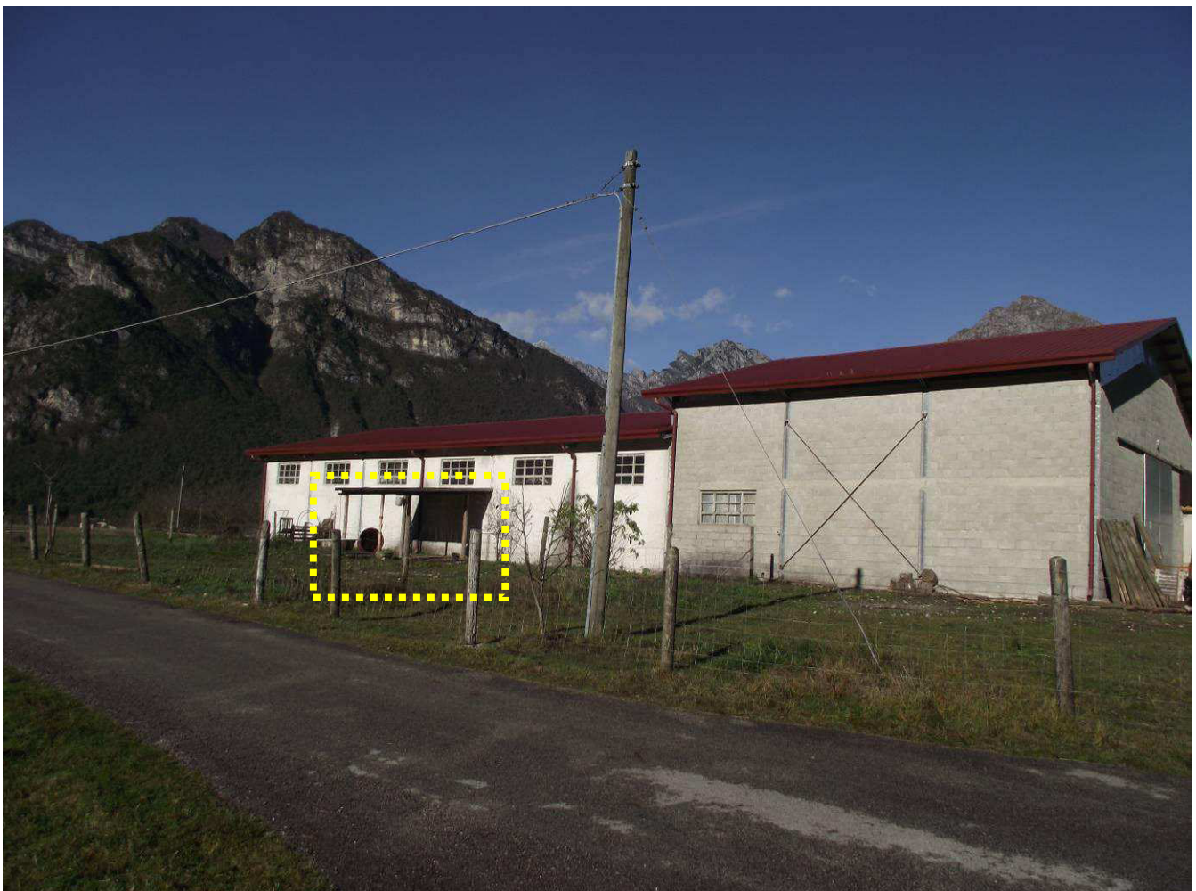
Foto 4 – prospetto laterale su via Pra di Leva (tettoia precaria evidenziata)
