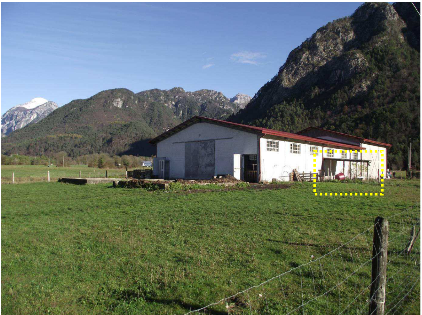
Foto 5 – prospetto retrostante (tettoia precaria evidenziata)
