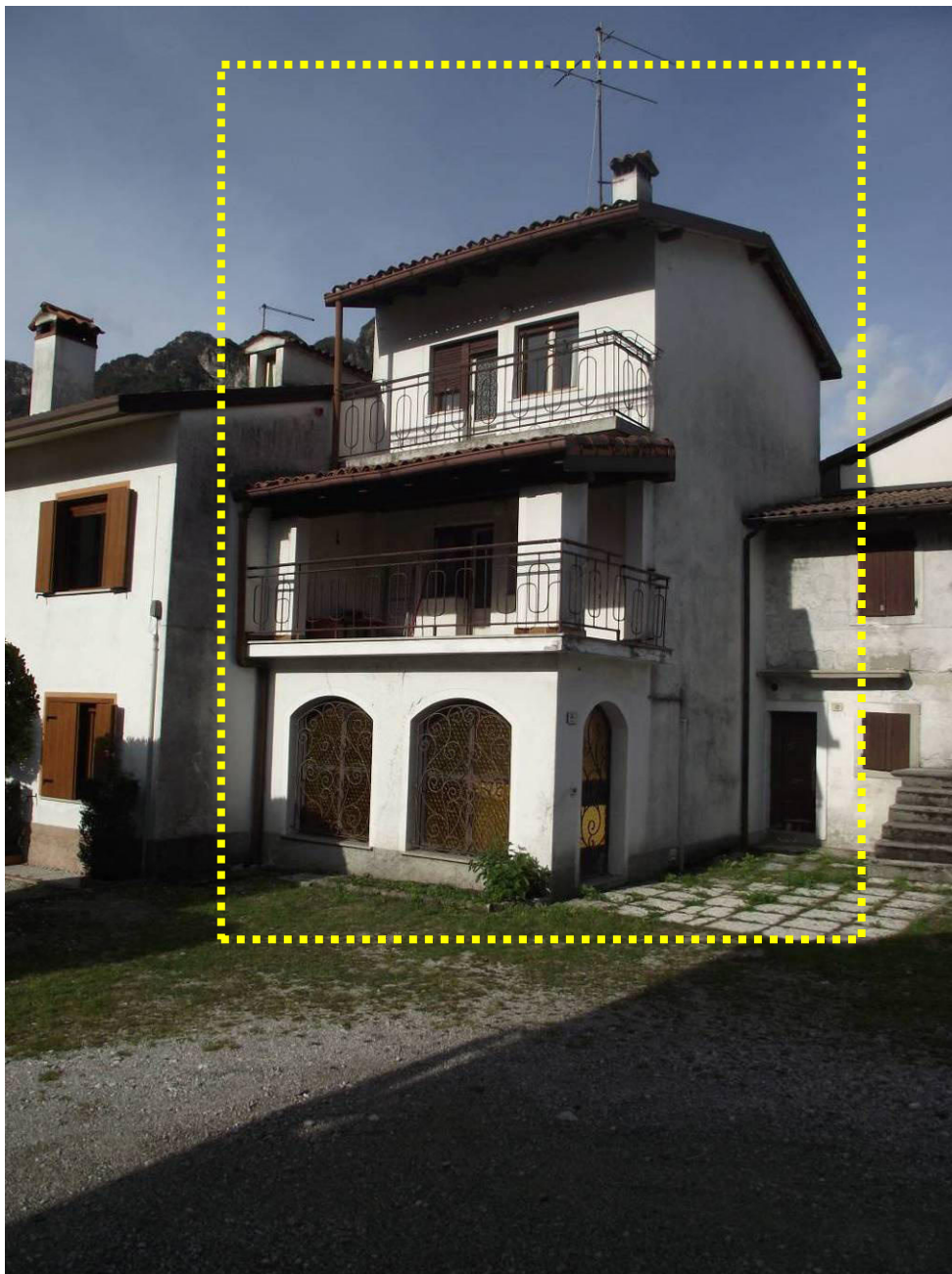
Foto 2 – Vista dall'esterno della pozione di edificio interessata
