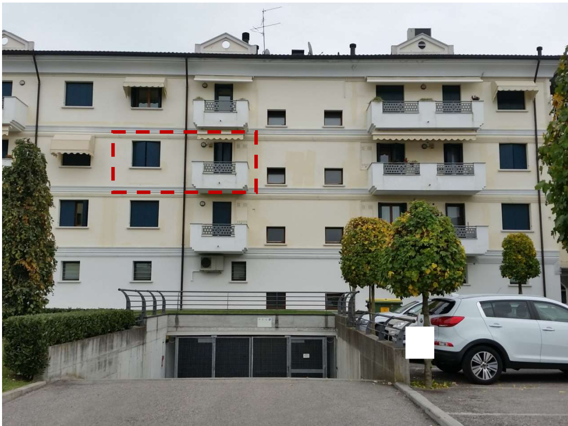
Prospetto su via Borghetto
