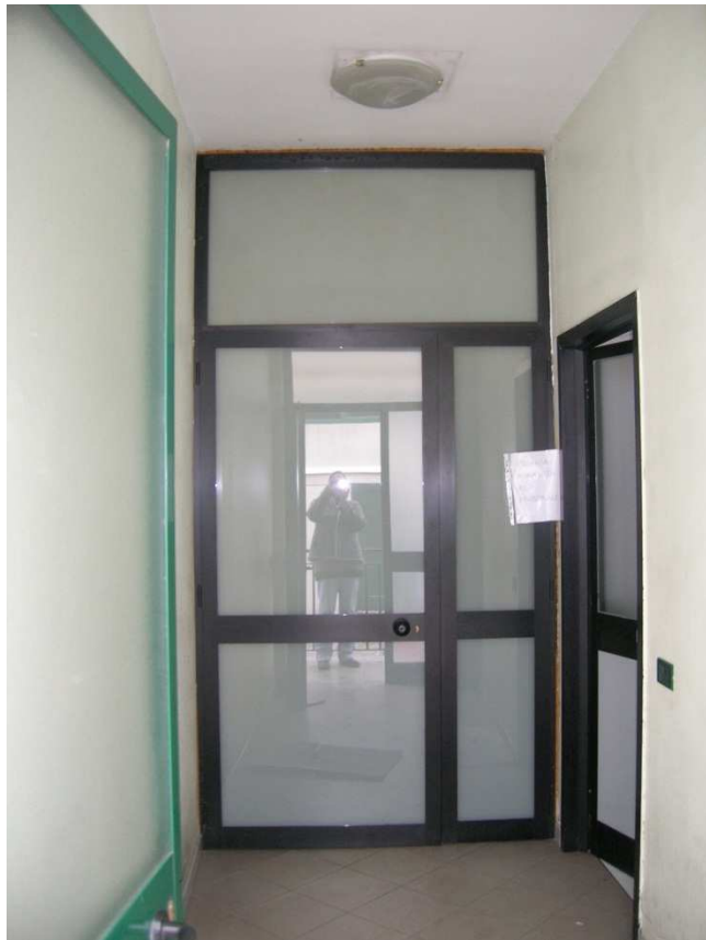
Foto n°22: Ingresso secondario dalle scale sul retro.
