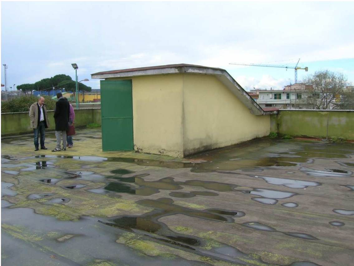
Foto n°28: Terrazzo di Copertura.
