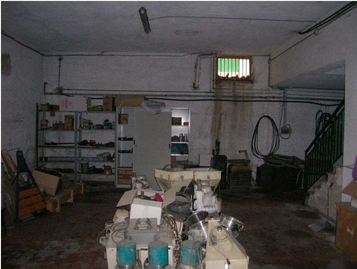
Foto n°24: Seminterrato adibito a deposito stanza 1.
