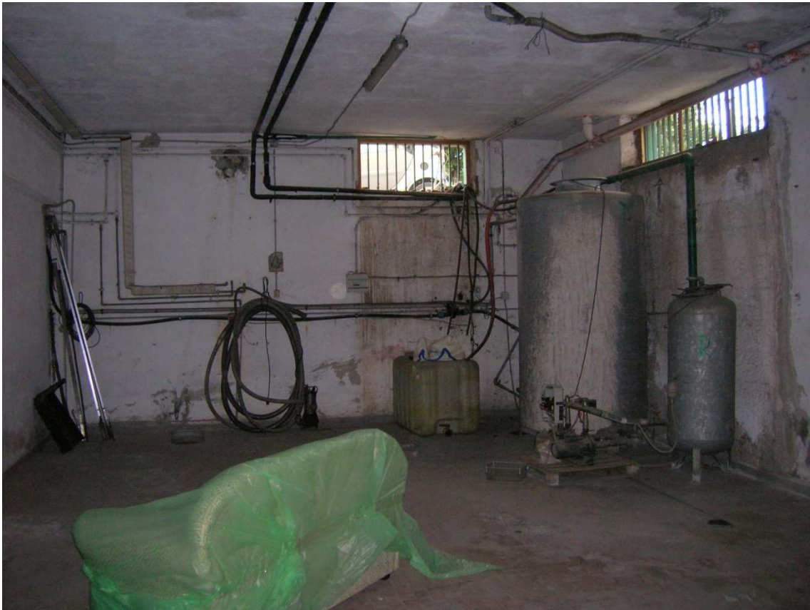
Foto n°26: Seminterrato adibito a deposito stanza 2.
