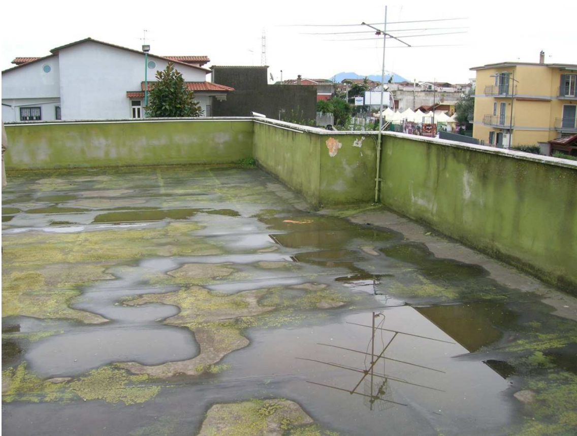
Foto n°29: Terrazzo di Copertura.
