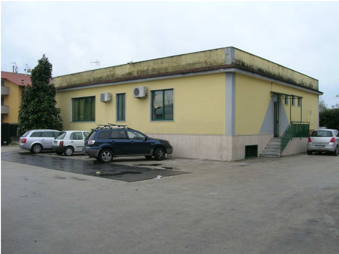
Foto n°: 23 Ingresso sul retro all'Edificio Ufficio.
