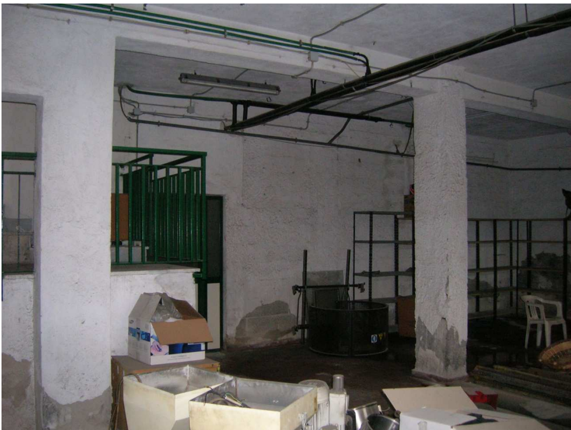
Foto n°23: Seminterrato adibito a deposito stanza 1.
