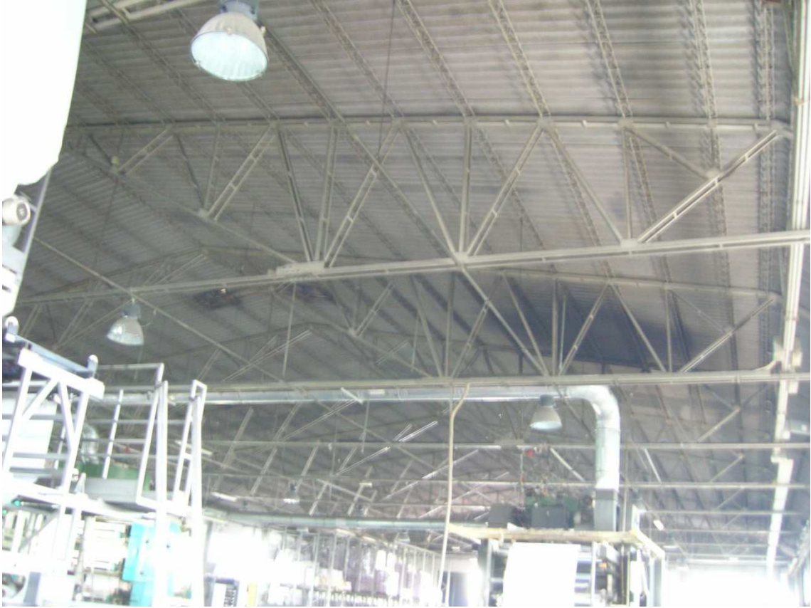
Foto n°36: particolare tetto Capannone.
