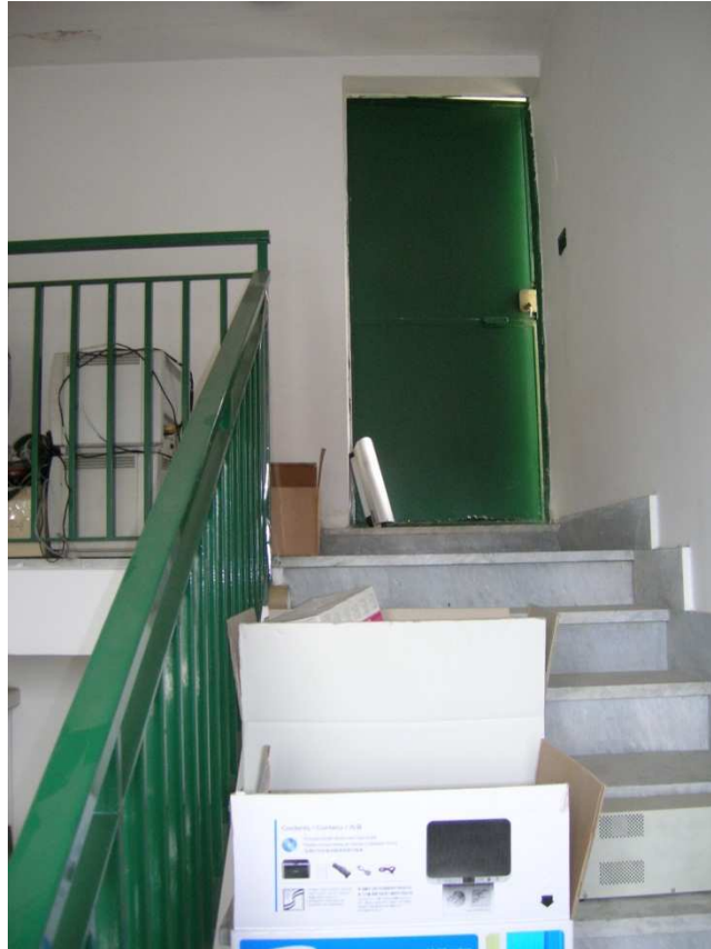
Foto n°27: Scale interne che accedono al terrazzo di copertura.
