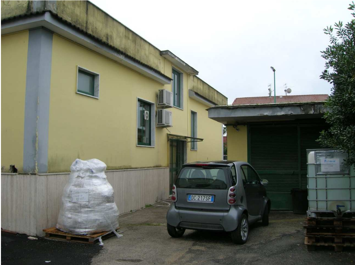
Foto n°39: cabina elettrica e uscita laterale Uffici .
