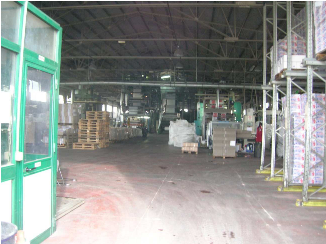
Foto n°31: interno del Capannone Industriale.
