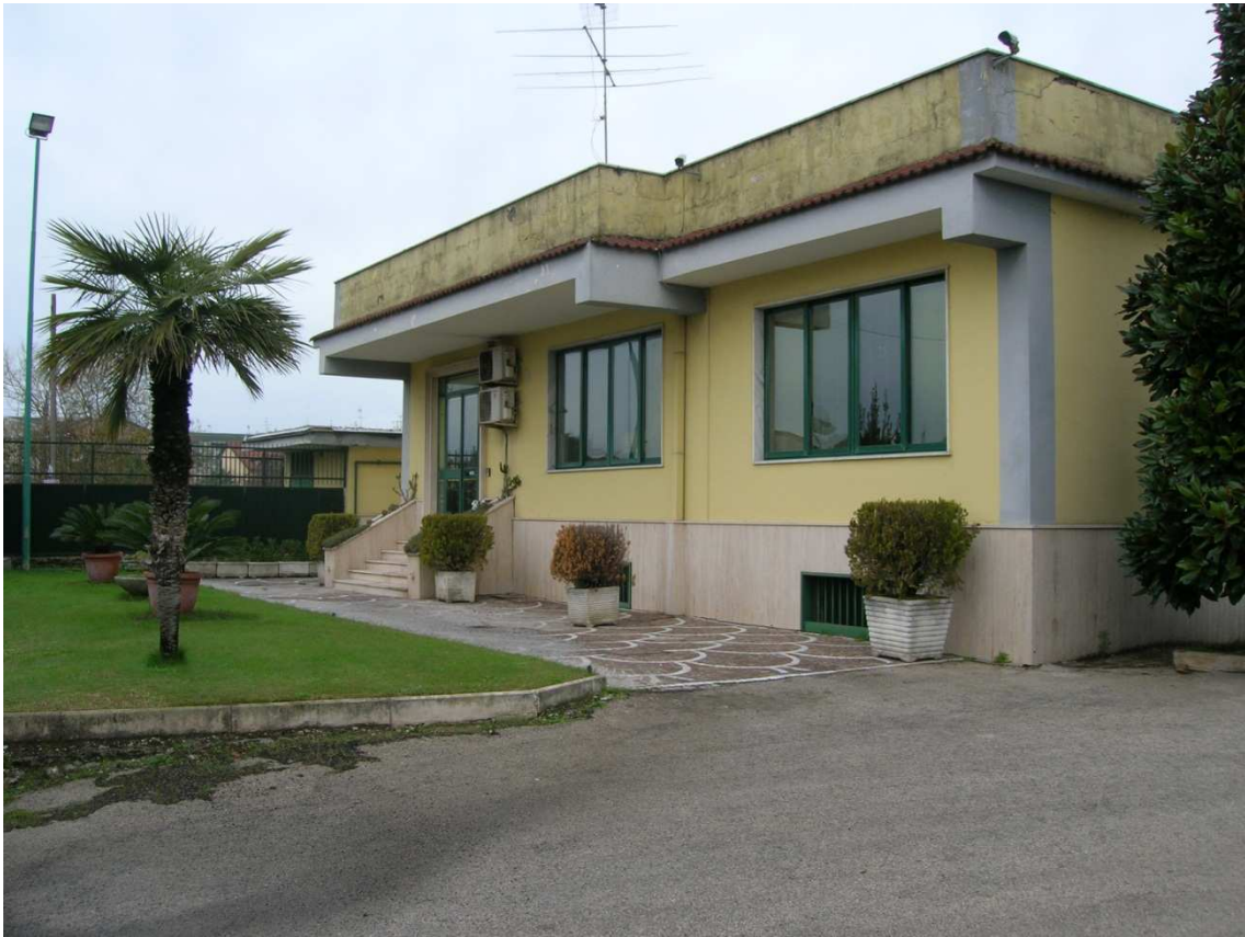
Foto n°9: Ingresso principale Edificio Uffici.
