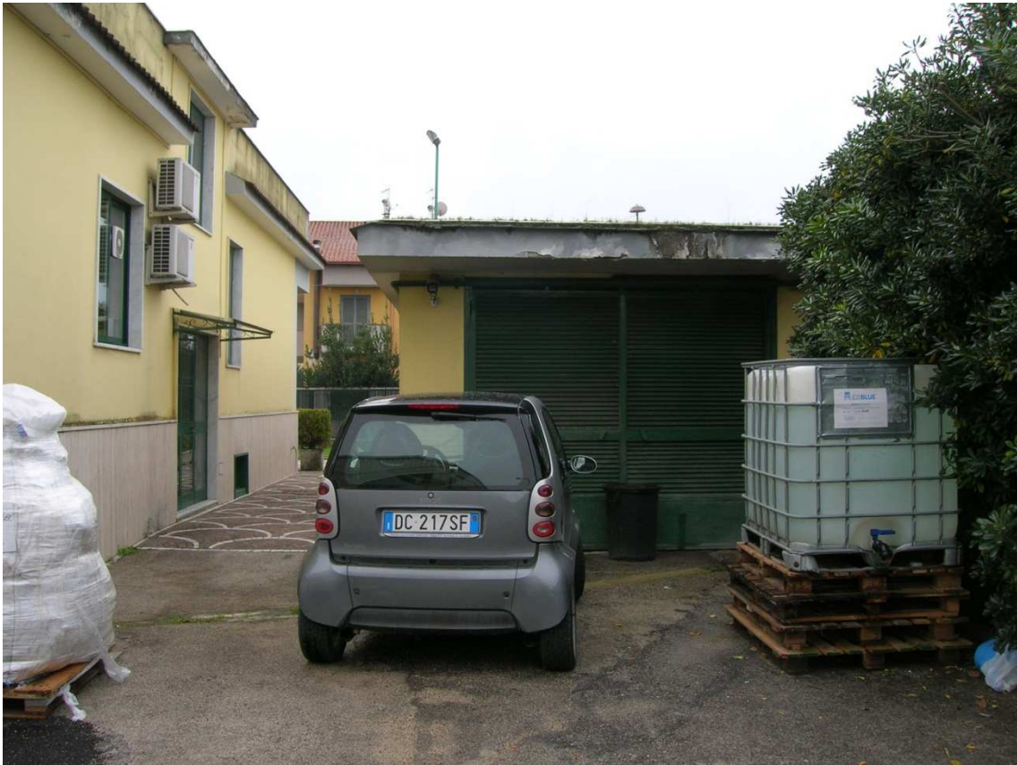
Foto n°38: cabina elettrica e uscita laterale Uffici .
