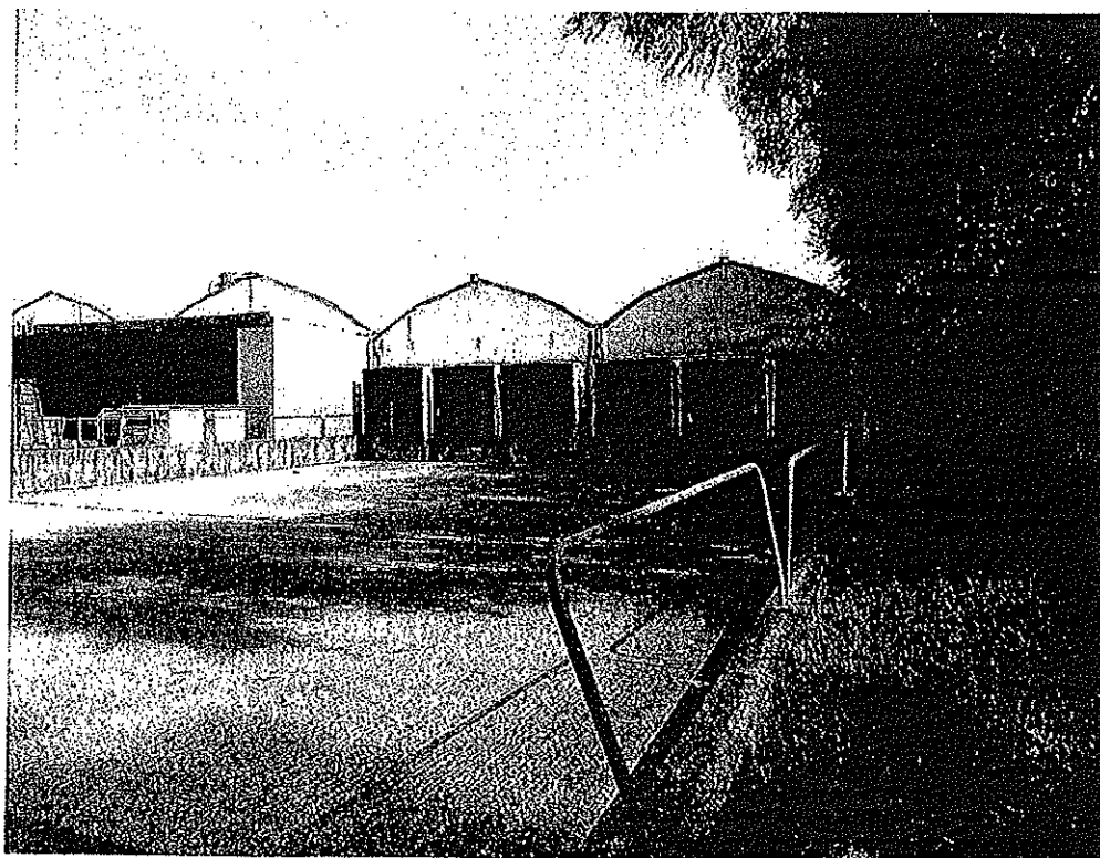
Foto n° 13 : Buche dl carico nel fronte Sud.
