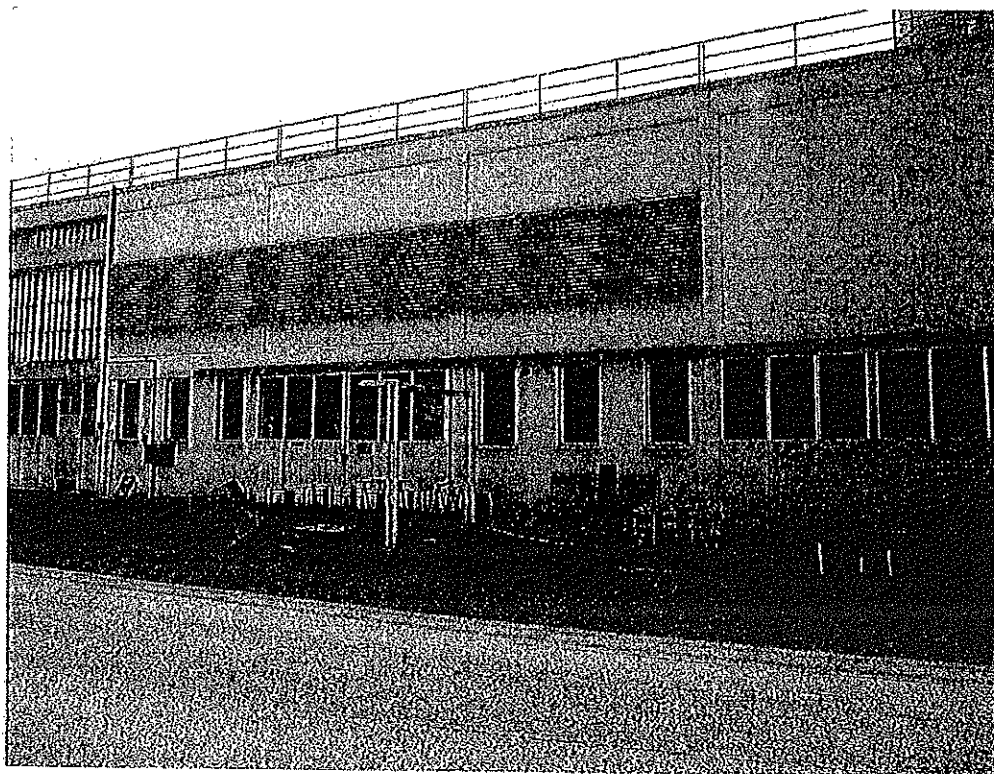
Foto n° 16 : Corpo fabbrica nel quale trova posto la C.T.
