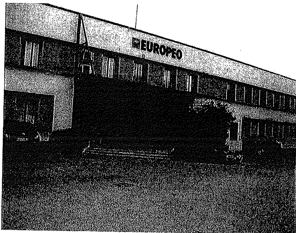
Foto n° 7 : Ingresso principale al corpo uffici.
