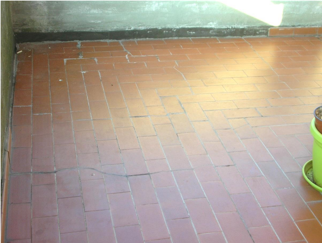
Esempio di fessurazioni pavimento terrazza
