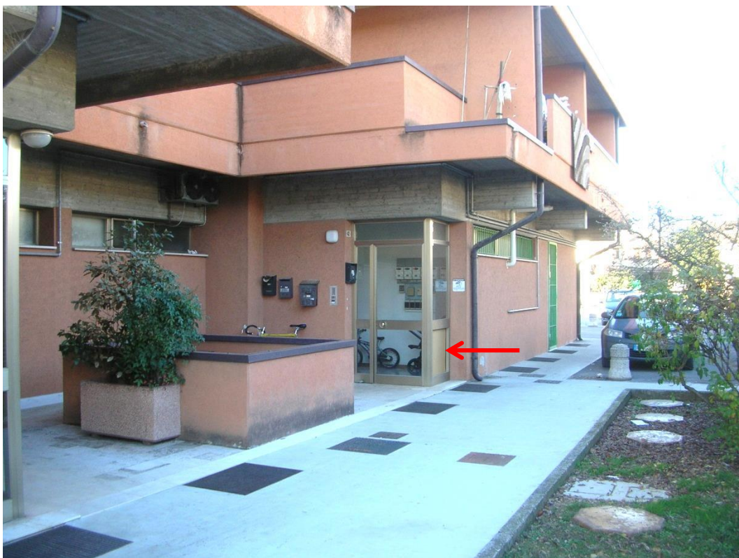
Ingresso vano scala civico 42 – vetro mancante nel sottoluce serramento
