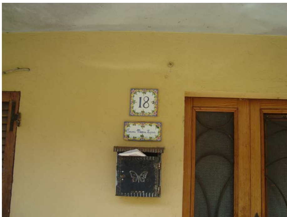
Foto n. 05: ingresso piano terra (civico 18)
