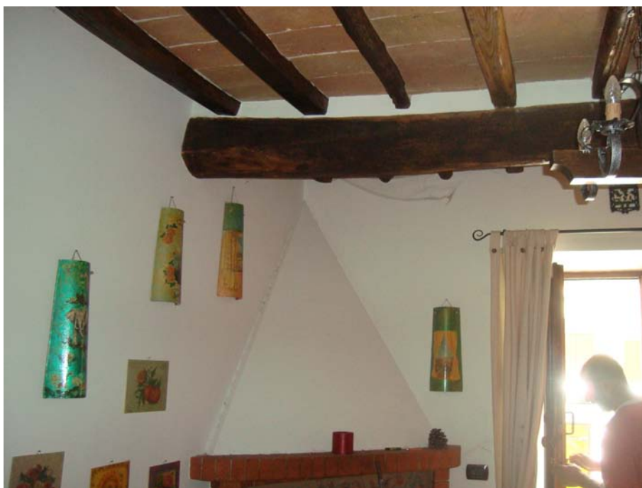
Foto n. 06: ingresso - soggiorno piano terra
