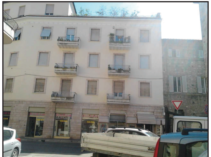
8- Vista laterale 3 prospetto Via L. Nobili
