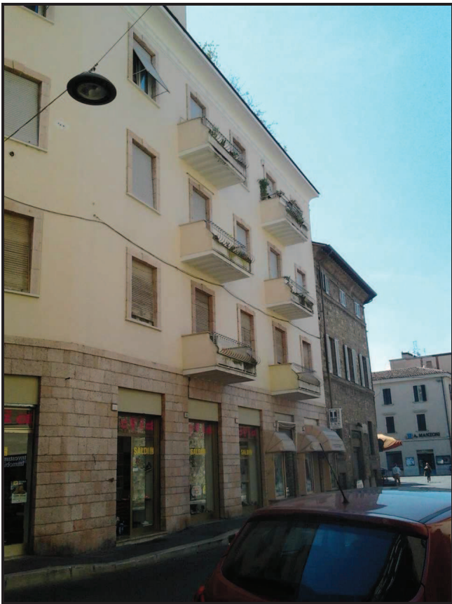
5- Vista laterale 2 prospetto Via L. Nobili
