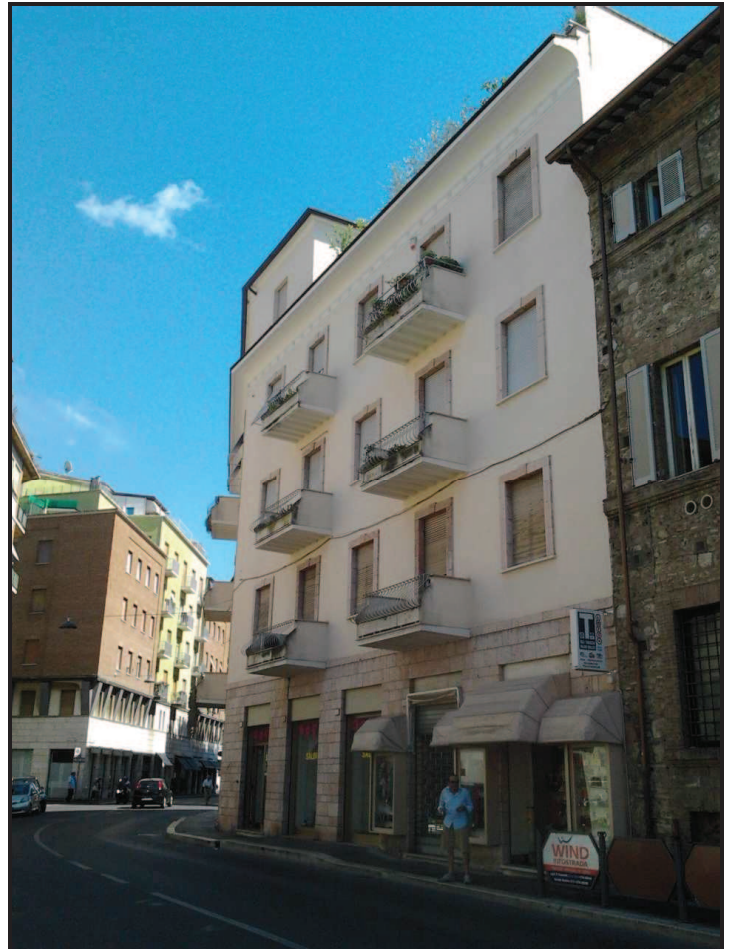
4- Vista laterale 1 prospetto Via L. Nobili
